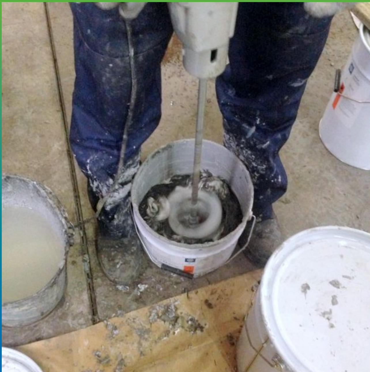
Замешивание клеевого состава Манопокс 331.
