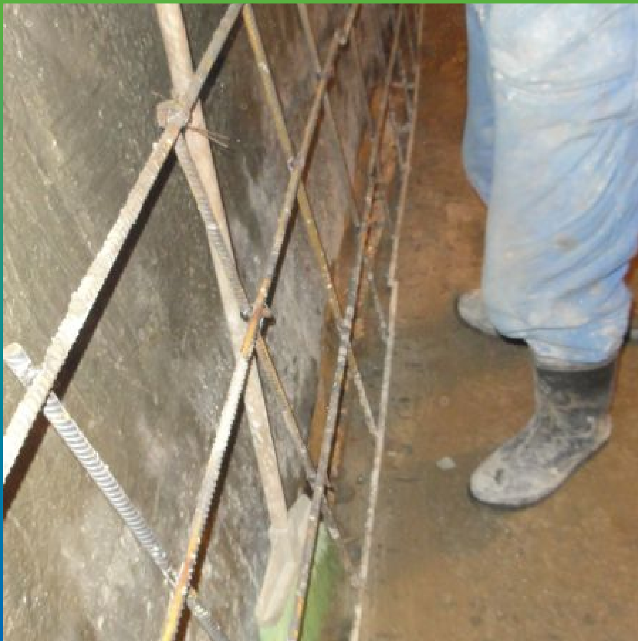
Очистка шва перед укладкой профиля
