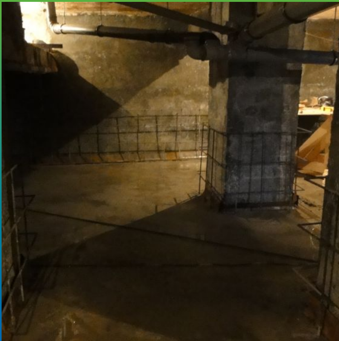
Вид объекта перед укладкой разбухающего профиля Манодил Свелл 2003
