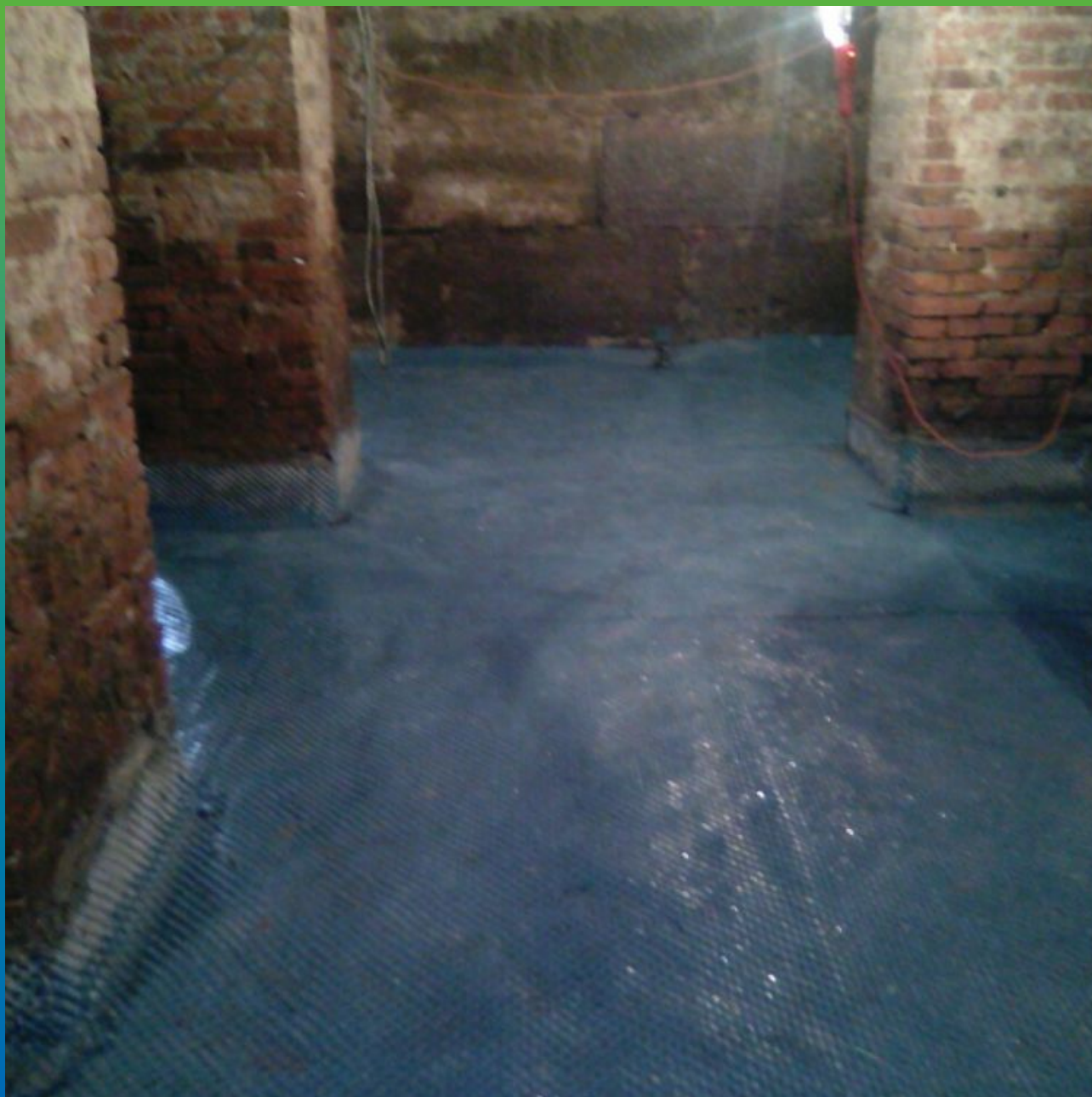
Укладка дренажного полотна Максдрейн 8
