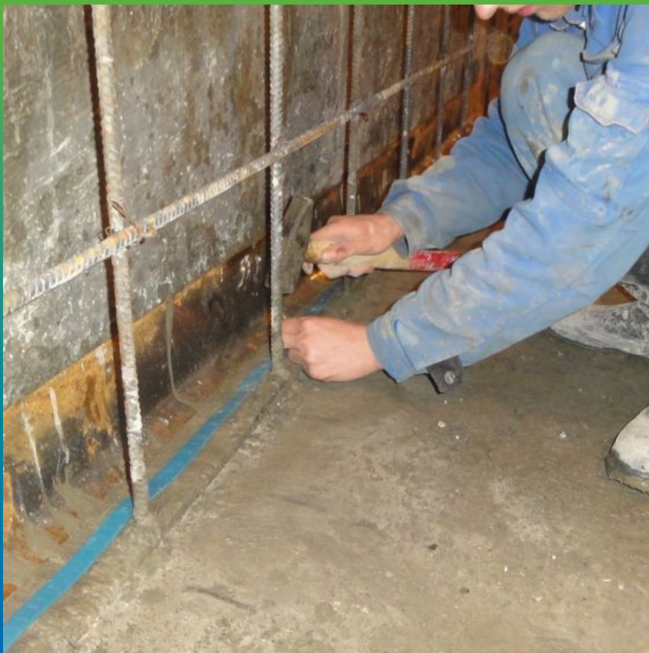
Монтаж разбухающего профиля Манодил Свелл 2003
