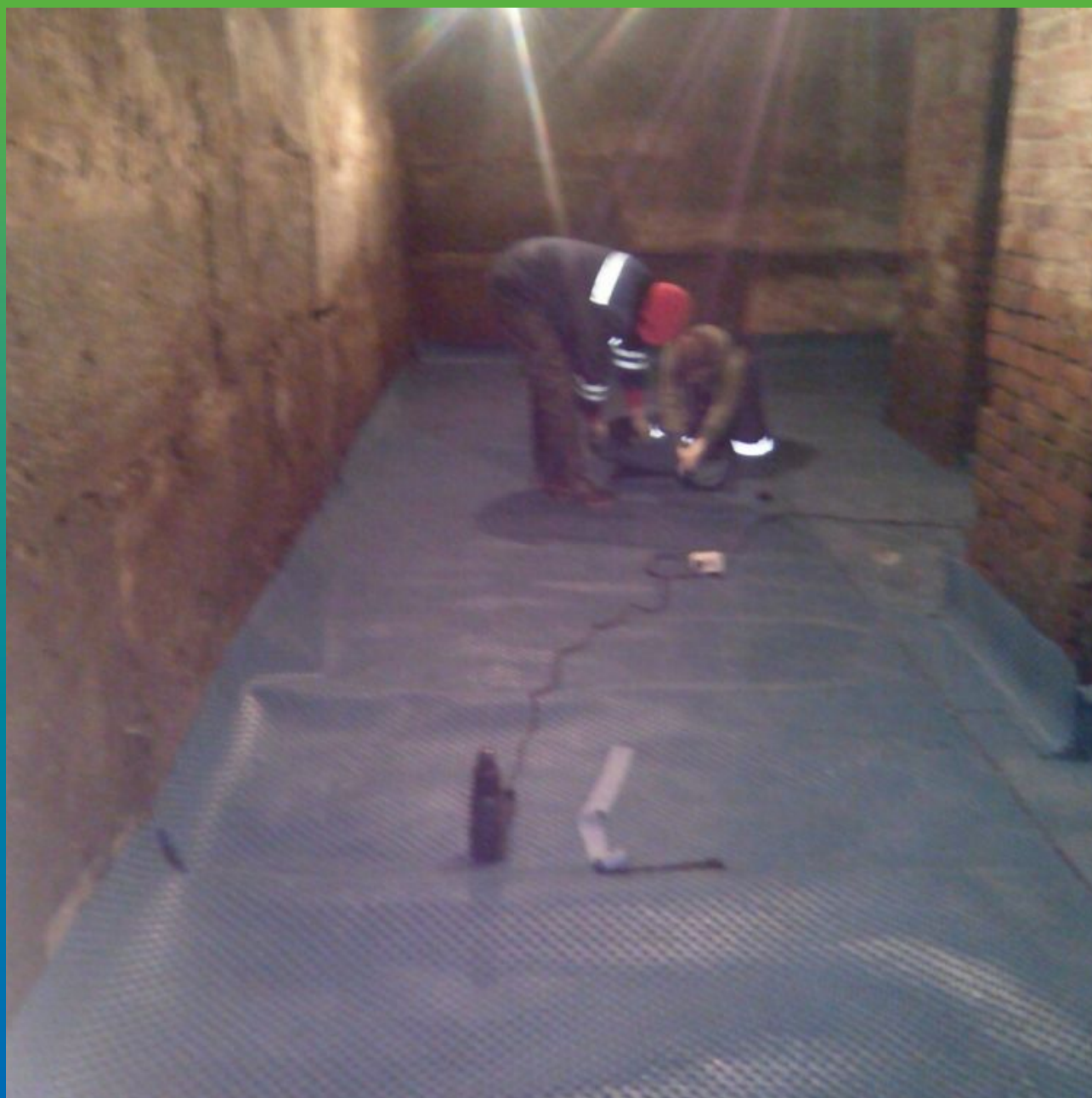
Укладка дренажного полотна Максдрейн 8
