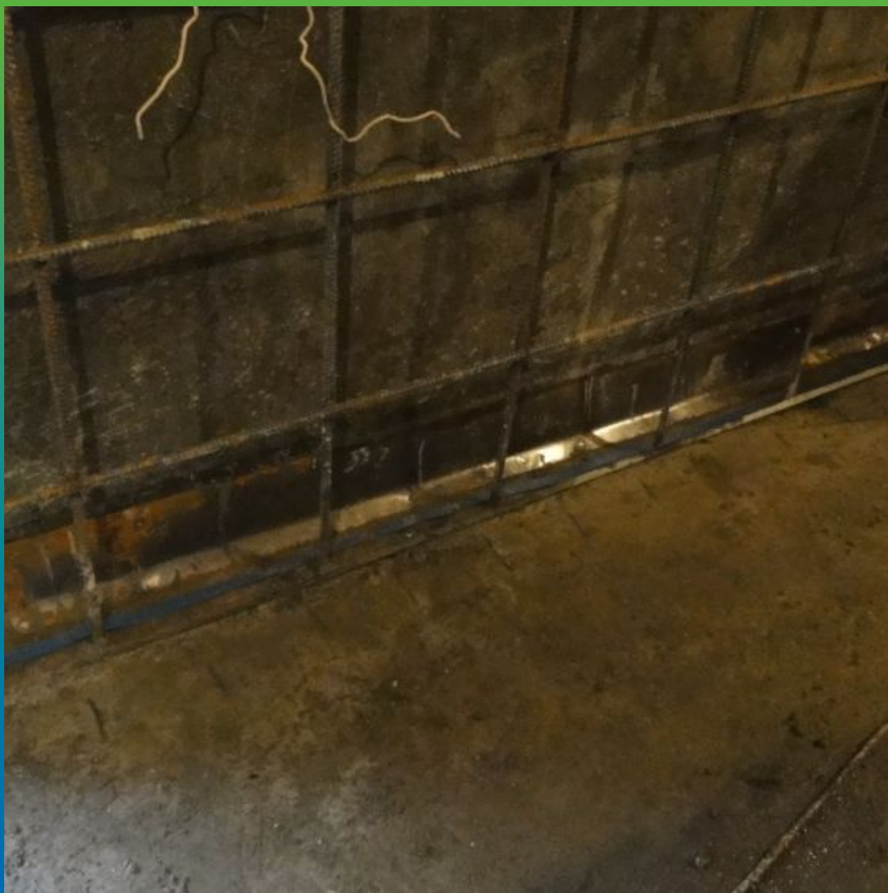
Вид уложенного профиля
