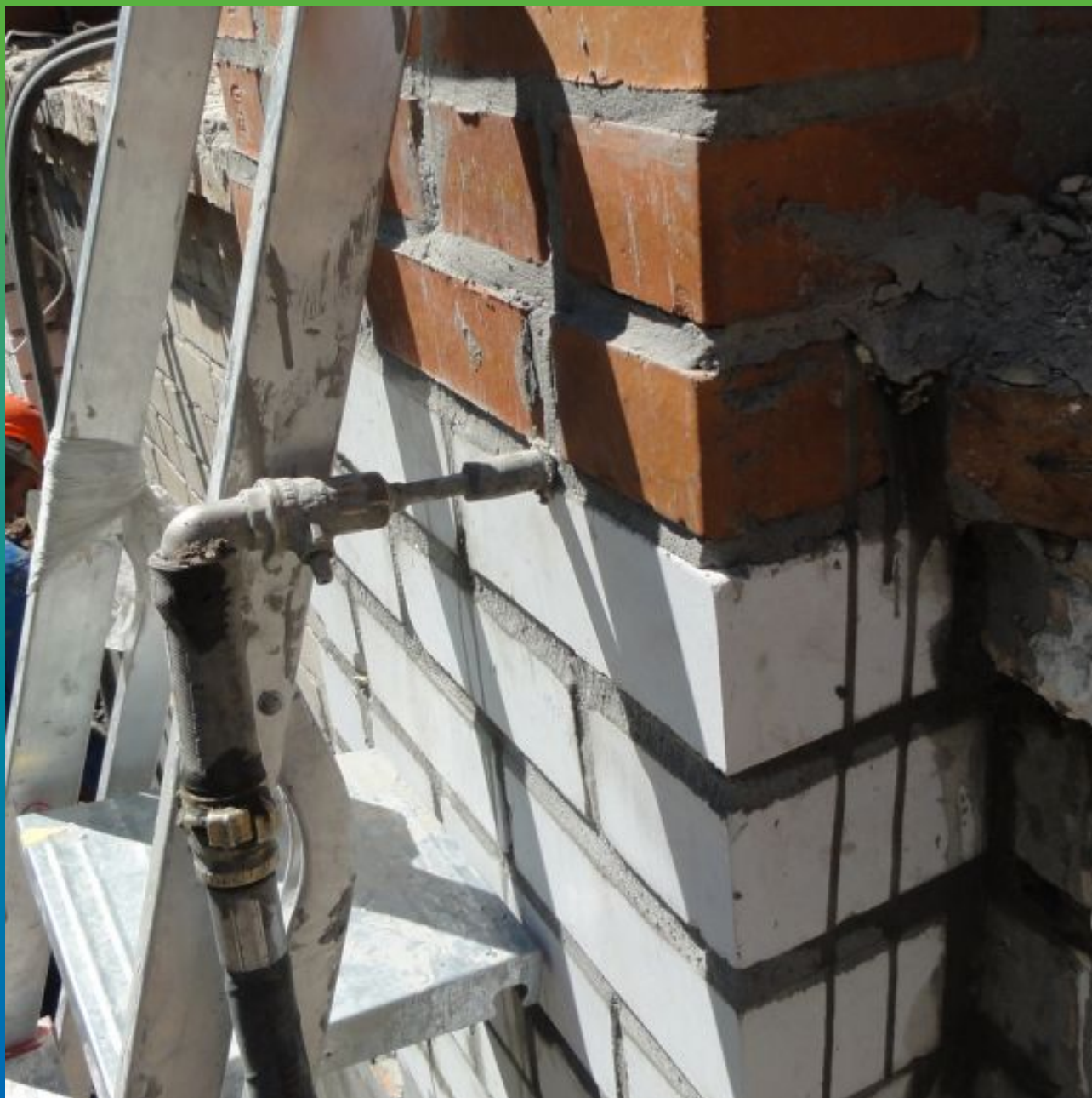
Инъектирование Маноцем Гроут в кирпичную кладку
