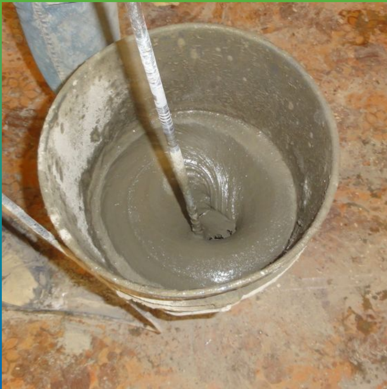
Перемешивание материала Маноцем гроут перед инъектированием
