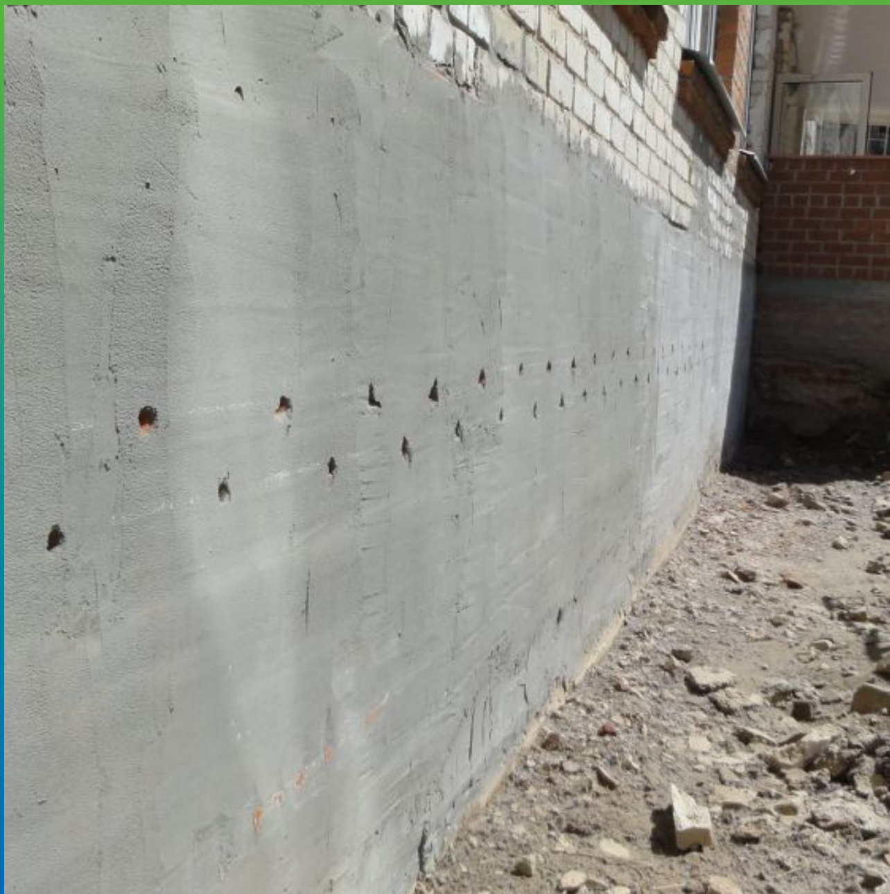
Подготовленные шпury под закачку Маноцем Гроут
