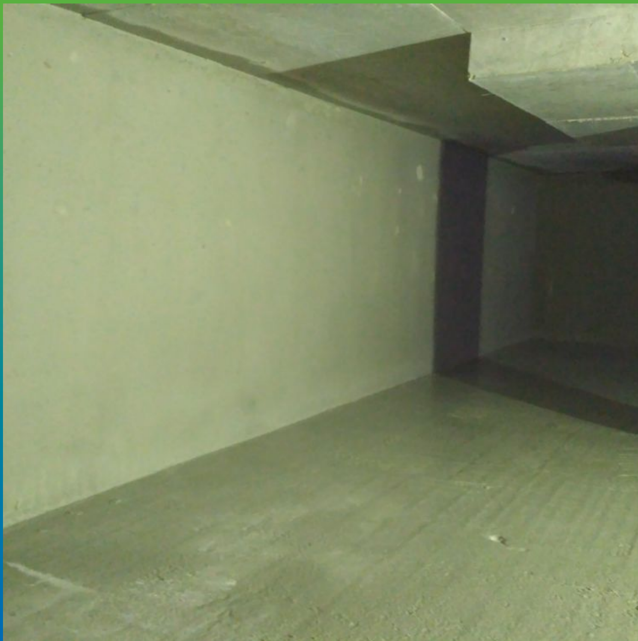
Вид объекта после нанесения Макссил Супер
