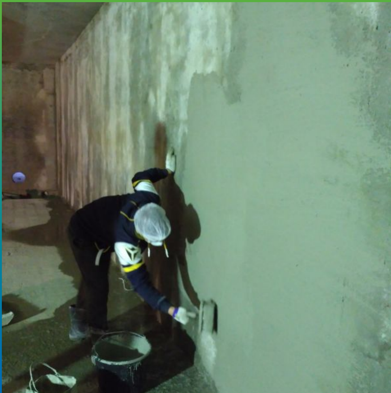
Нанесение Максил Супер на поверхности стен резервуара
