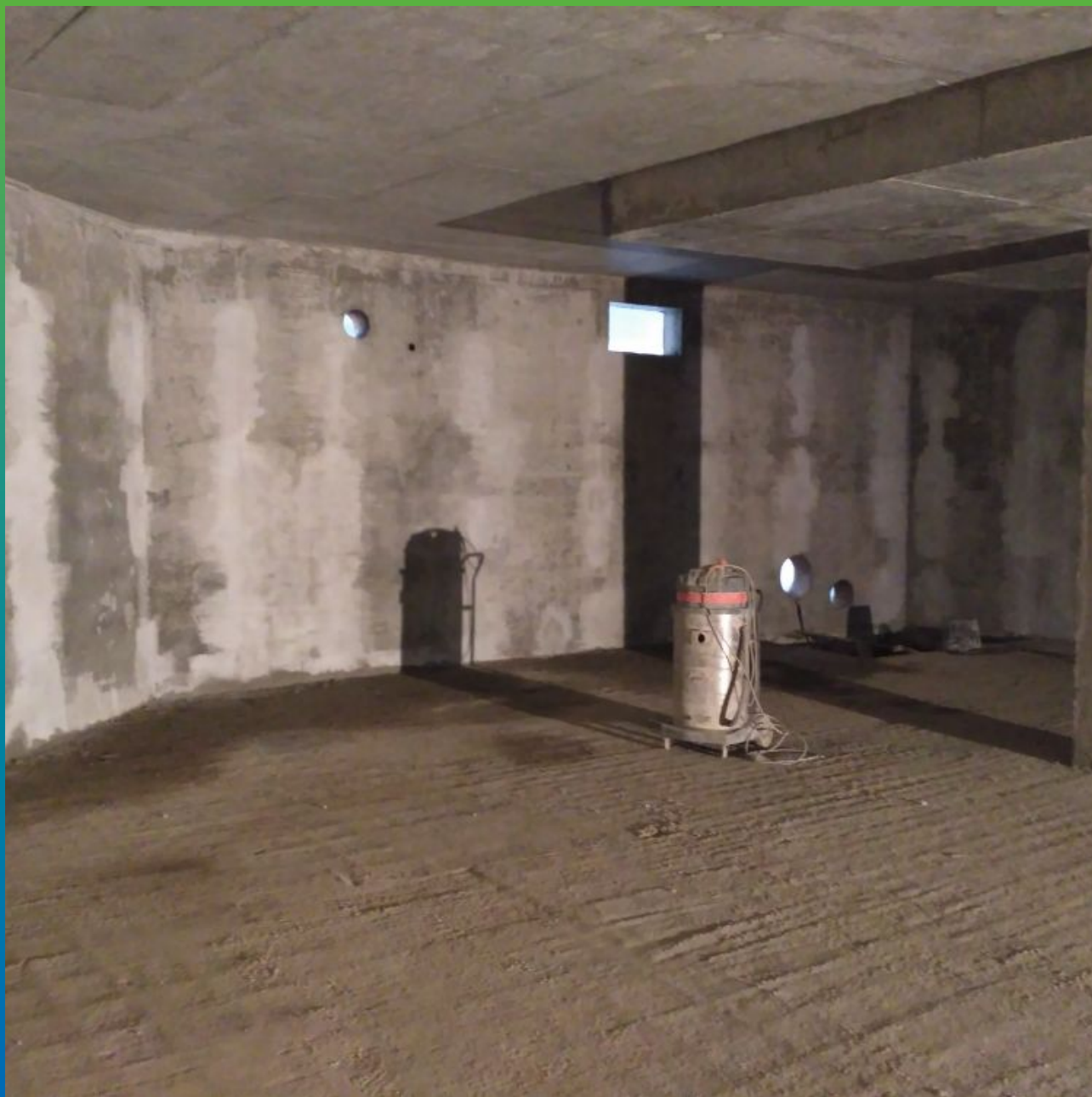
Вид резервуара изнутри с подготовленной поверхностью под нанесение материала Макссил Супер
