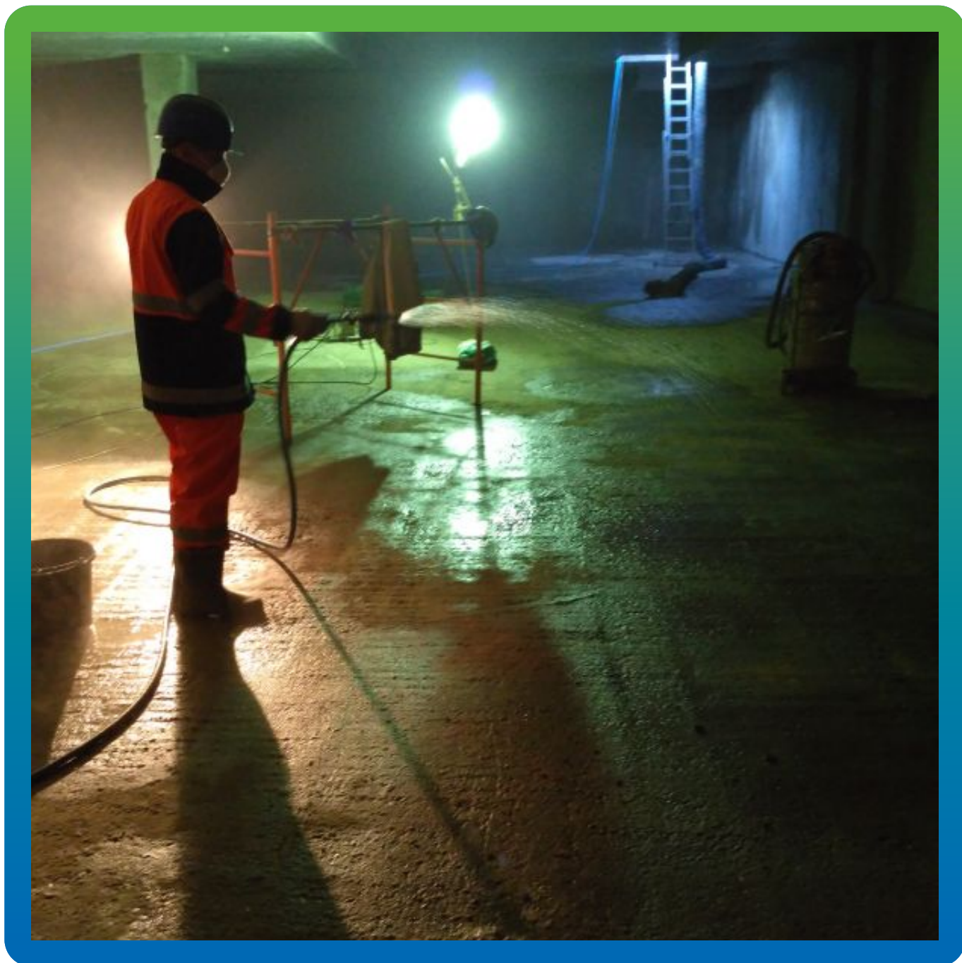
Увлажнение поверхности дна резервуара перед нанесением Максил Супер
