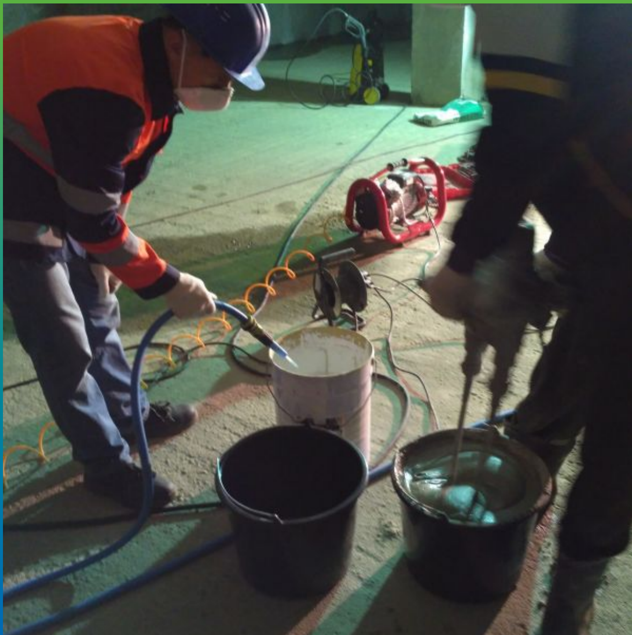
Приготовление материала Максил Супер
