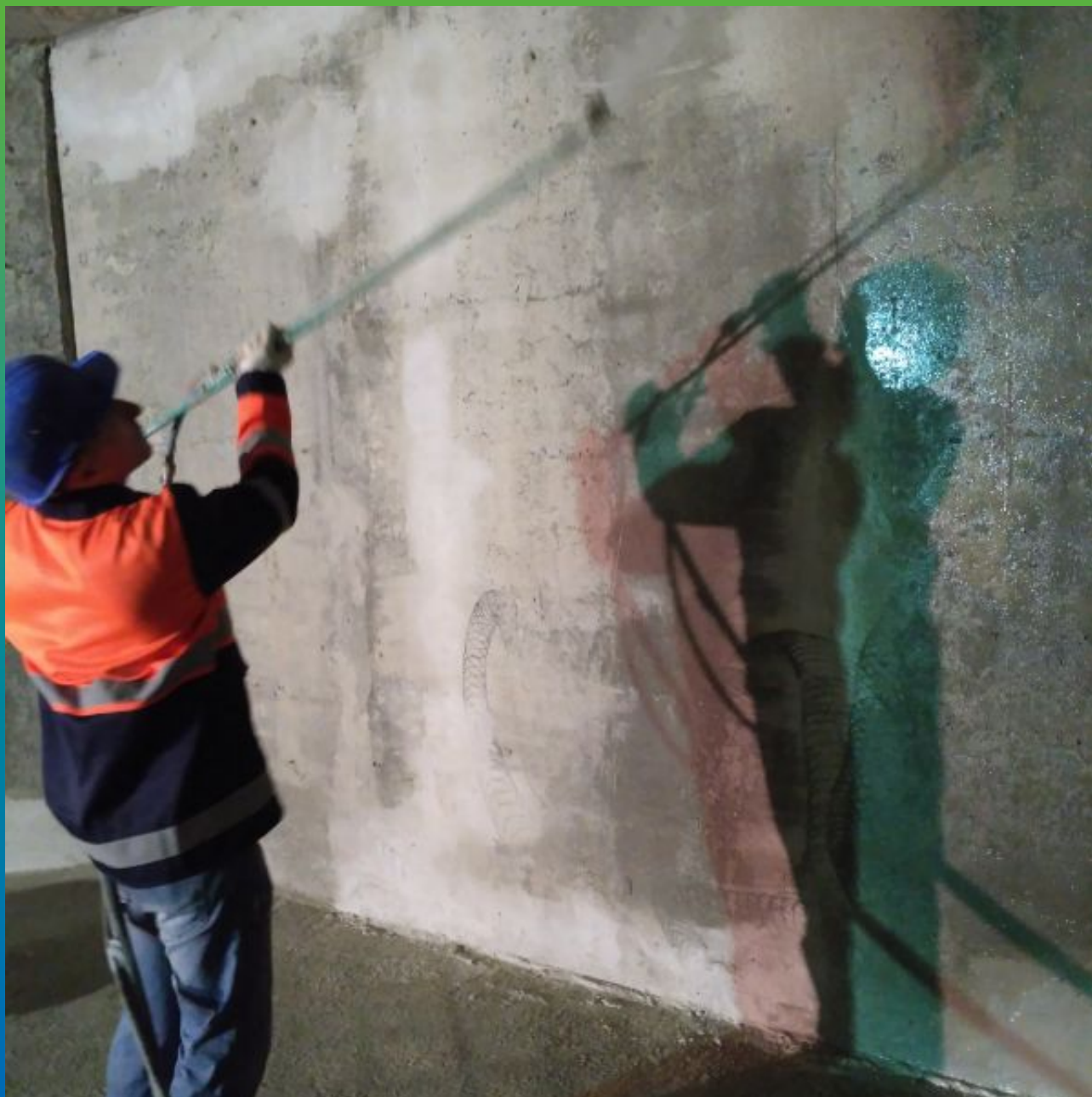
Увлажнение поверхности стен резервуара перед нанесением Максил Супер
