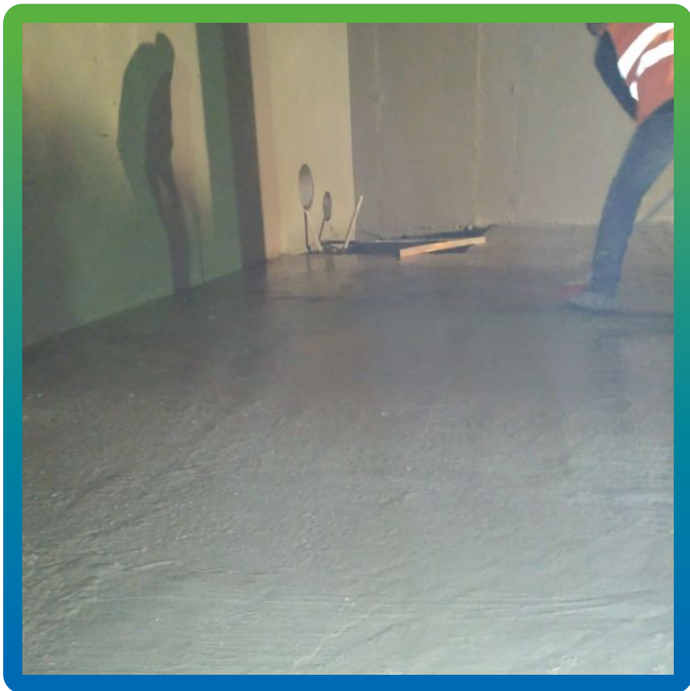
Нанесение Максил Супер на дно резервуара
