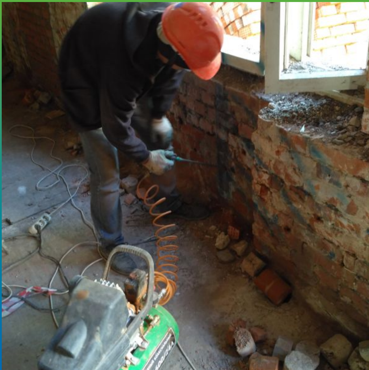
Продувка шпуров перед монтажом инъекторов
