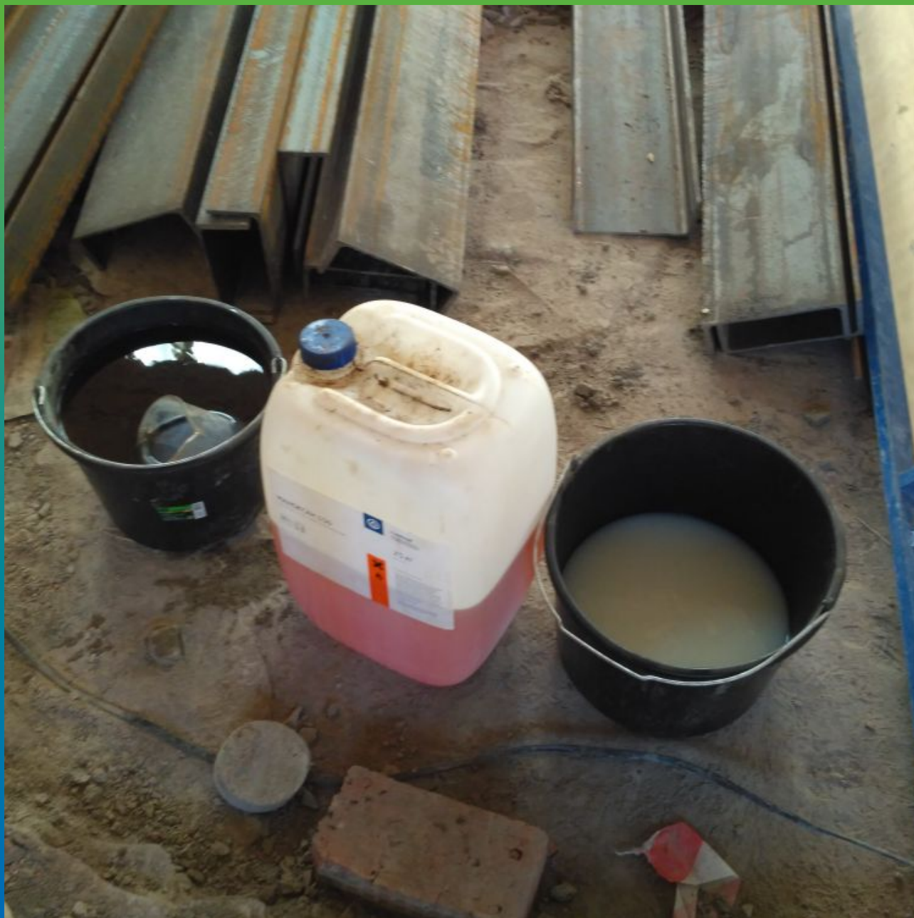
Приготовление Маноксан 150 перед инъектированием
