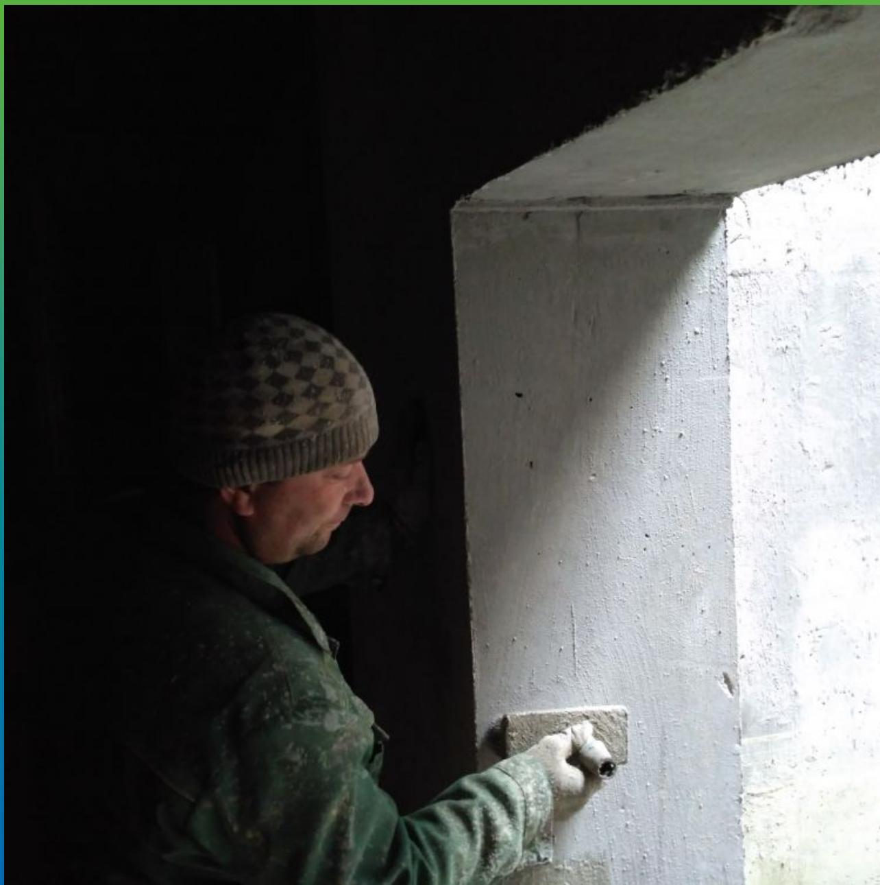
Нанесение материала Максил Супер
