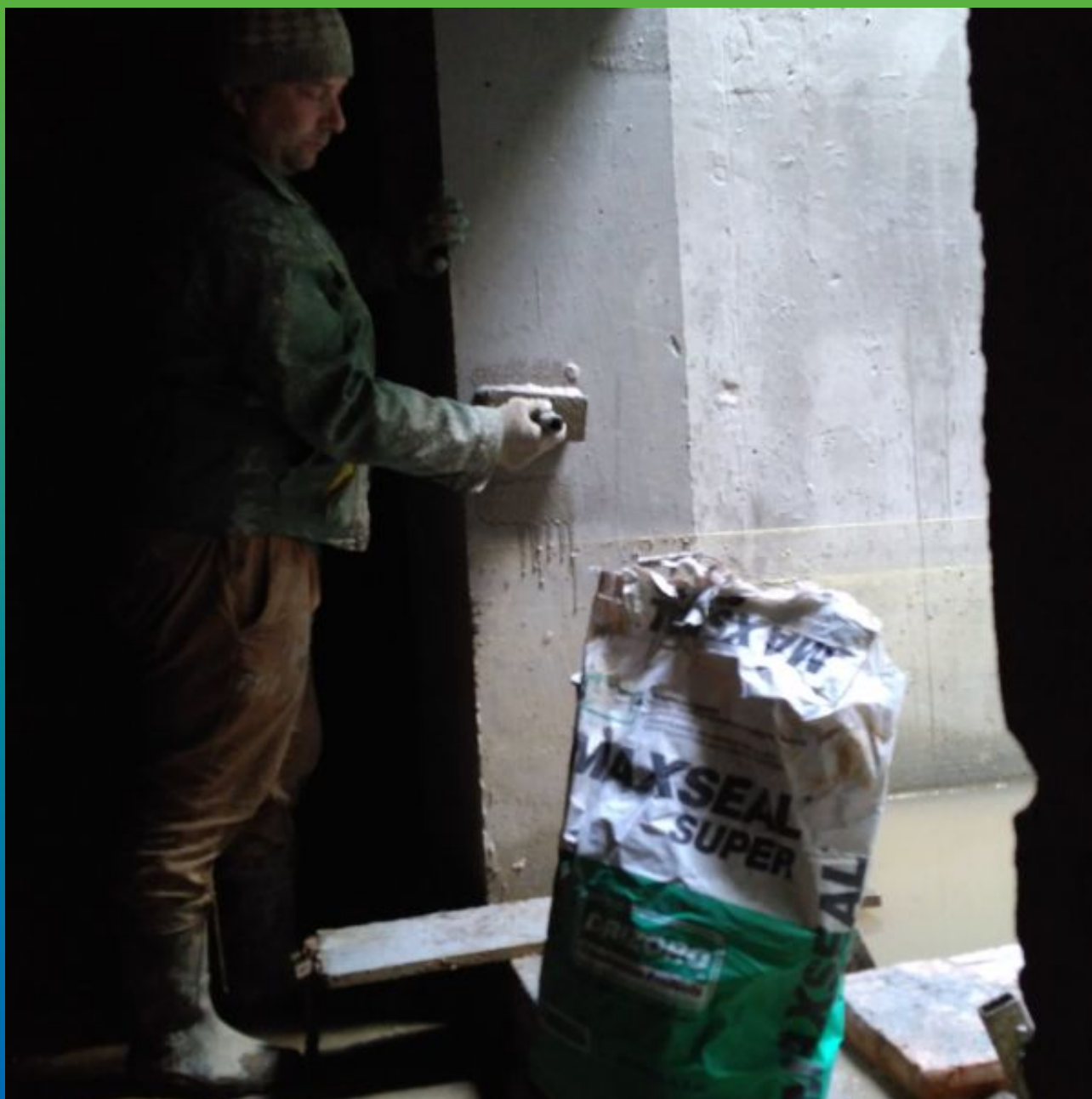
Нанесение материала Макссил Супер
