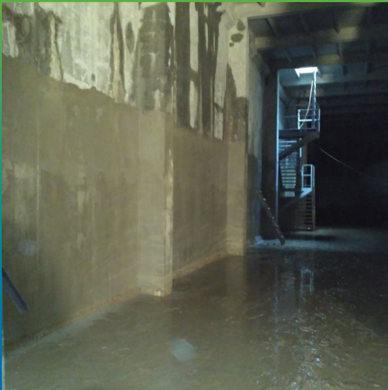
Вид после нанесения на поверхность стен емкости Максил Супер
