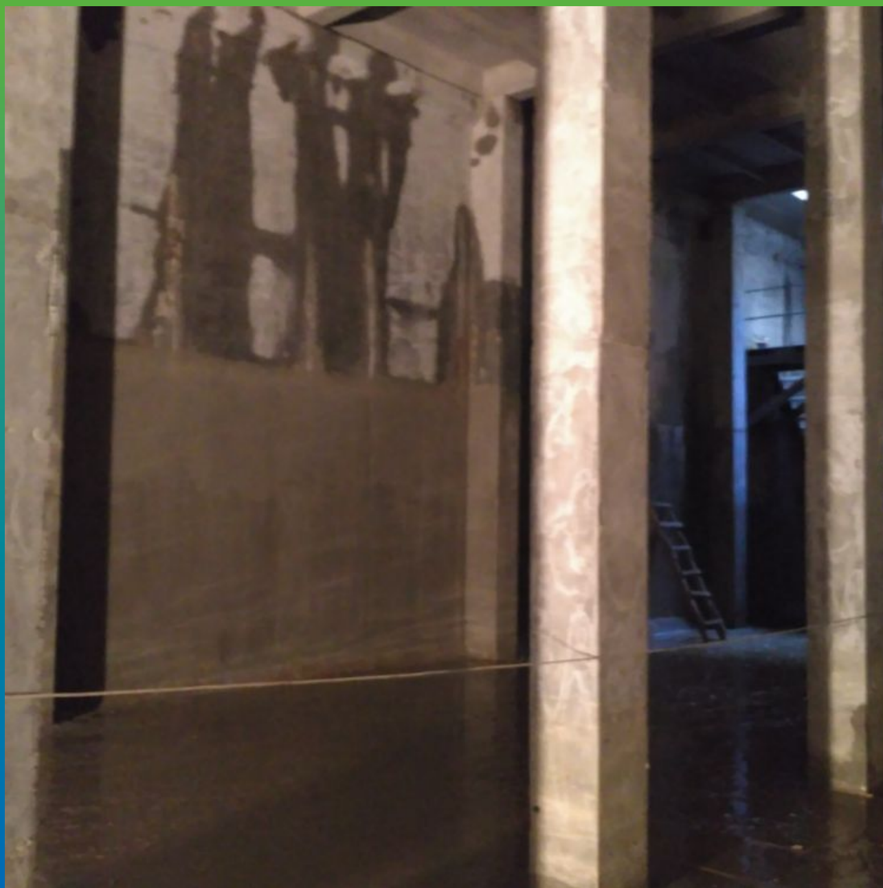
Вид после нанесения на поверхность стен емкости Макссил Супер
