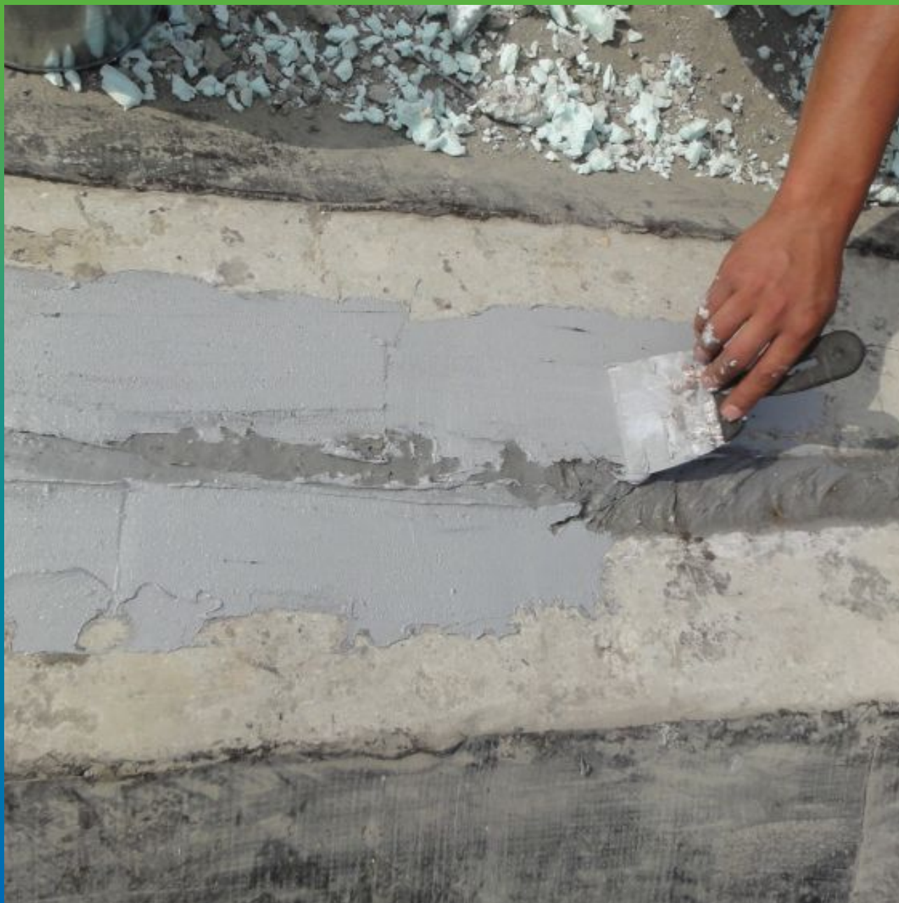
Нанесение первого слоя Манопокс 331
