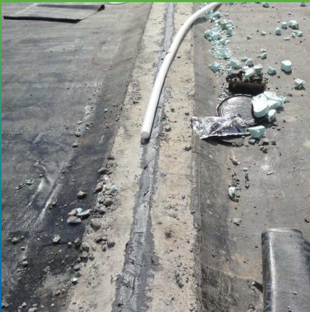
Первоначальный вид деформационного шва
