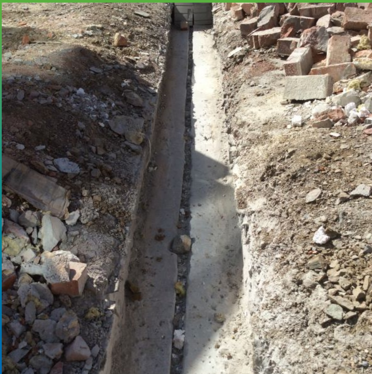
Первоначальный вид деформационного шва
