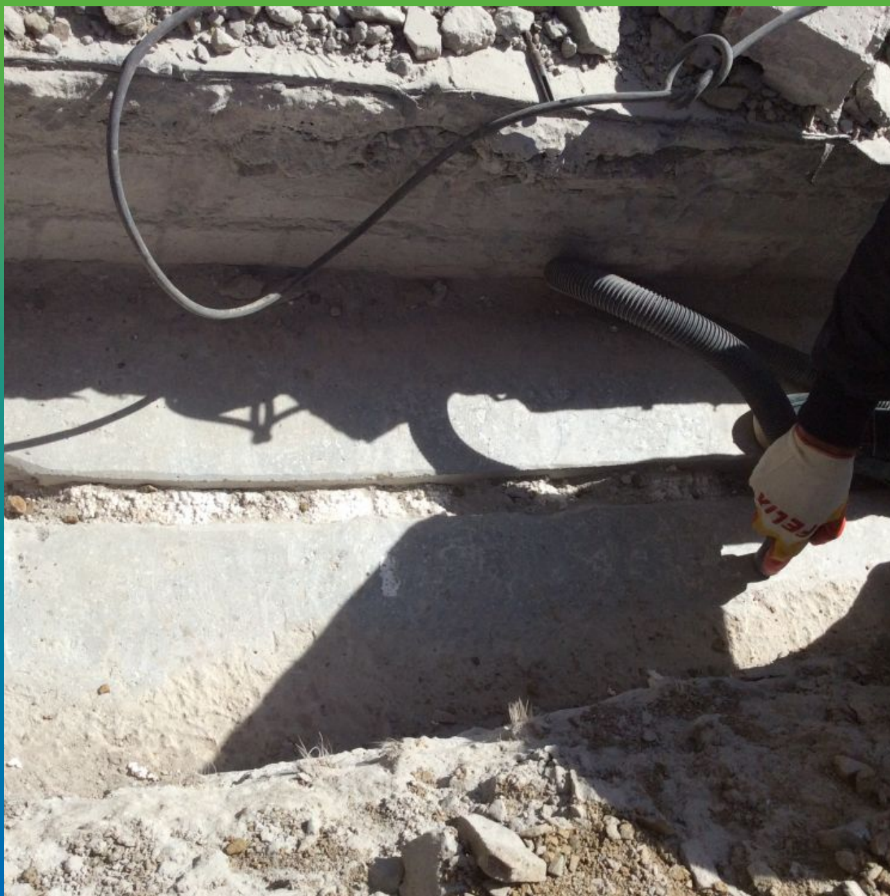
Подготовка - обеспыливание шва
