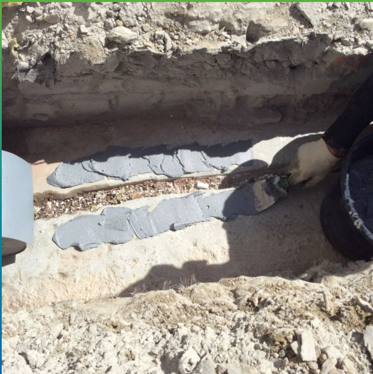
Нанесение первого слоя Манопокс 331 на края шва
