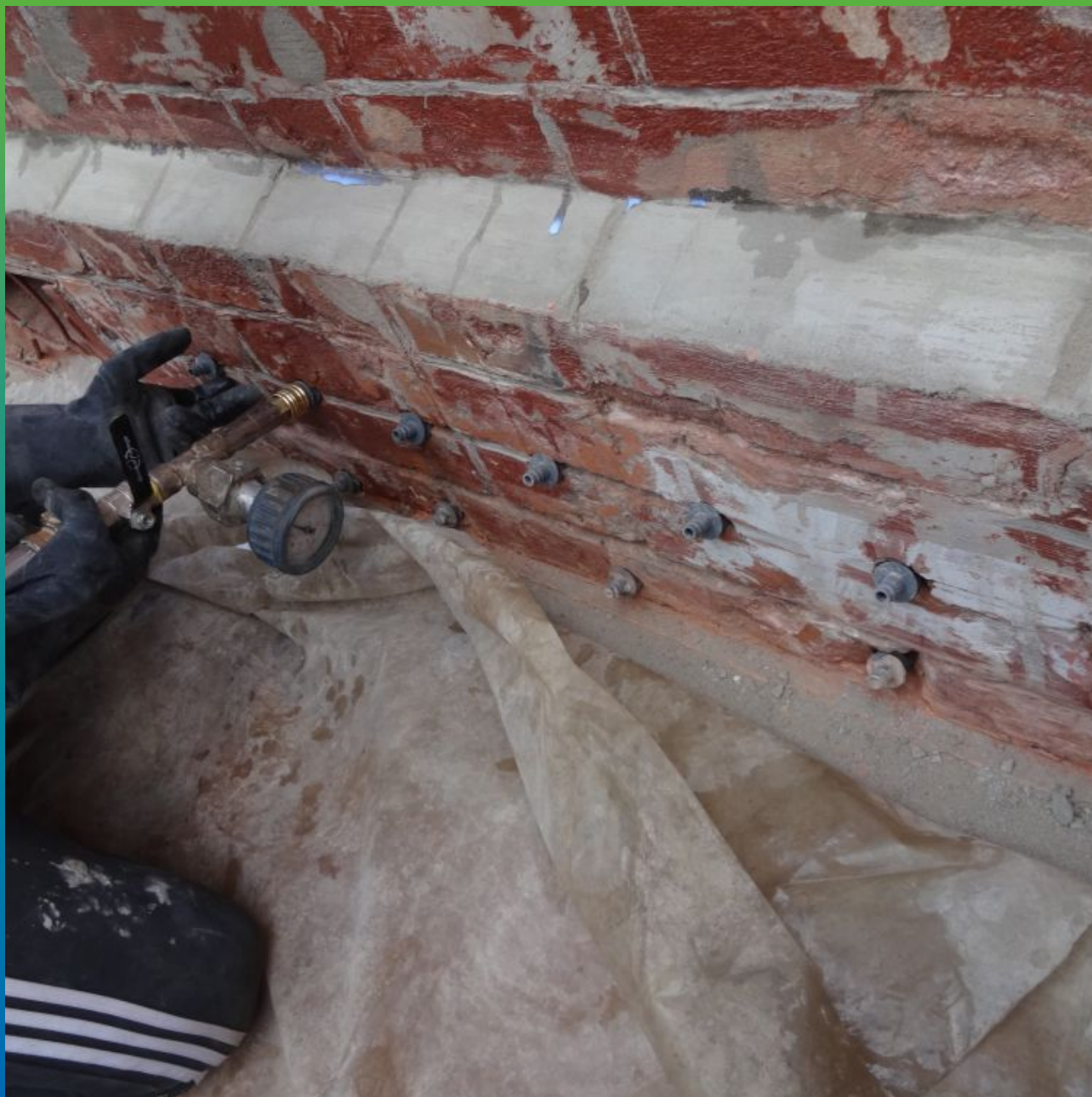
Инъектирование в кирпичную кладку инъекционного материала "Максклип Инжекшн"
