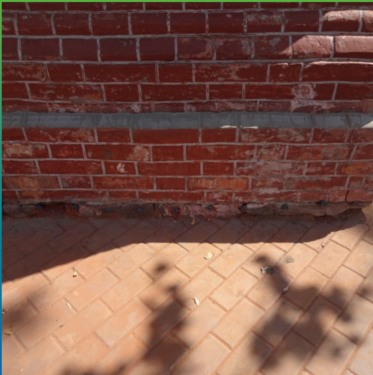
Установка пакеров БМ 2830
