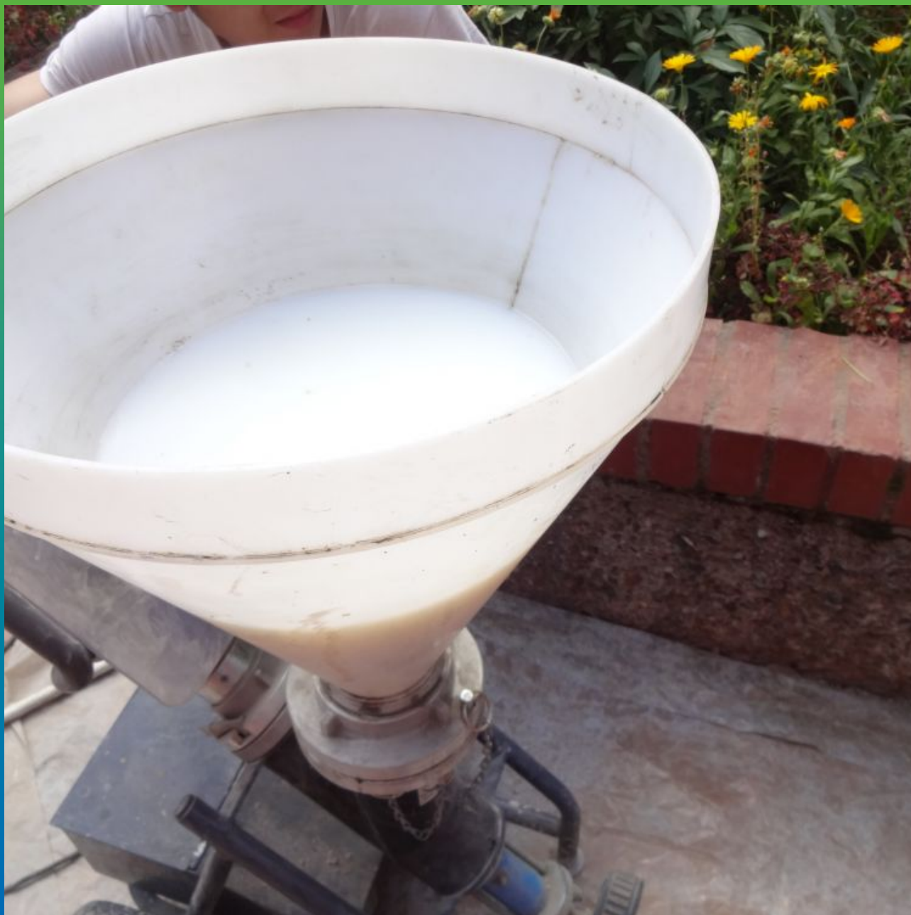
Затворение с водой инъекционного материала "Максклир Инжекшн" в пропорции 1:16 в насосе БМП 6
