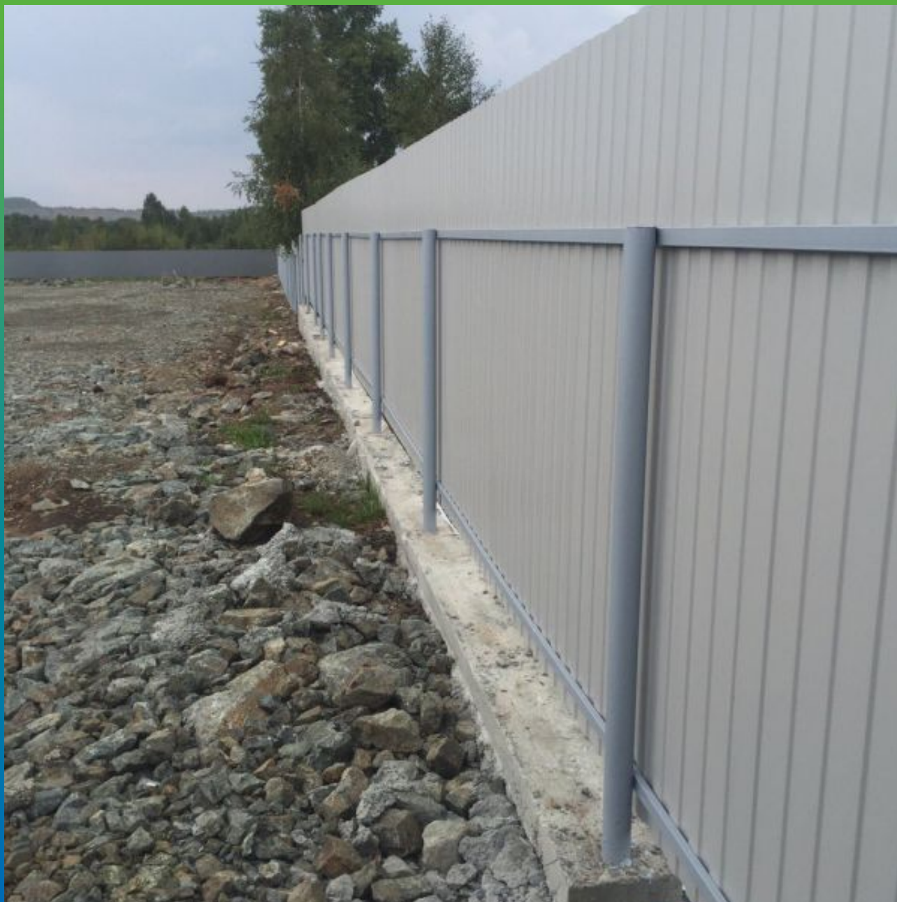
Вид конструкции после выполнения работ по защите металлических поверхностей
