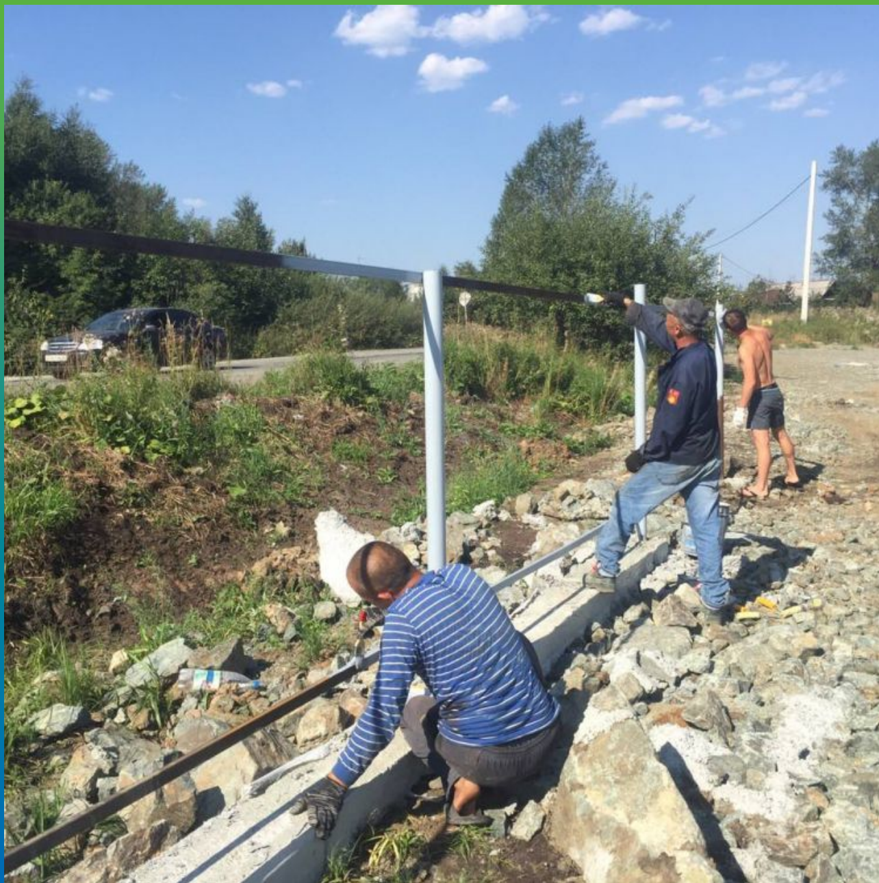
Процесс нанесения защитного покрытия ДенТоп ПУ 302 на металлические поверхности
