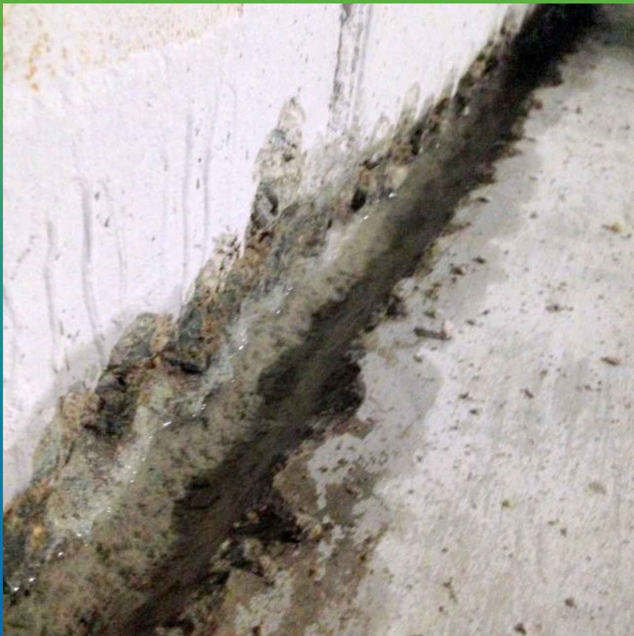
Создание штрабы для последующей заделки. Вид стена-пол.
