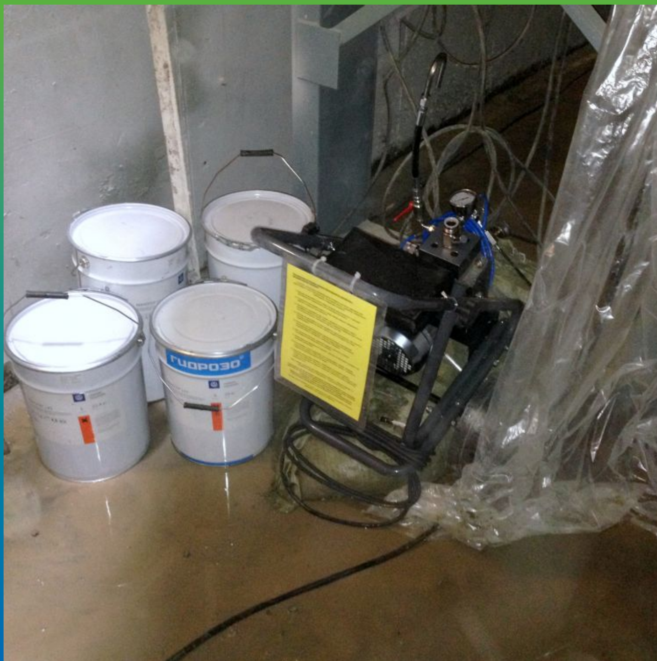
Подготовка оборудования. Насос БМ 1200.
