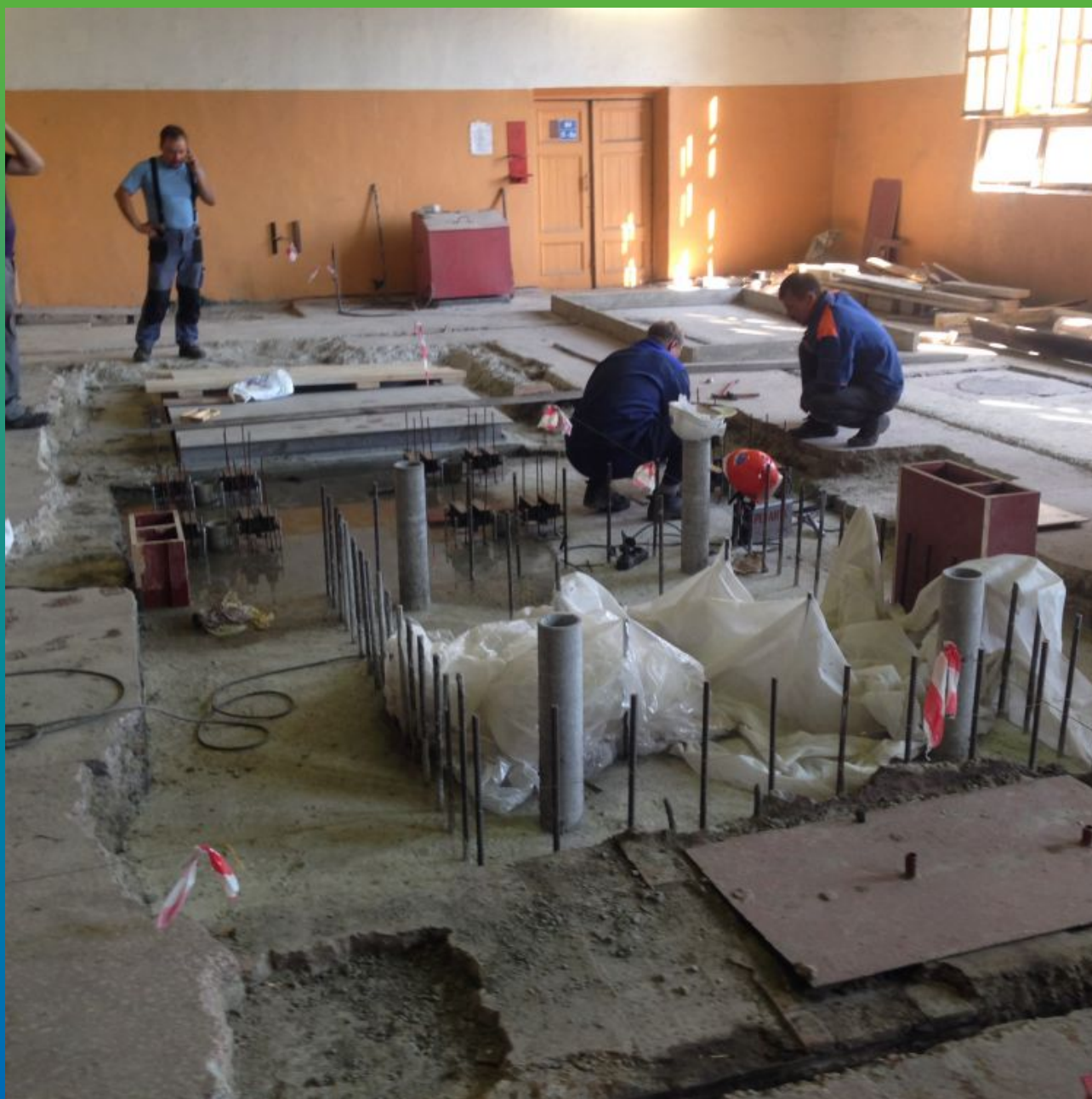
Объект. Вид на площадку.
