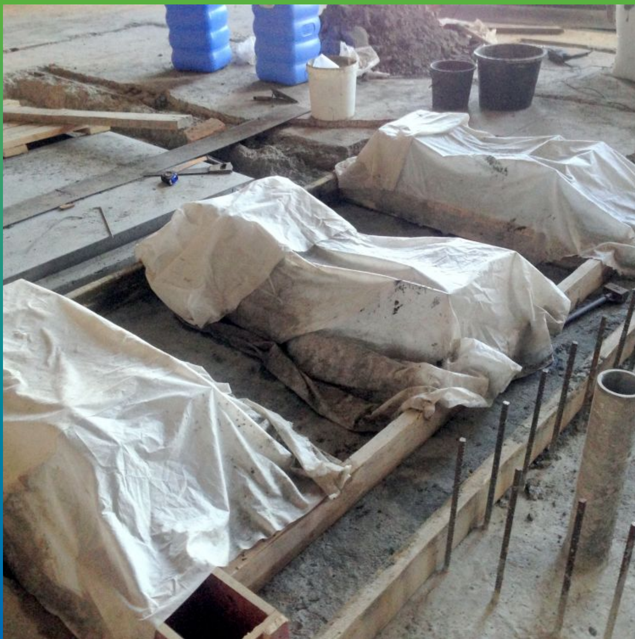
Укрытие смоченным водой материалом для правильного процесса схватывания.
