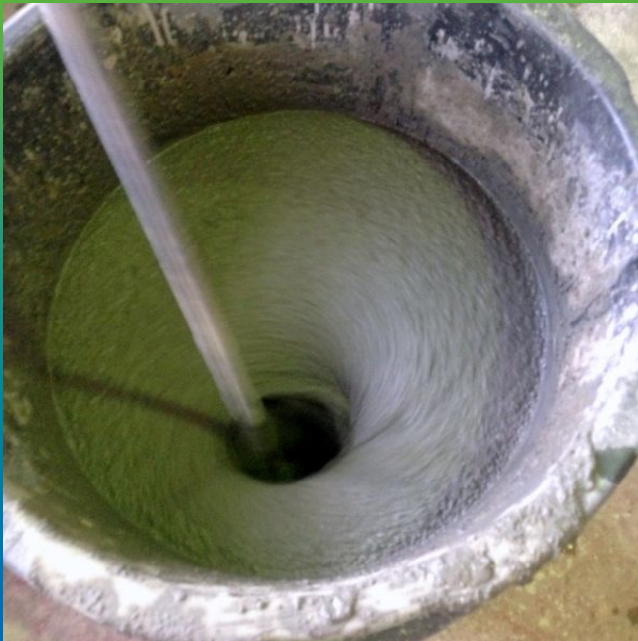
Процесс замешивания миксером 300-500 об/мин.
