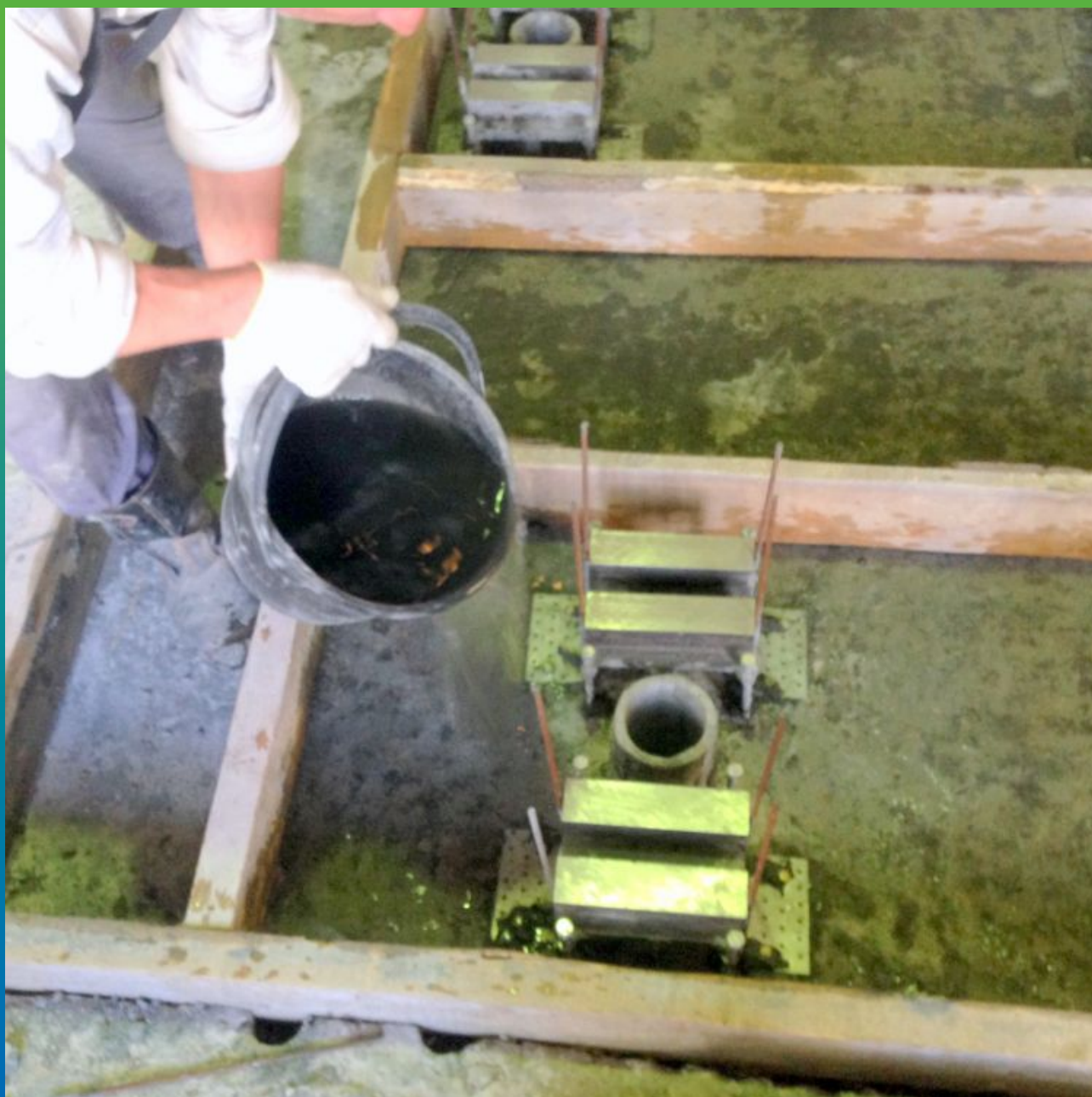
Пропитка основания водой.
