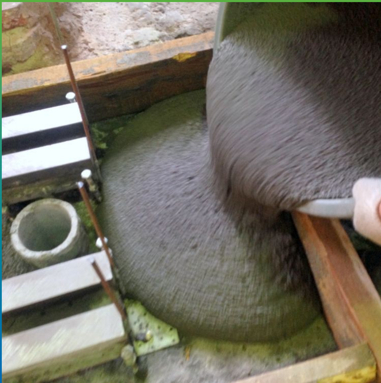
Заливка готовой смеси.
