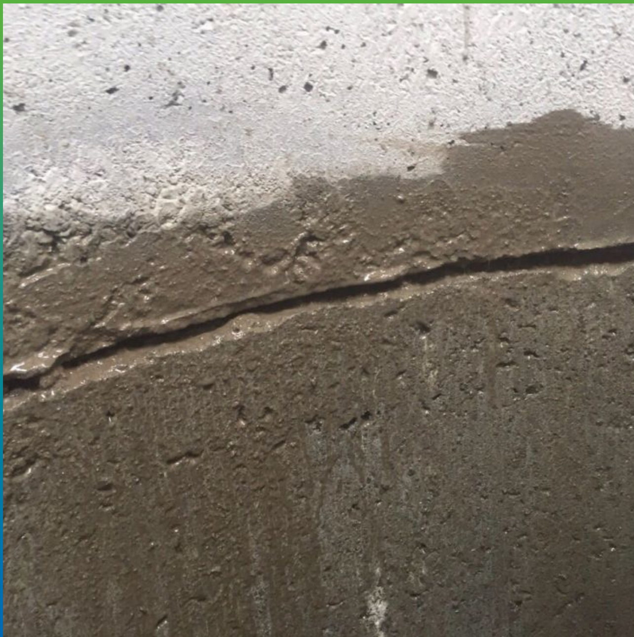
Грунтование шва разведенным до жидкой консистенции Стармекс РМ3.
