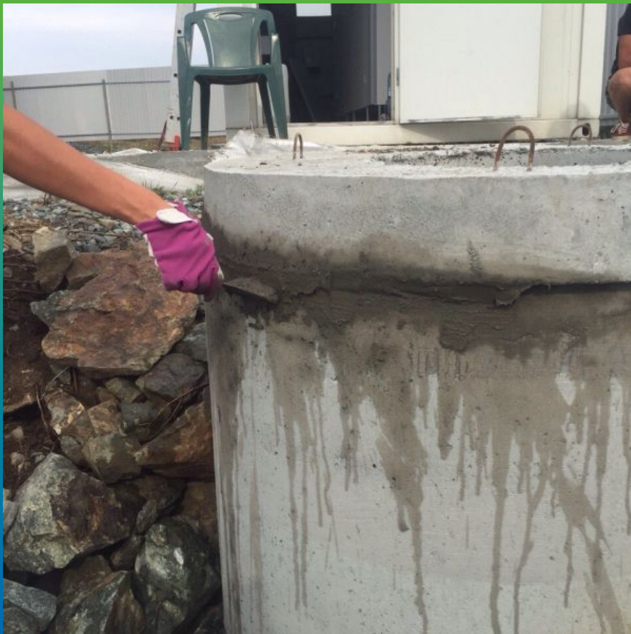
Заделка наружного шва (стенка-крышка).
