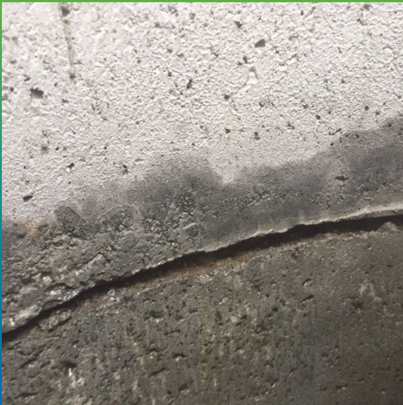
Очищение и пропитка шва ж/б водой.
