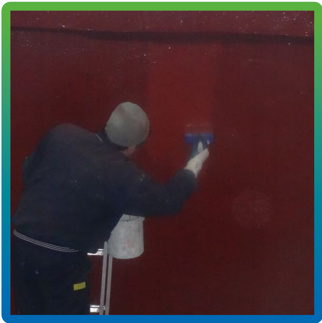
Нанесение Максэластик ПУР на стены конструкции
