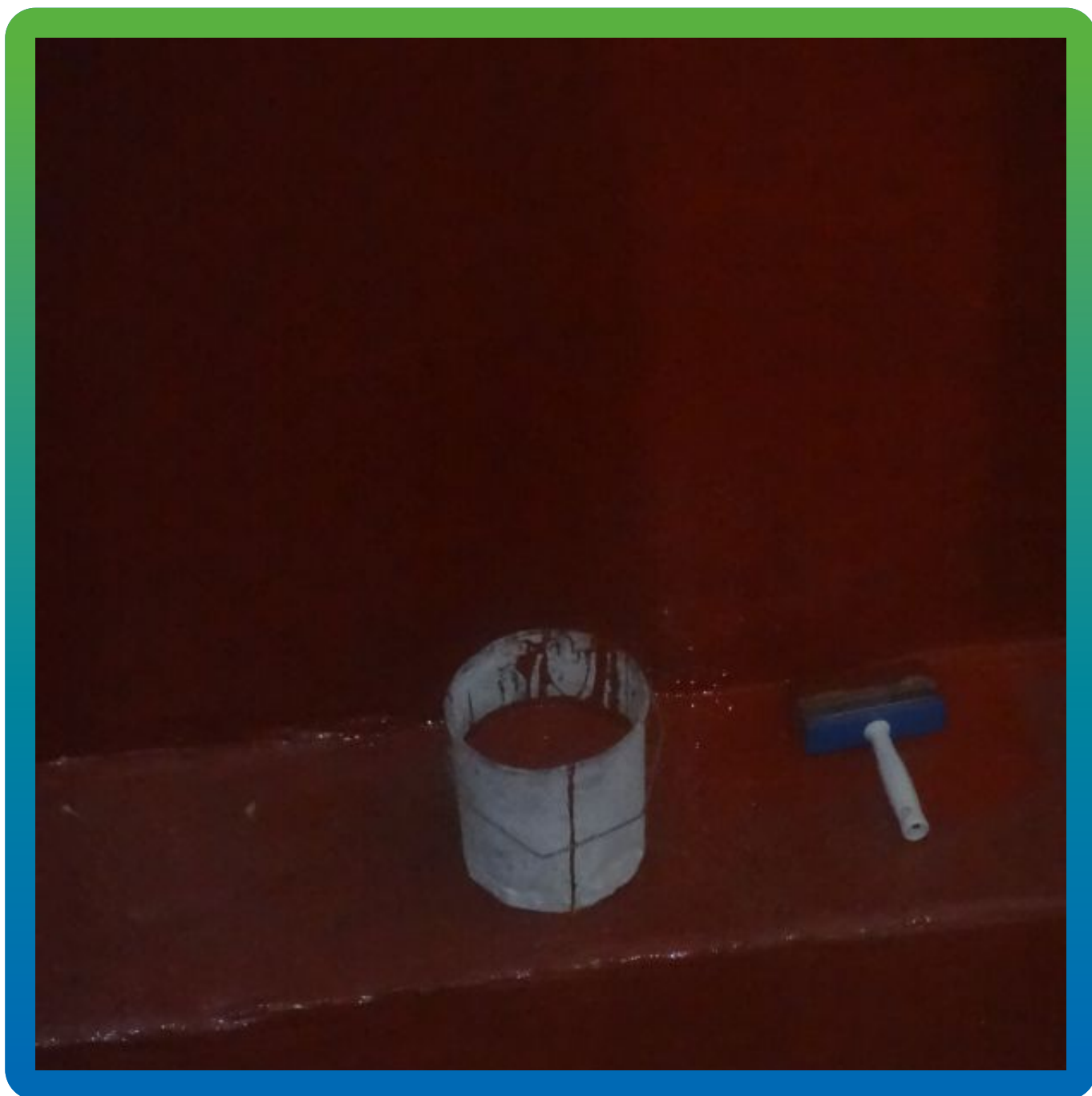
Вид объекта после проведения работ
