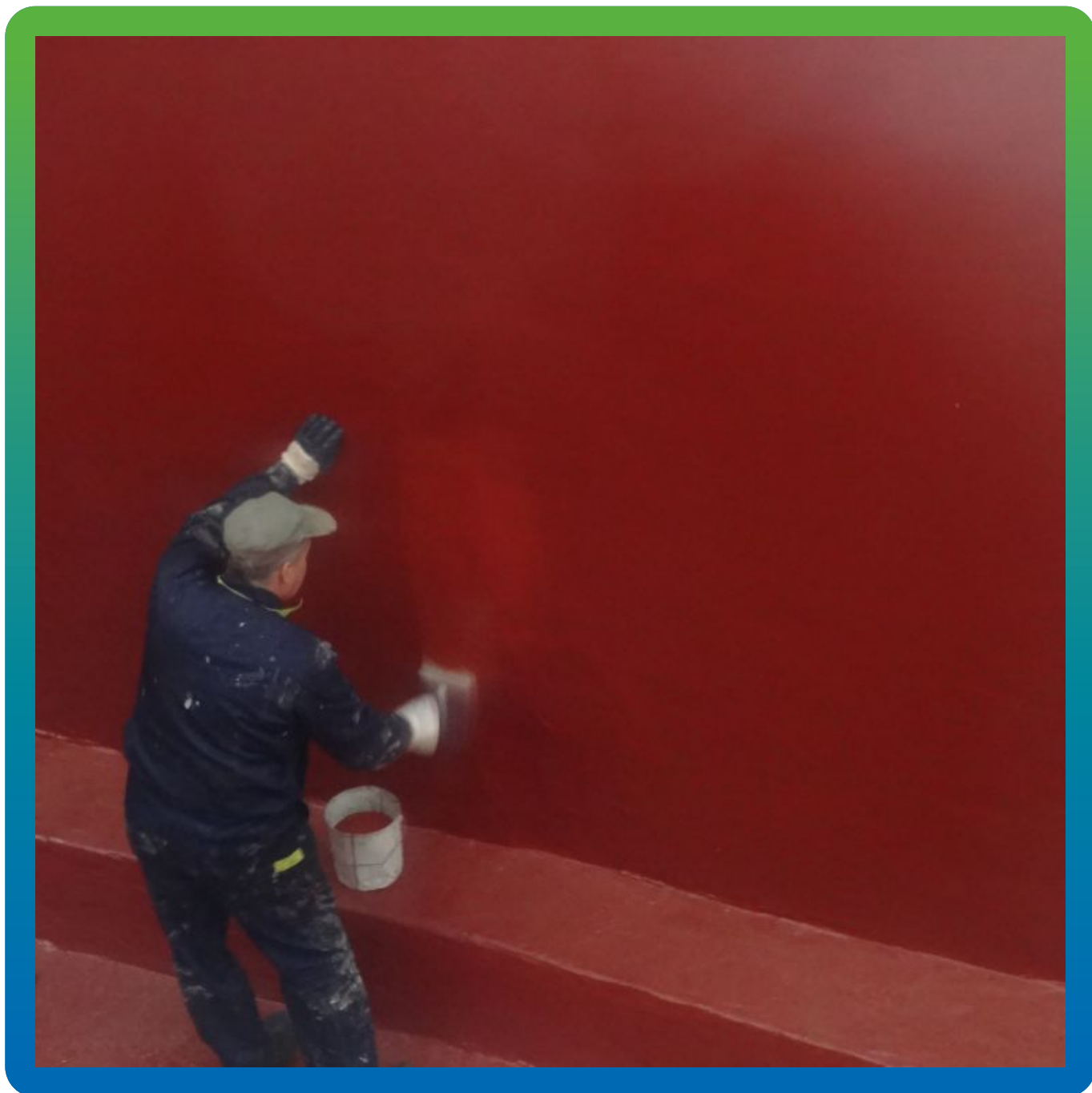
Нанесение Максэластик ПУР на стены конструкции
