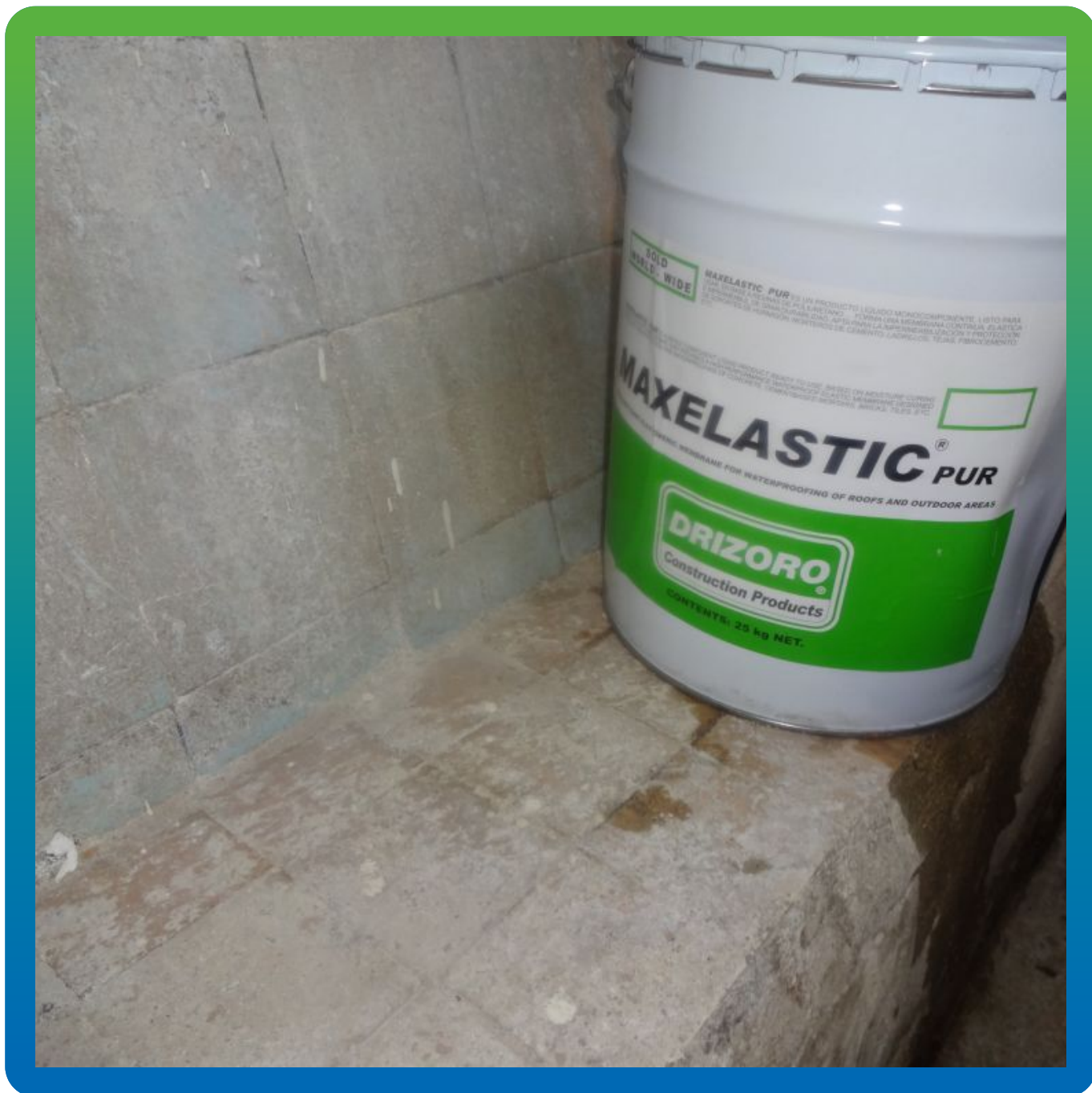
Материалы "Гидрозо" на объекте
