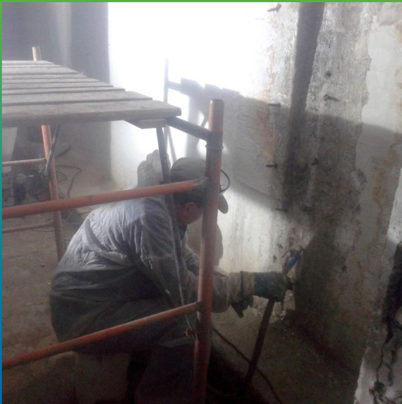
Процесс инъектирования
