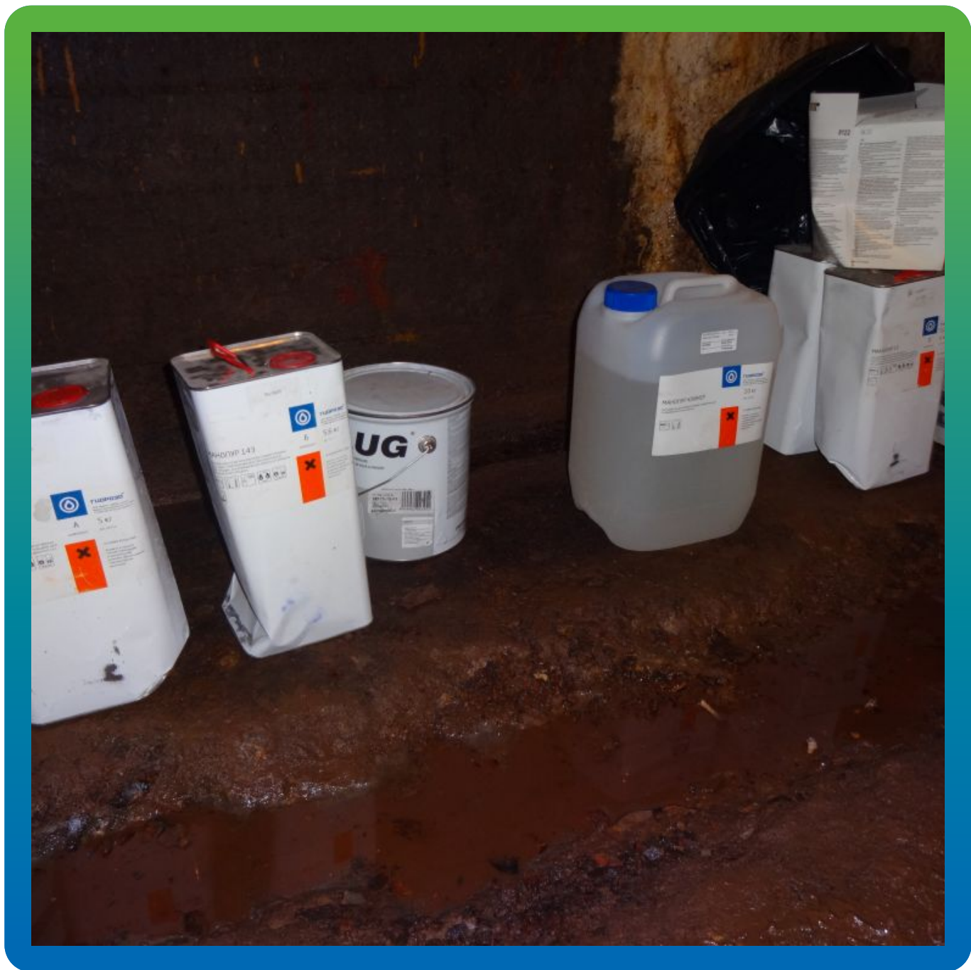
Материалы "Гидрозо" на объекте
