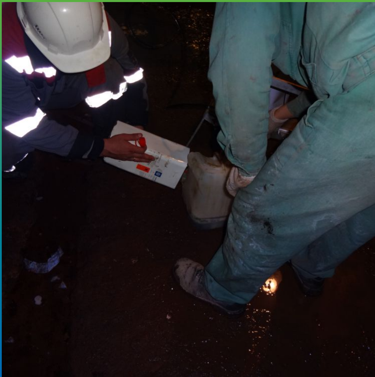
Перемешивание компонентов А+Б гидроактивной пены Манопур 15
