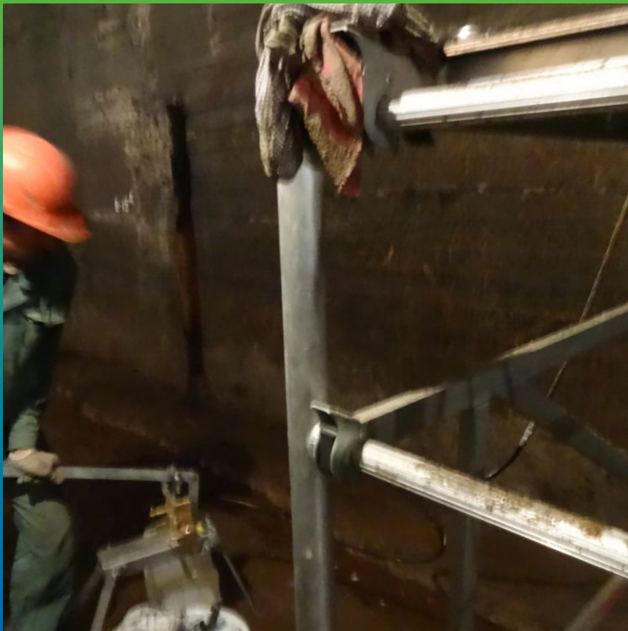
Устранение активных протечек гидроактивной пеной Манопур 15
