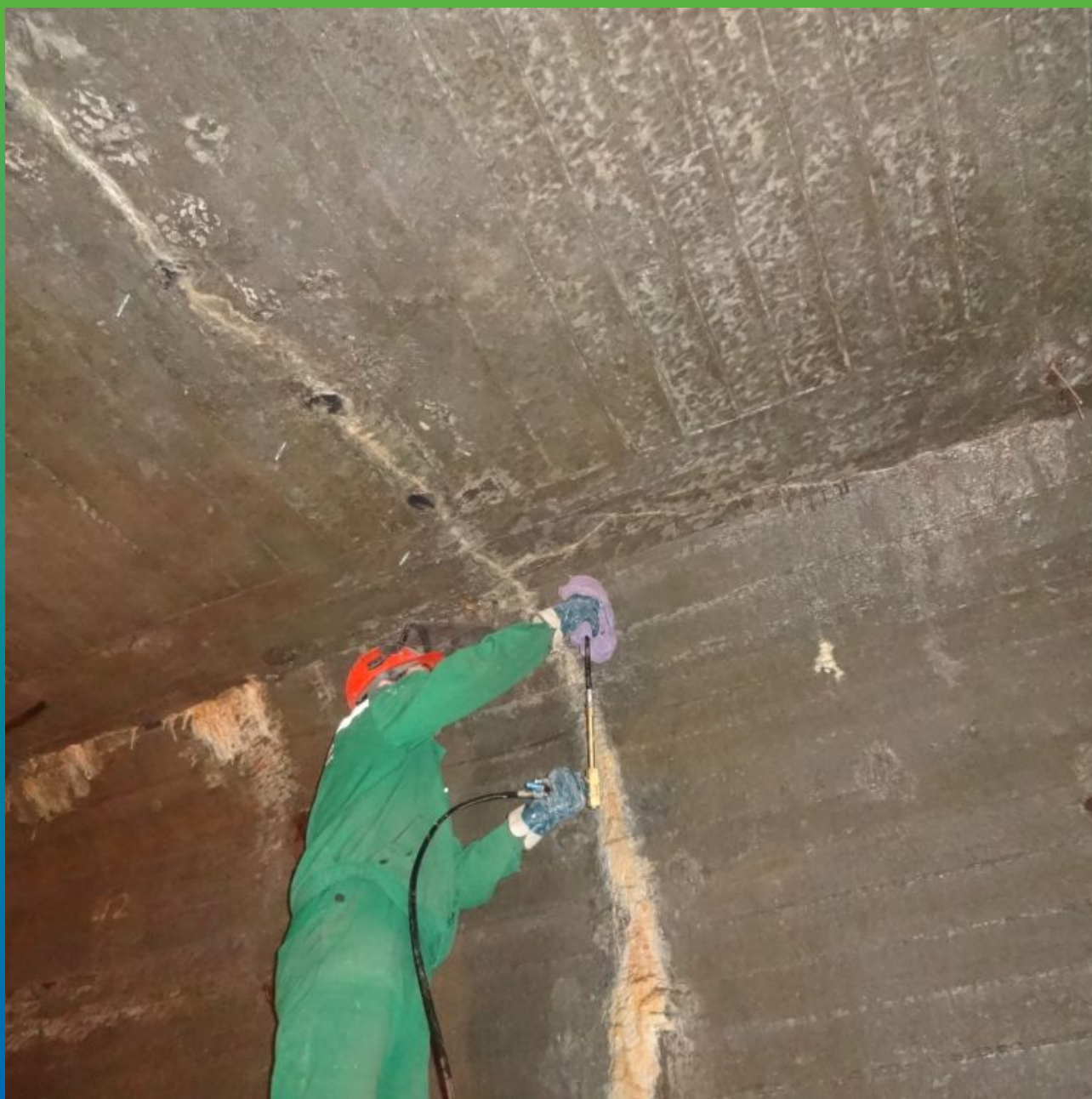
Устранение активных протечек гидроактивной пеной Манопур 15
