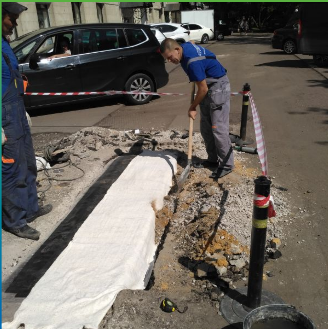
Обратная засыпка перед устройством новой стяжки и дорожного покрытия
