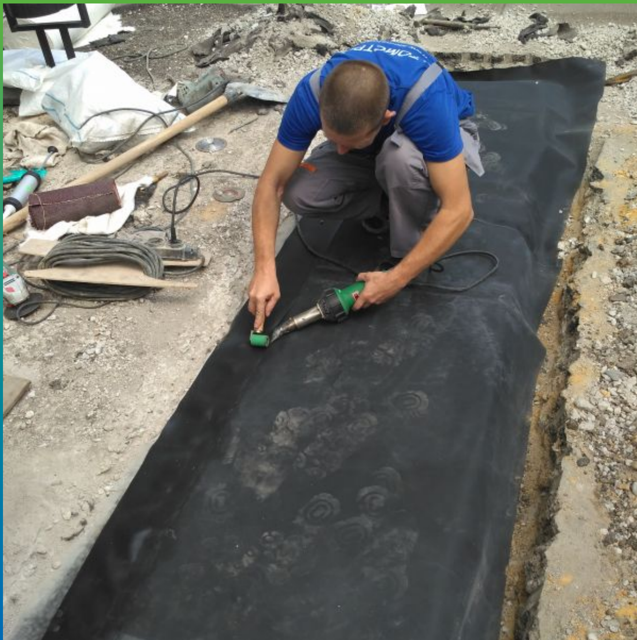
Монтаж мембраны Преласты СТ через ленту Термобонд к поврежденной мембране
