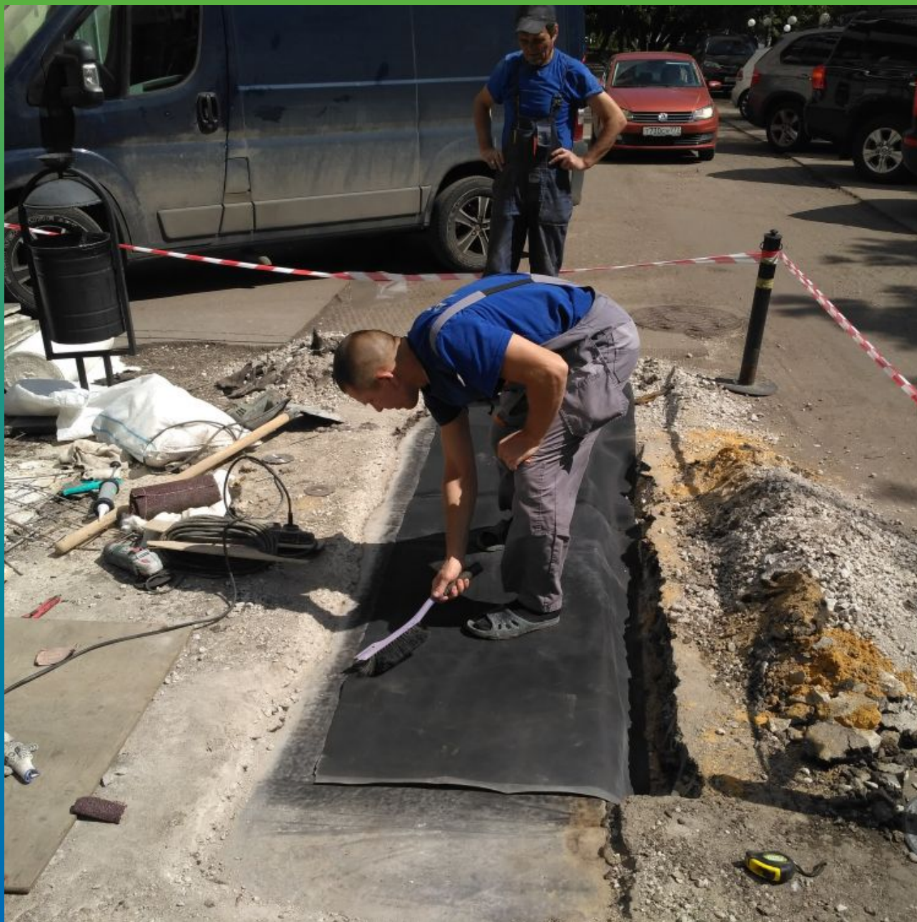
Подготовка основания перед монтажом ЭПДМ мембраны Прелести СТ
