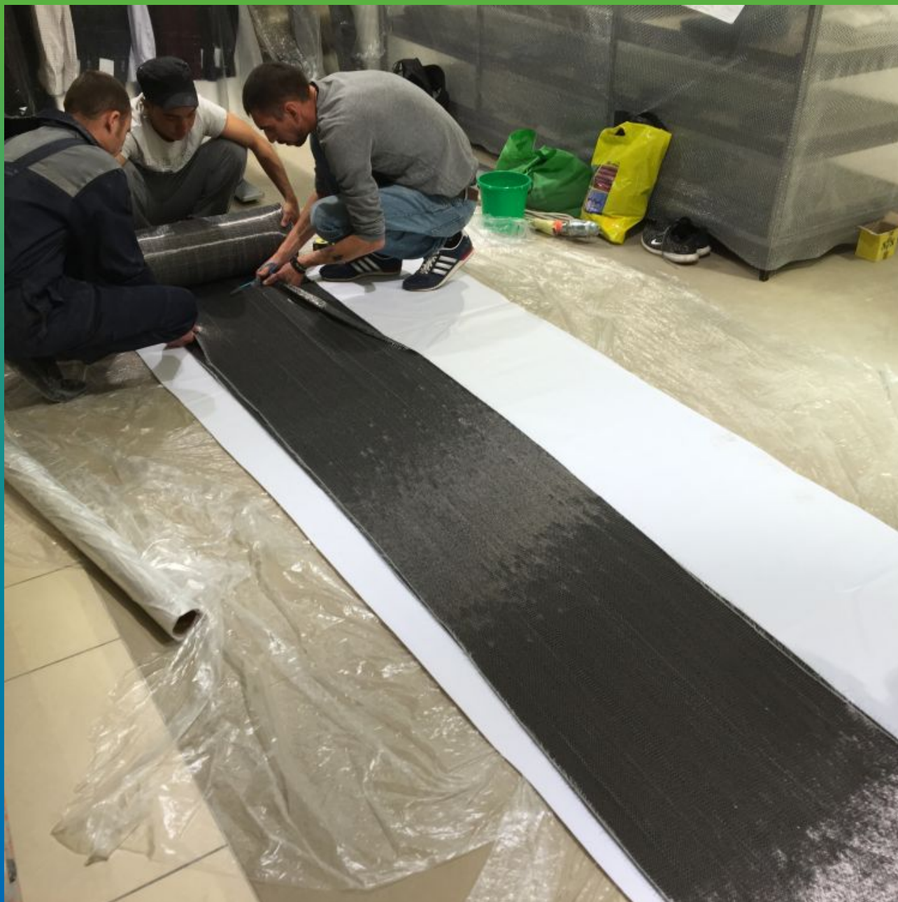
Приготовление материала Манопокс 372 для грунтования и монтажа углеродного холста Армошел KB 500
