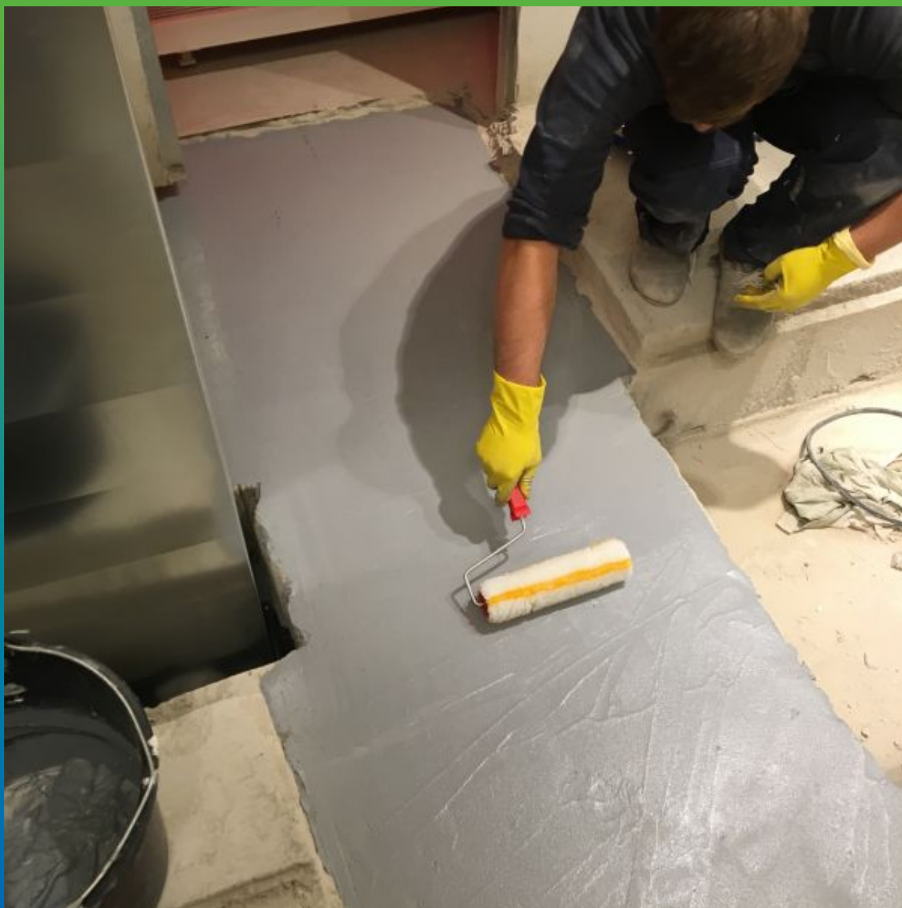
Нанесение грунтовочного слоя Манопокс 372
