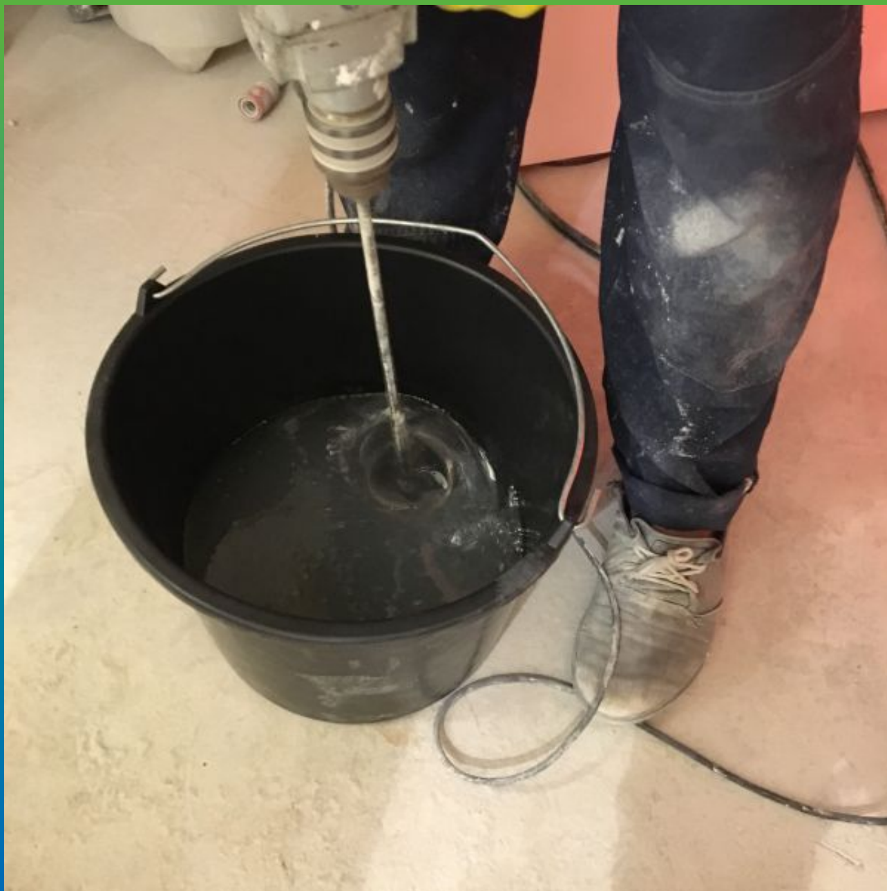
Приготовление материала Манопокс 372 для грунтования и монтажа углеродного холста Армошел КВ 500
