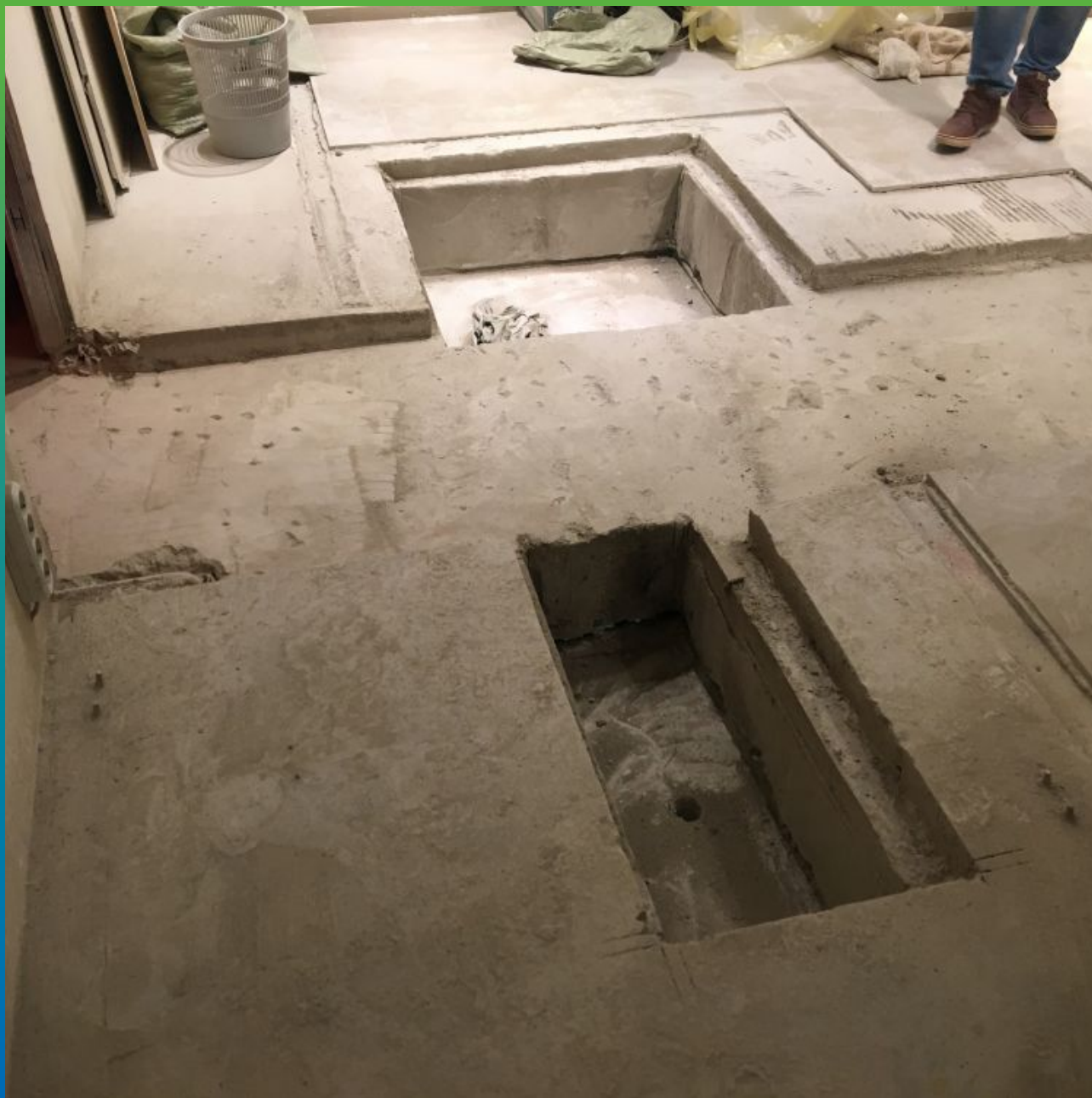
Подготовка основания перед нанесением Манопокс 331
