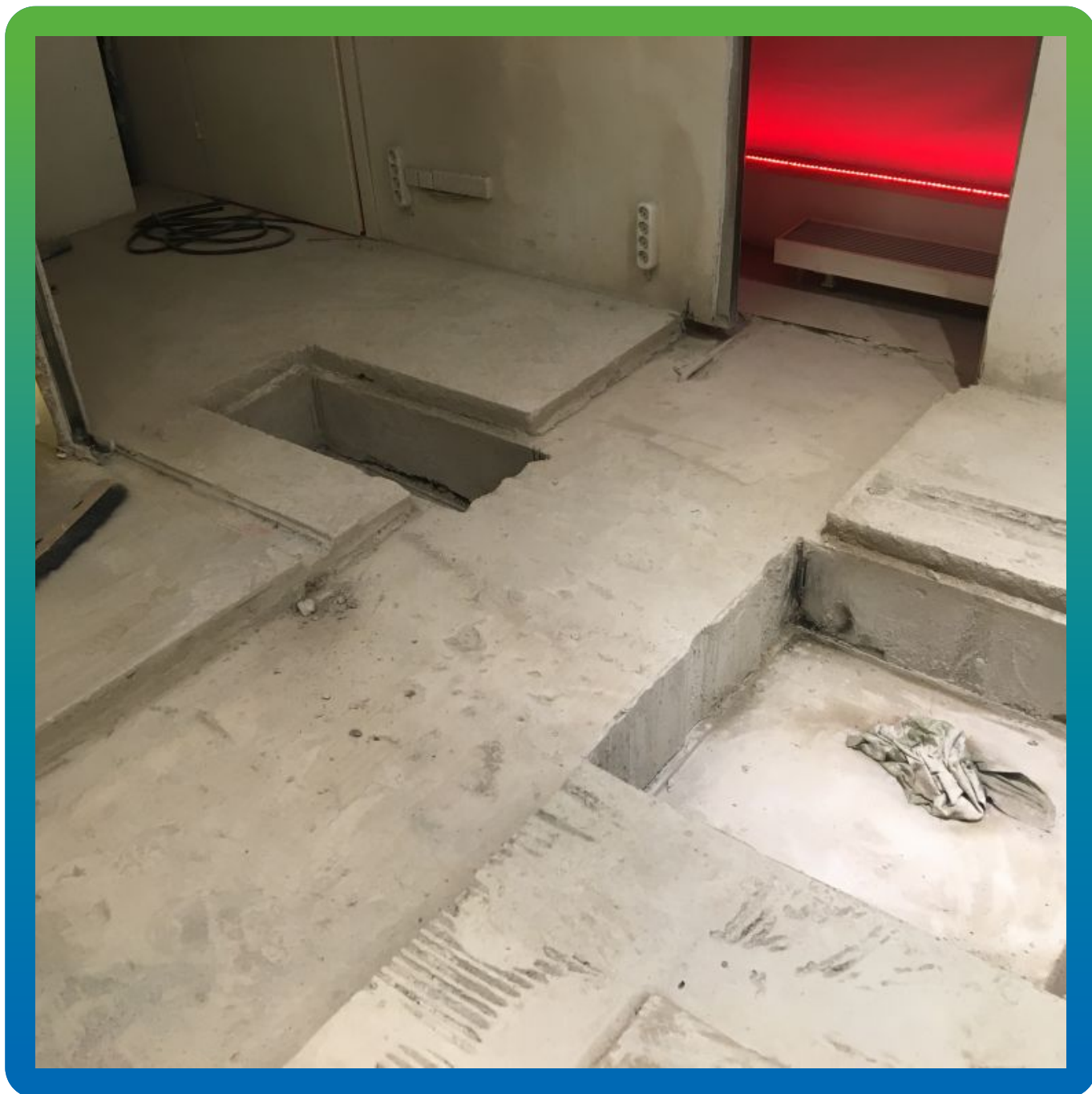
Подготовка основания перед нанесением Манопокс 331
