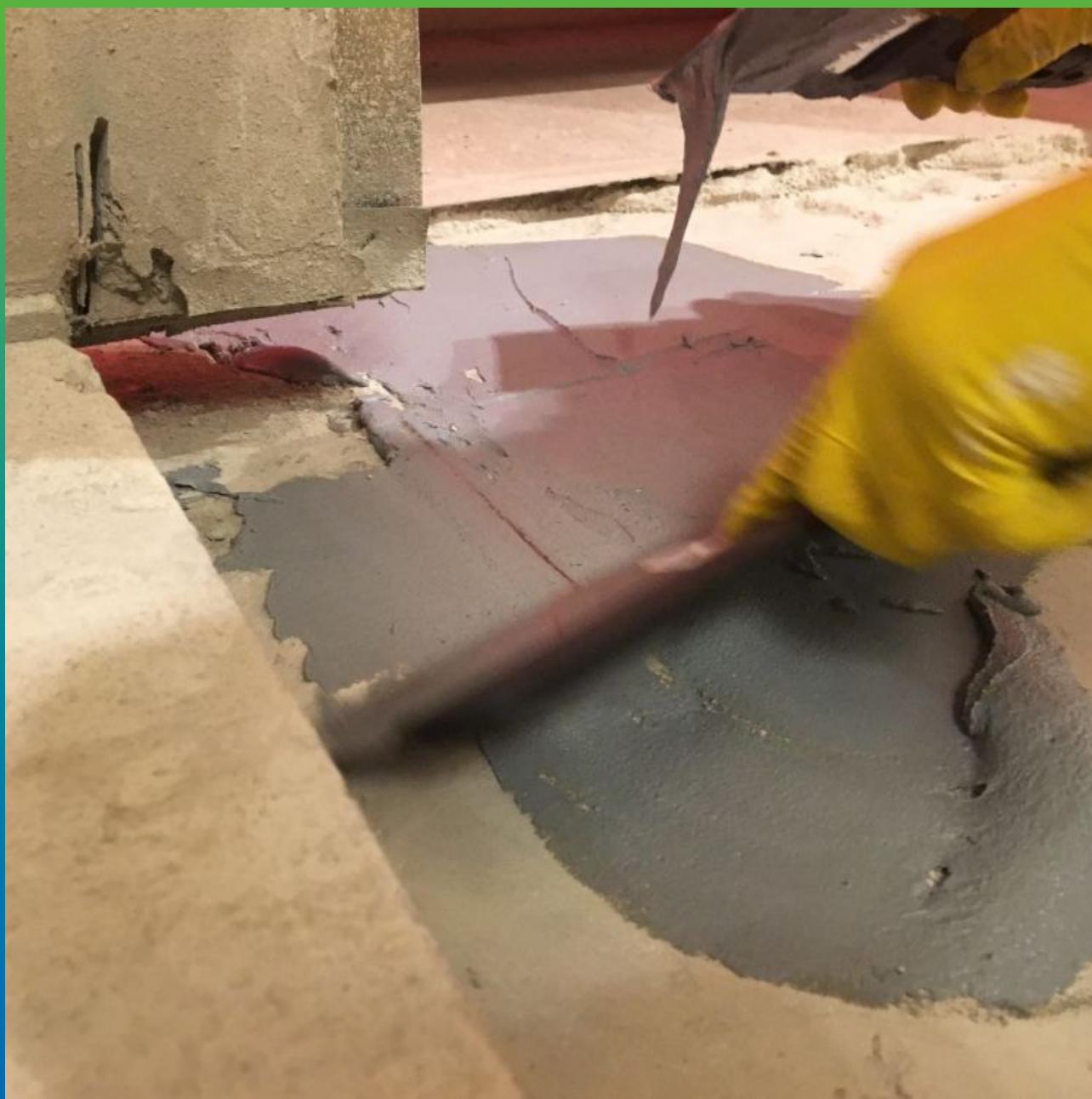
Выравнивание поверхности эпоксидным ремонтным составом Манопокс 331
