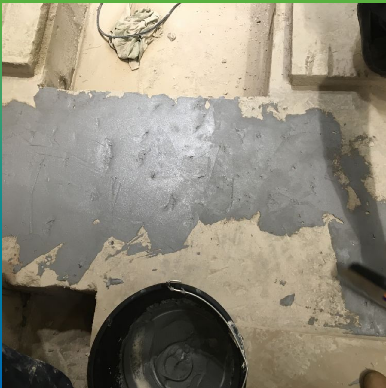
Выравнивание поверхности эпоксидным ремонтным составом Манопокс 331
