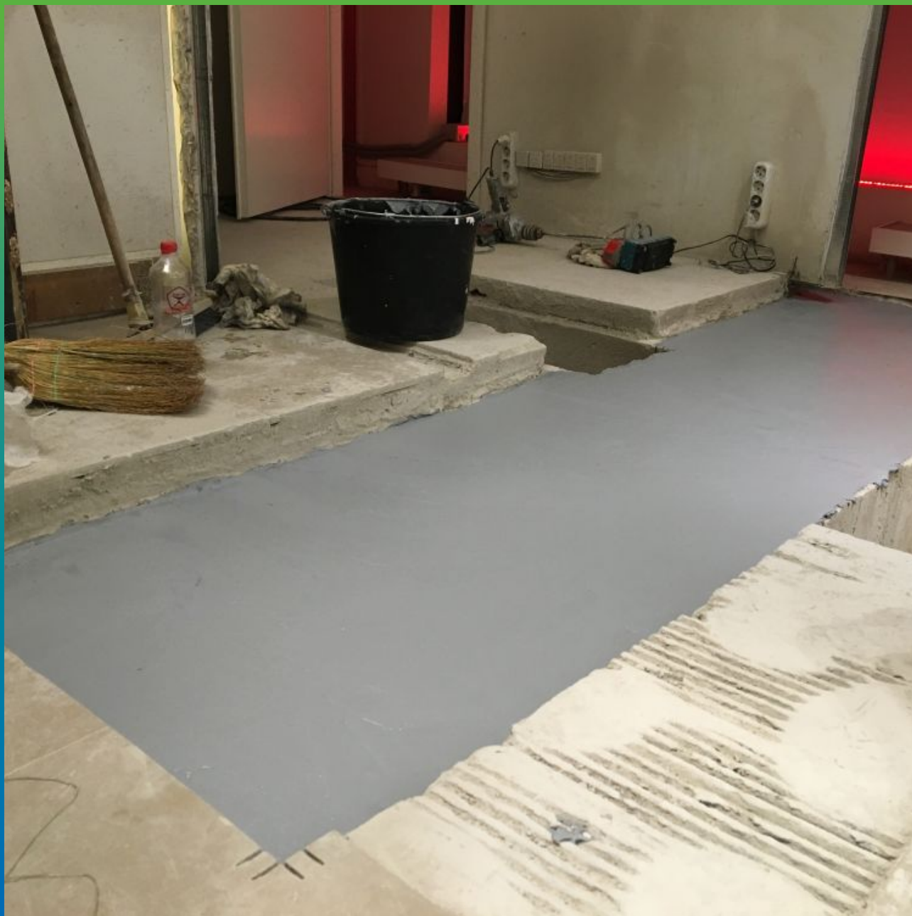
Подготовленная поверхность материалом Манопокс 331 для последующего монтажа системы усиления
