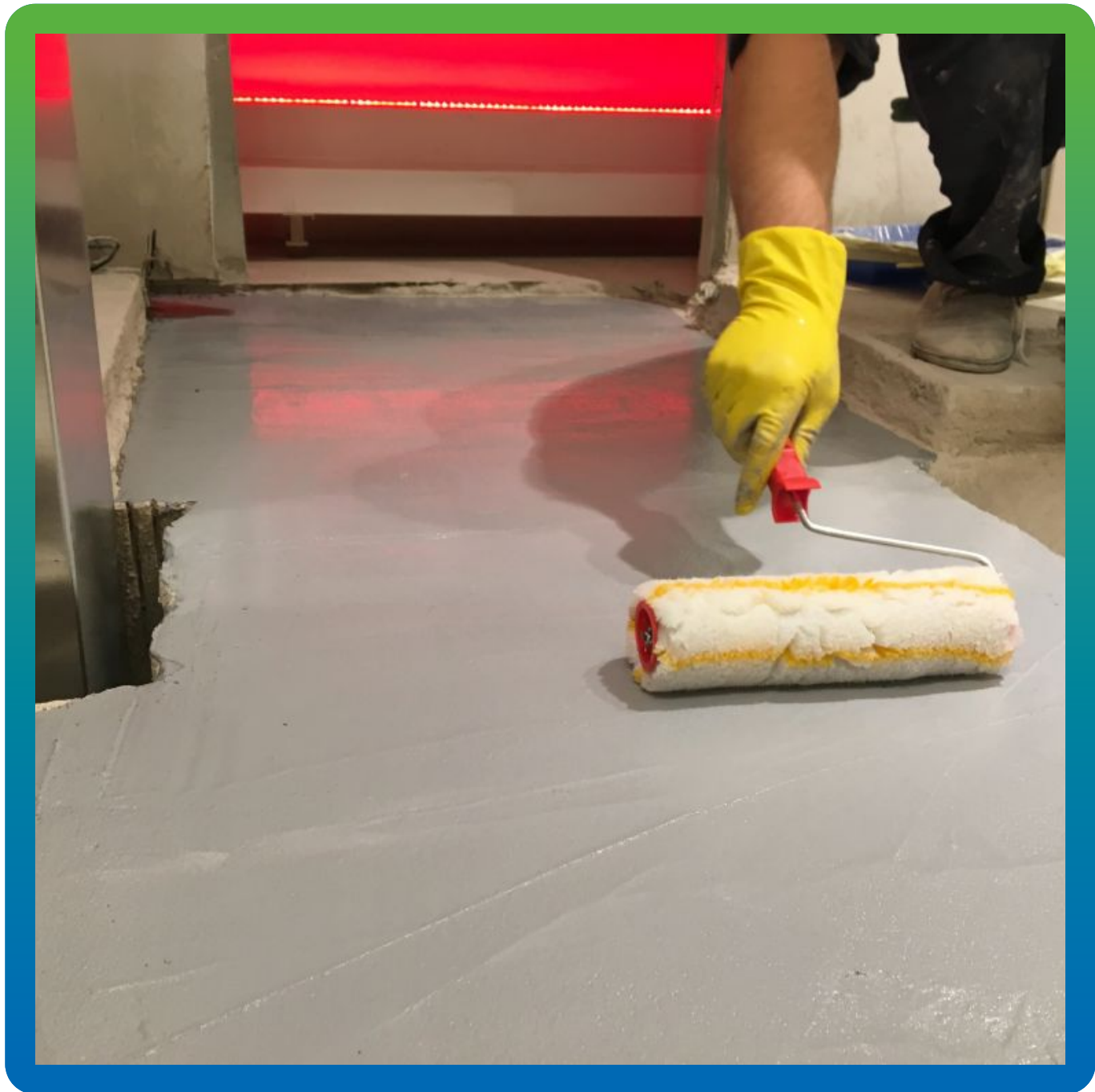
Нанесение грунтовочного слоя Манопокс 372
