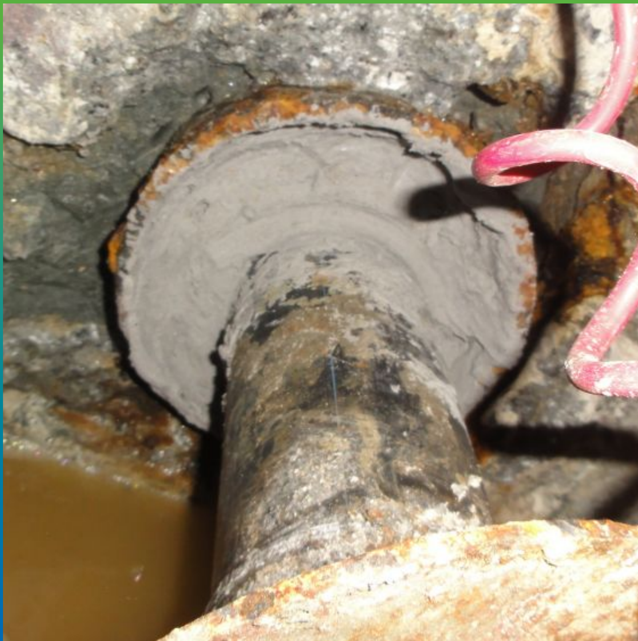
Вид нанесенного герметика
