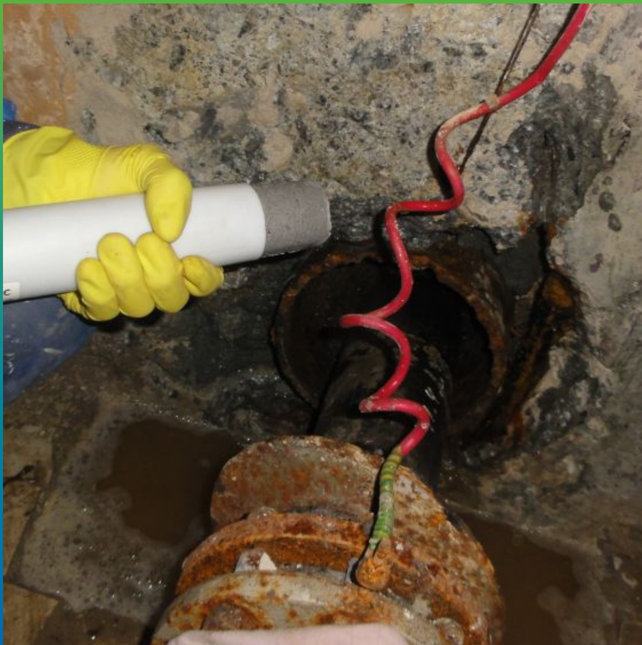
Нанесение герметика Витрафин Флекс
