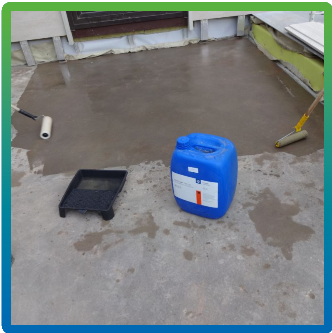
Нанесение валиками на поверхность Маногард Топ 117
