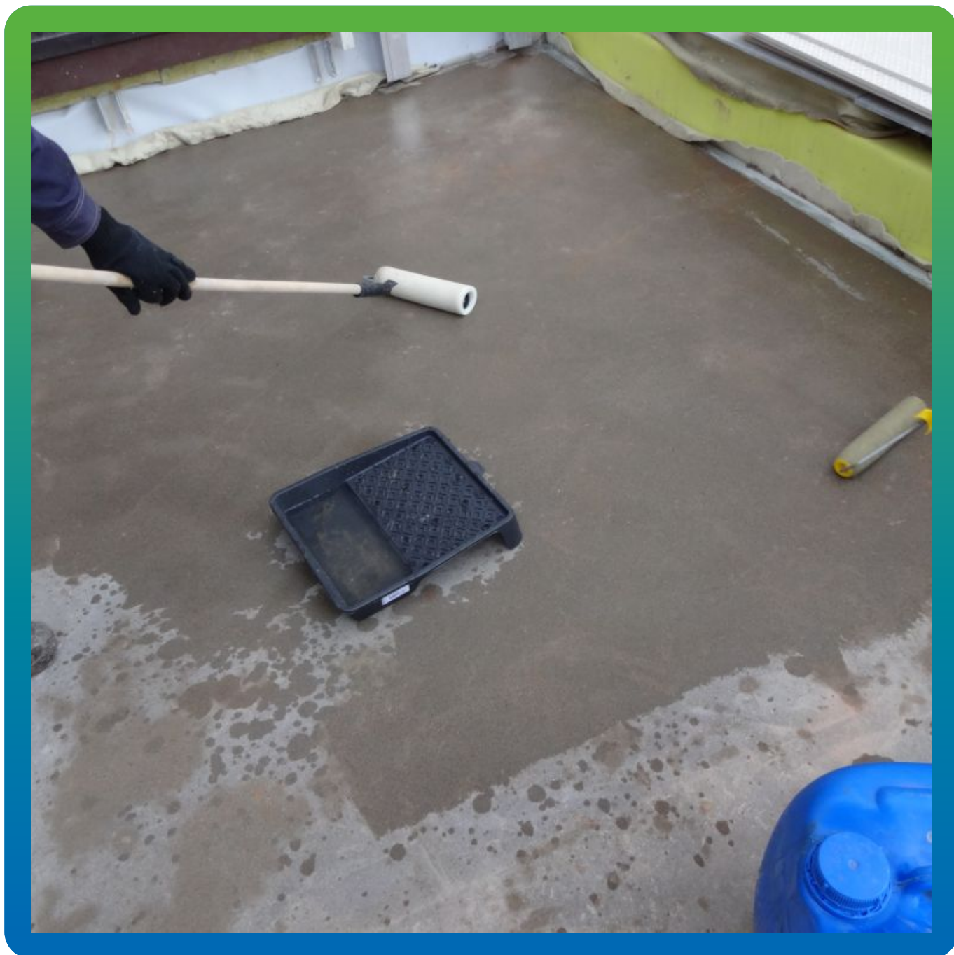
Нанесение валиками на поверхность Маногард Топ 117
