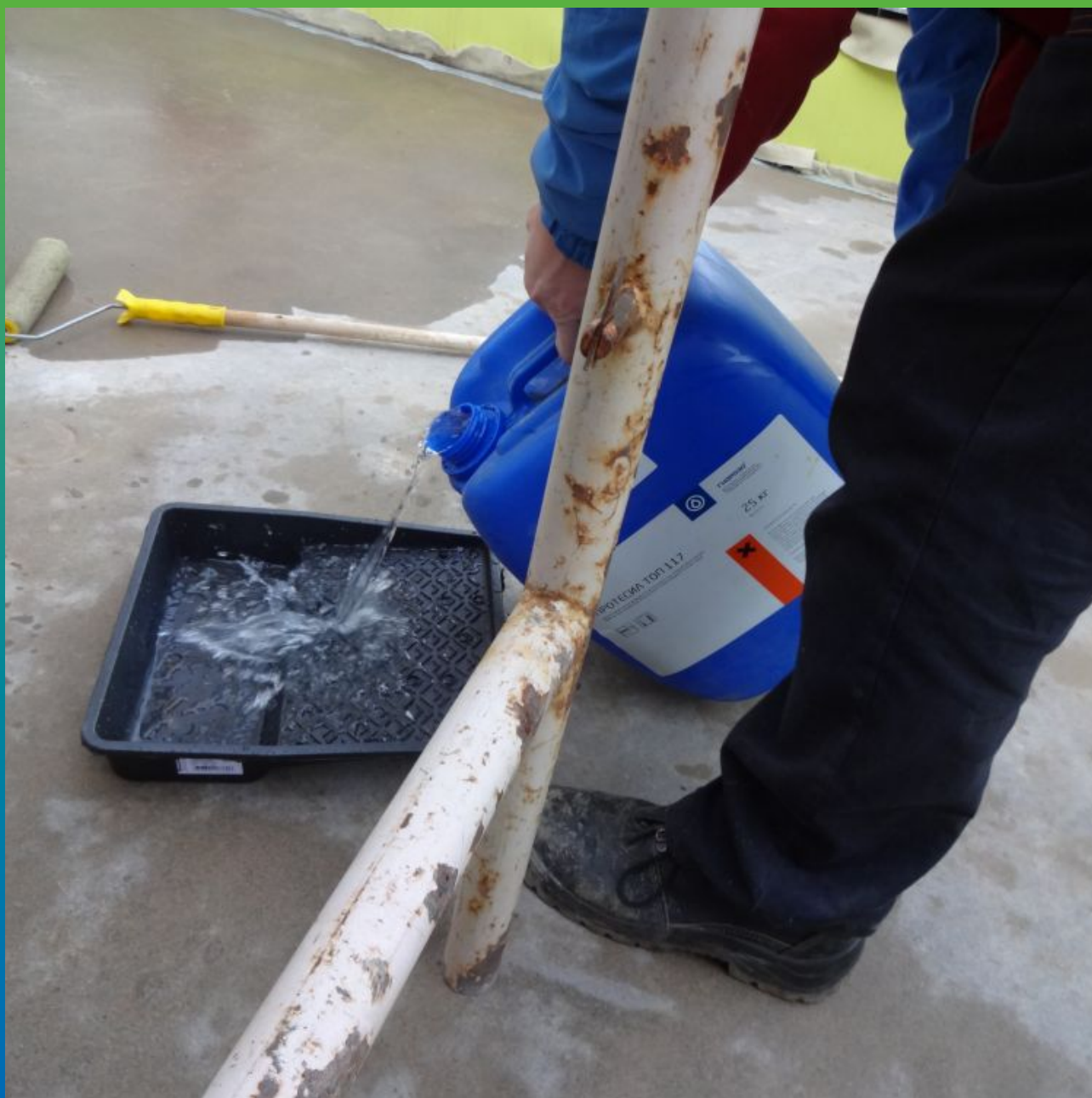
Нанесение валиками на поверхность Маногард Топ 117
