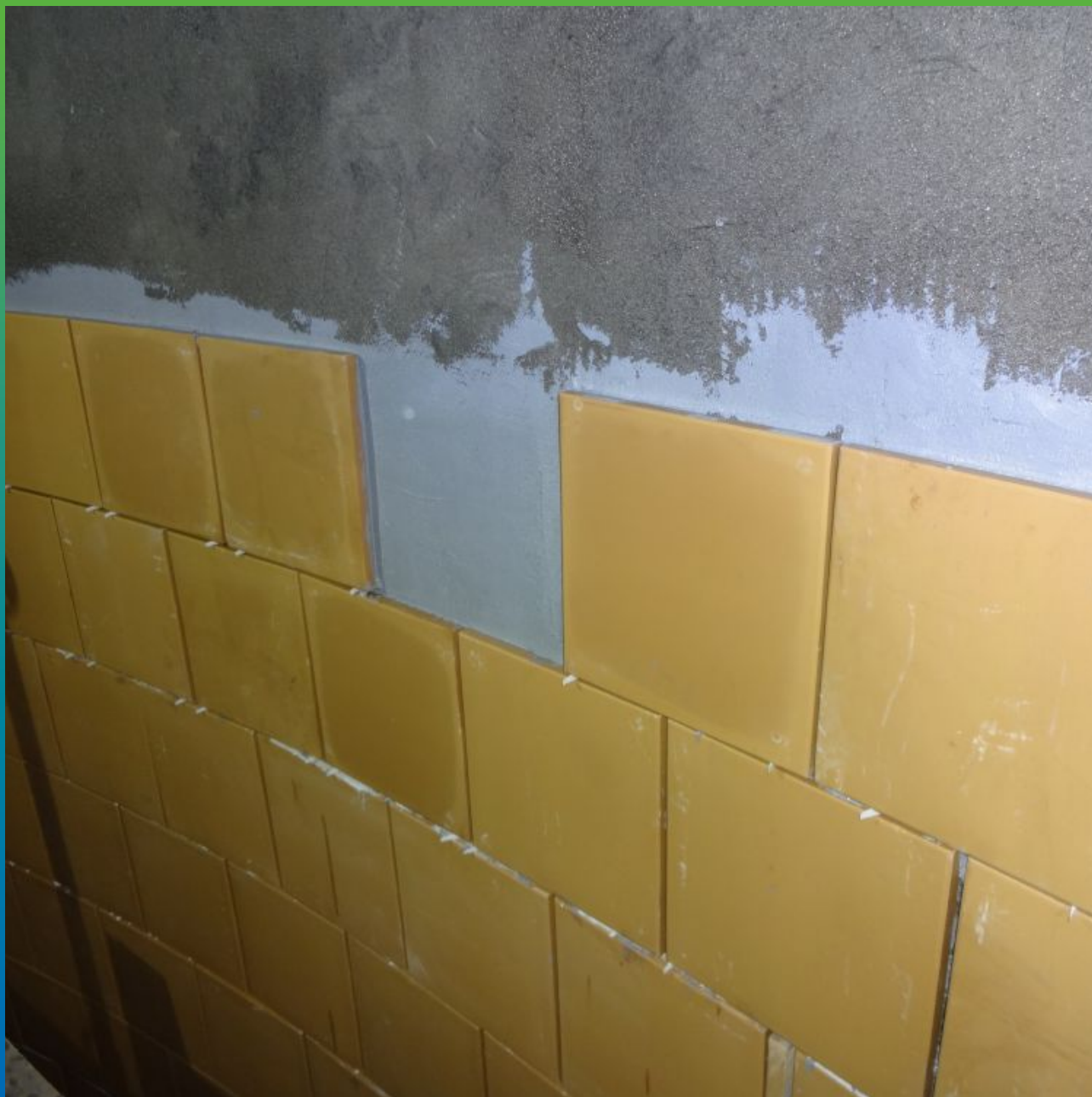
Монтаж химостойкой плитки на клей Манопокс 331
