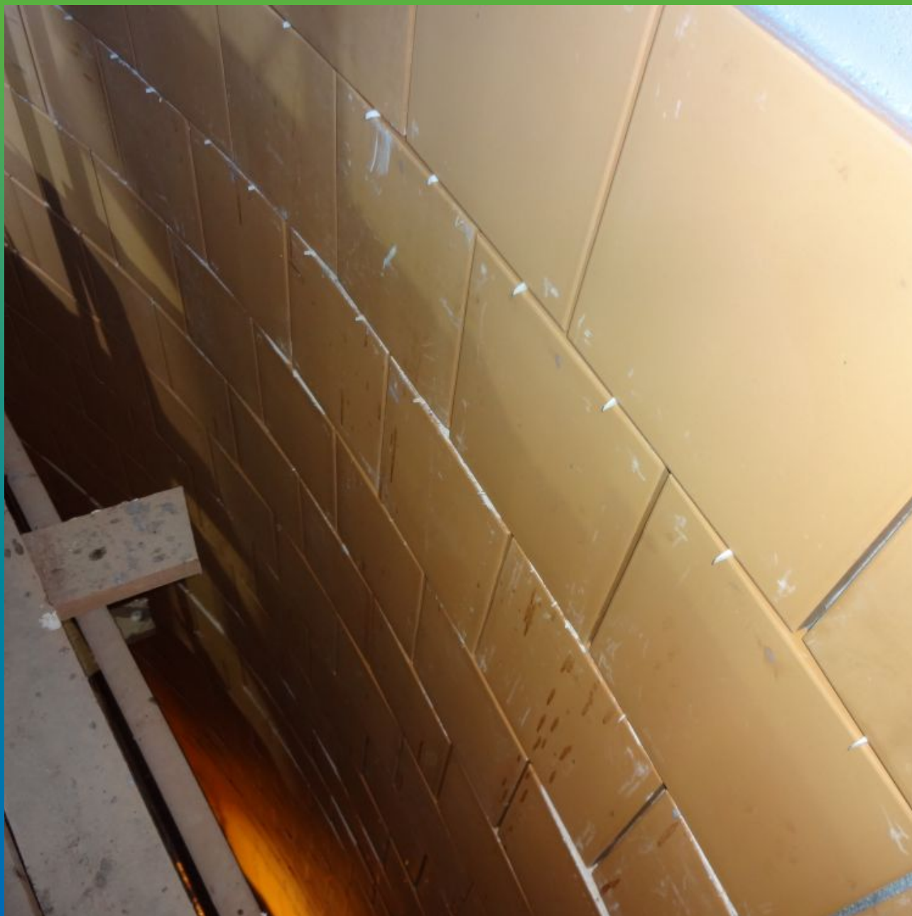
Монтаж химостойкой плитки на клей Манопокс 331
