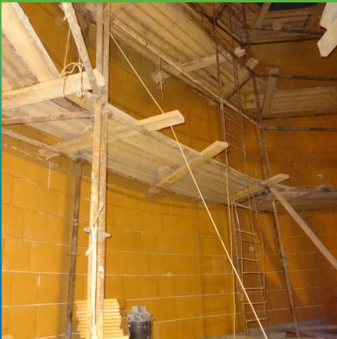
Итоговый вид объекта
