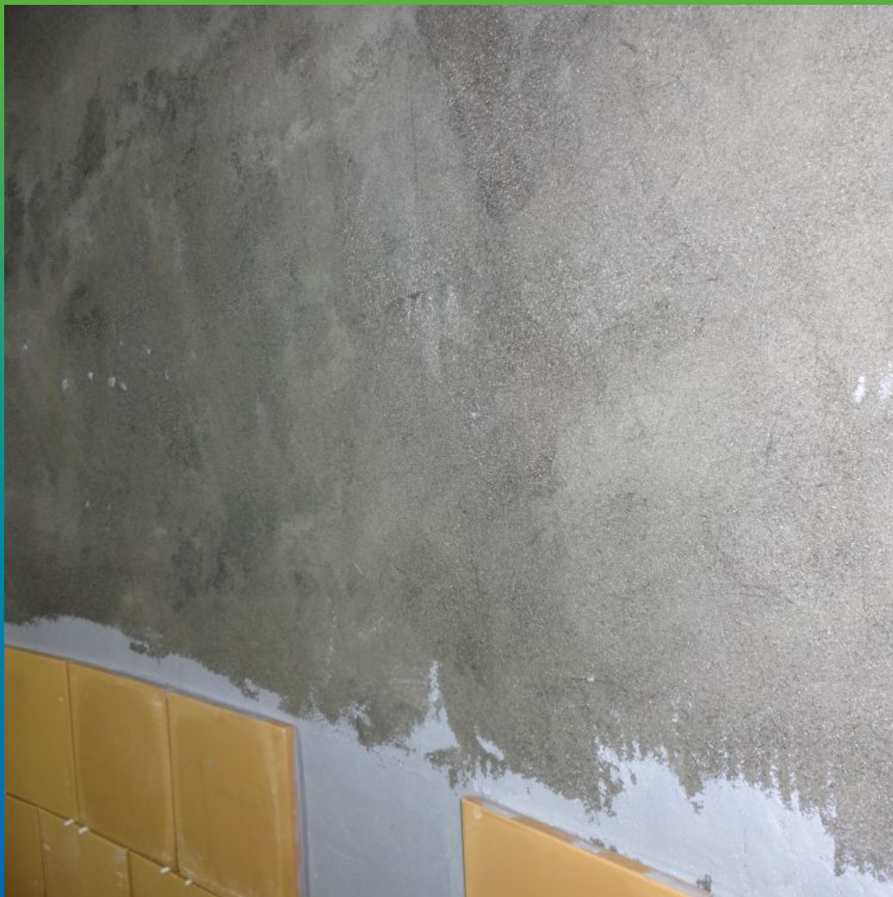
Монтаж химостойкой плитки на клей Манопокс 331
