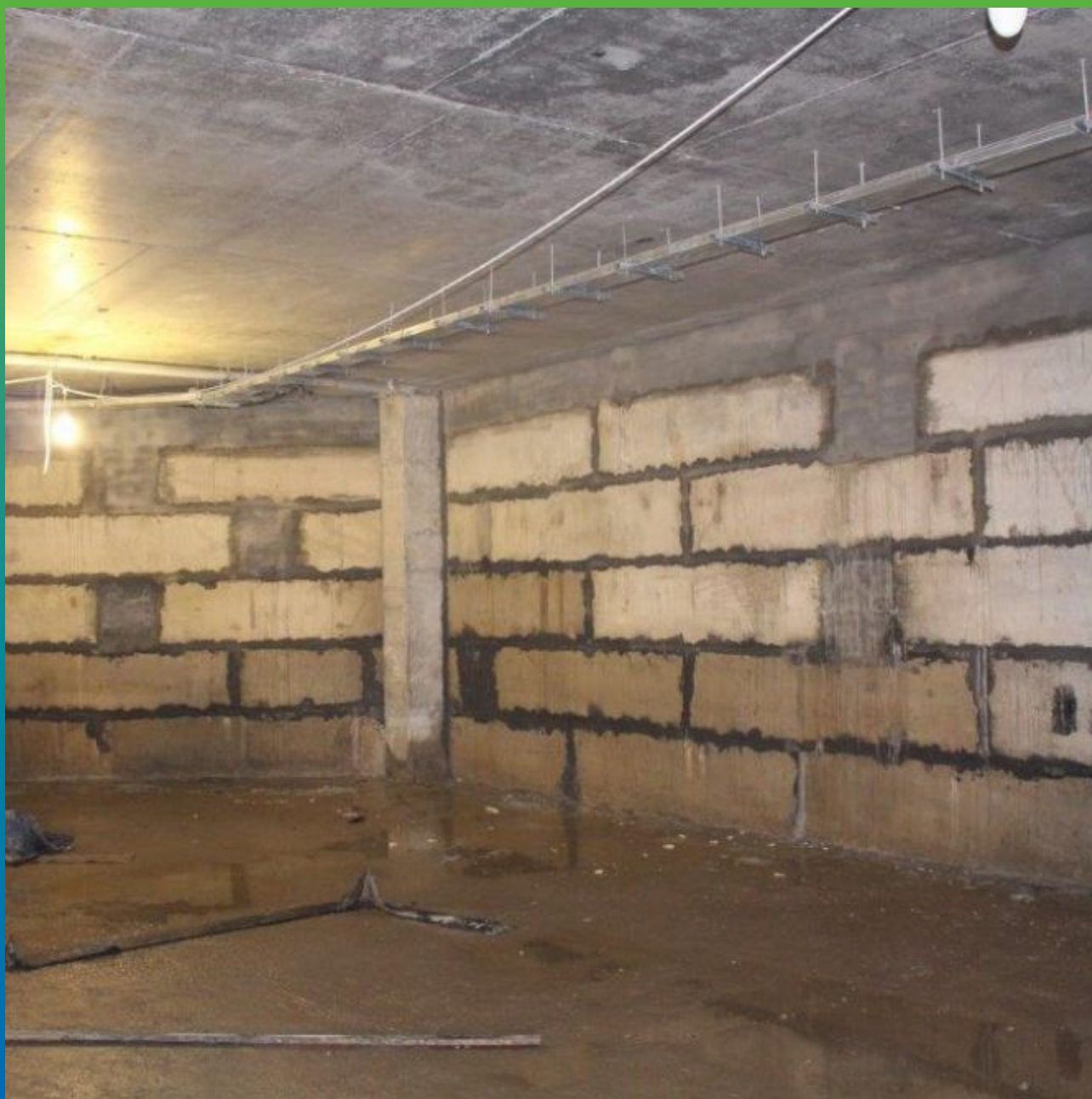
Подготовка основания ремонтным составом Стармекс РМЗ
