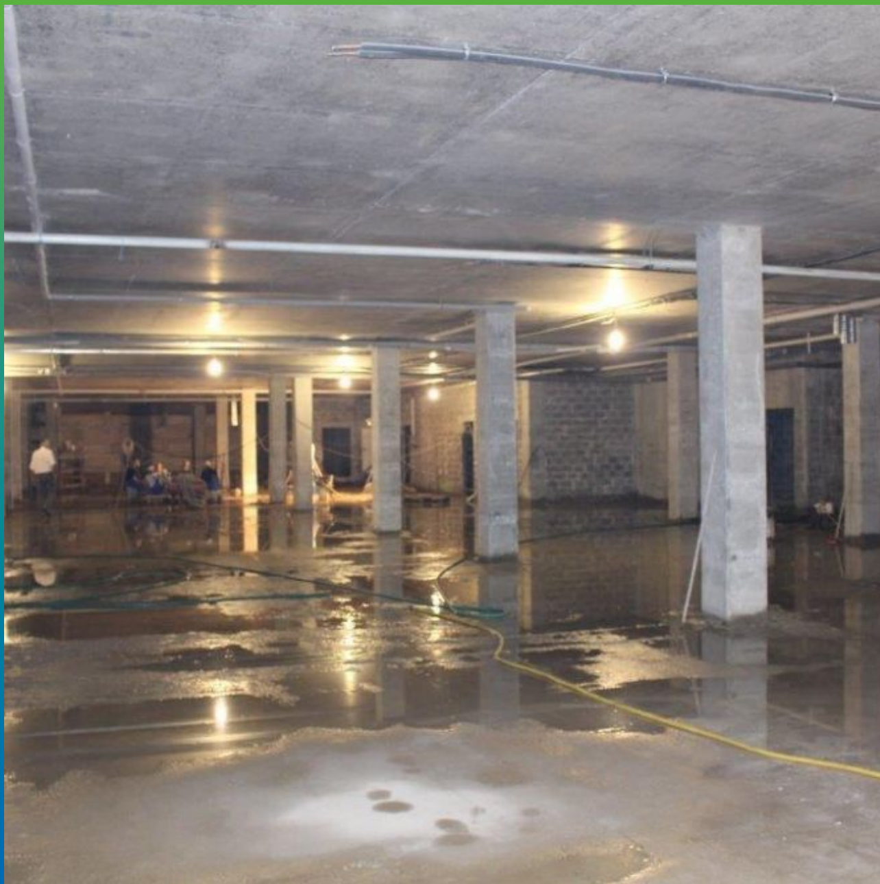
Вид объекта до начала работ
