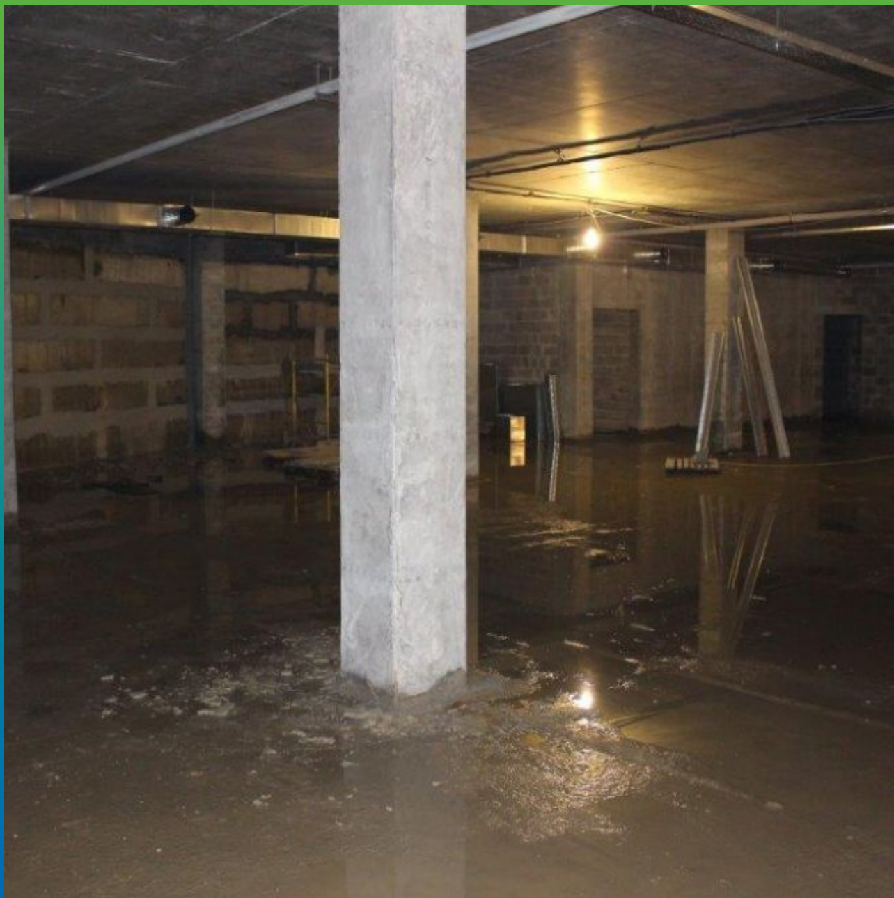
Вид объекта до начала работ
