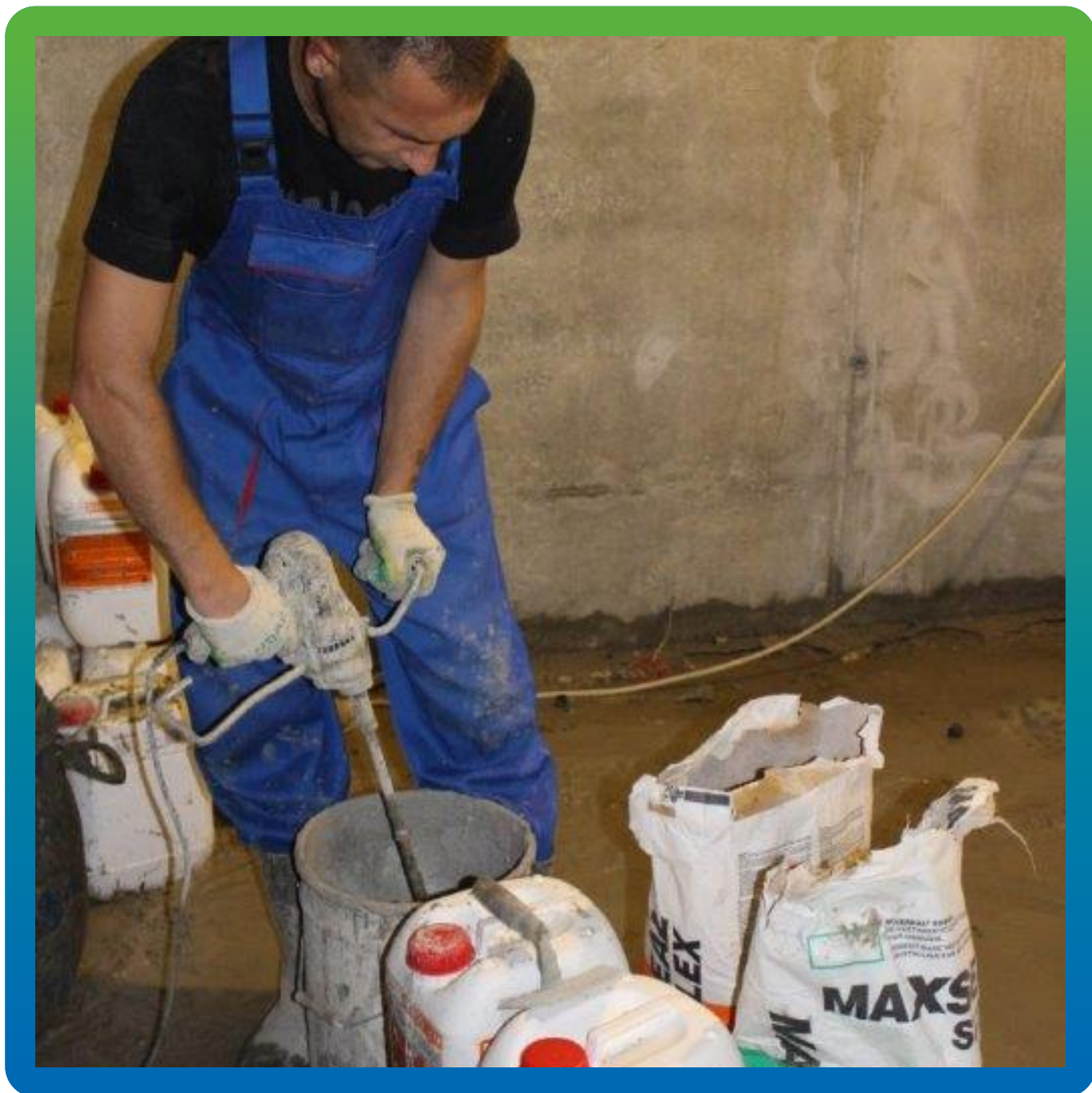
Приготовление 2К эластичного гидроизоляционного состава Максил Флекс
