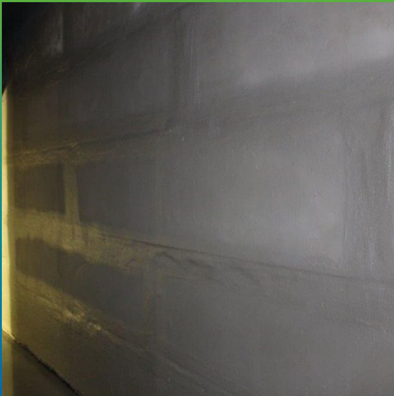
Площадная гидроизоляция стен паркинга материалом Макссил Супер
