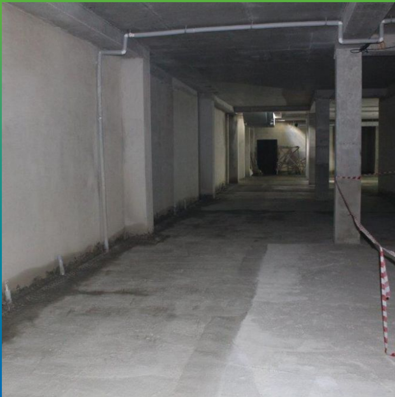
Вид объекта после окончания работ
