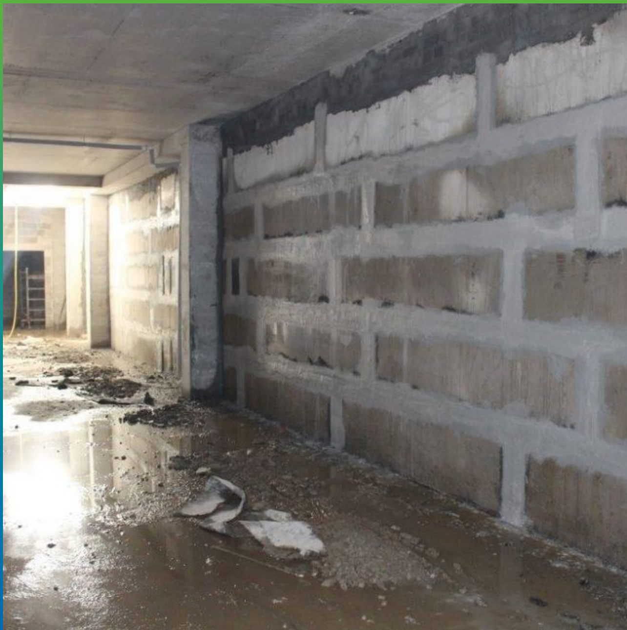
Обработка холодных швов стен Максил Флекс
