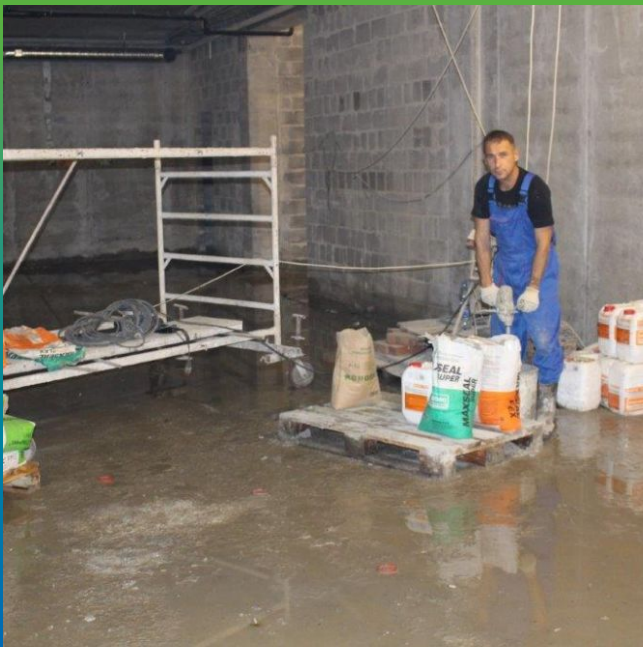
Приготовление материала Стармекс РМЗ для подготовки основания и чеканки холодных швов
