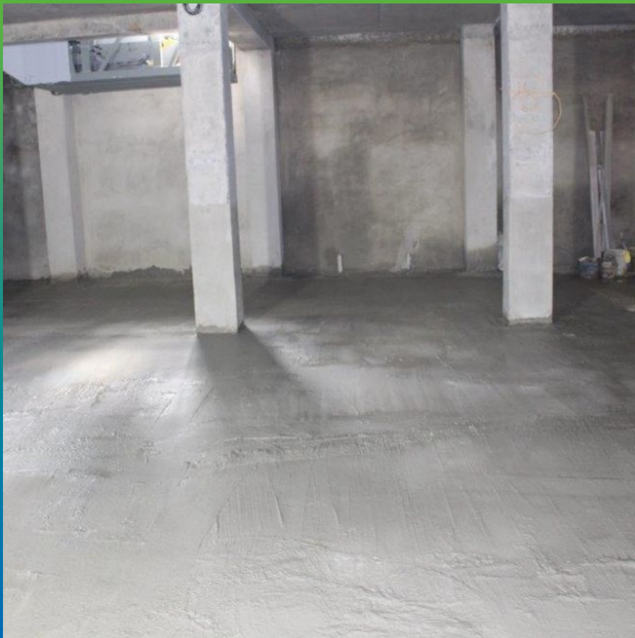
Площадная гидроизоляция пола материалом Макссил Супер
