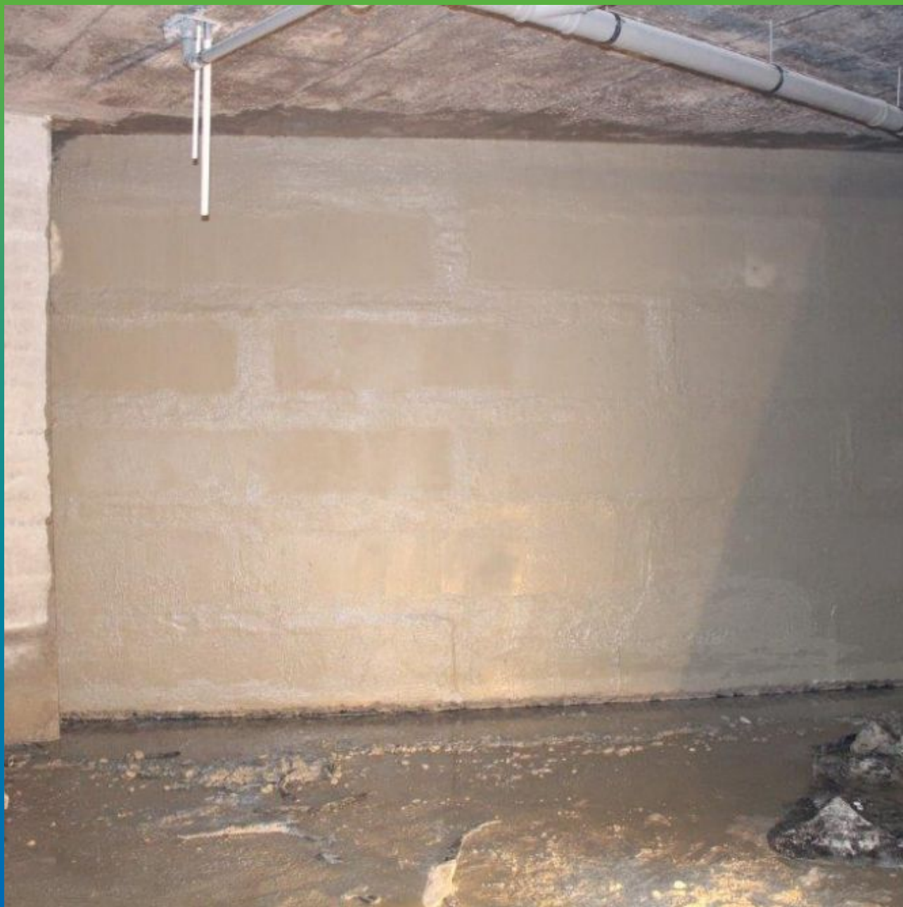
Площадная гидроизоляция стен материалом Максил Супер
