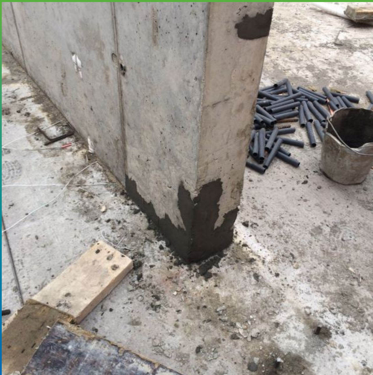
Вид отремонтированной поверхности
