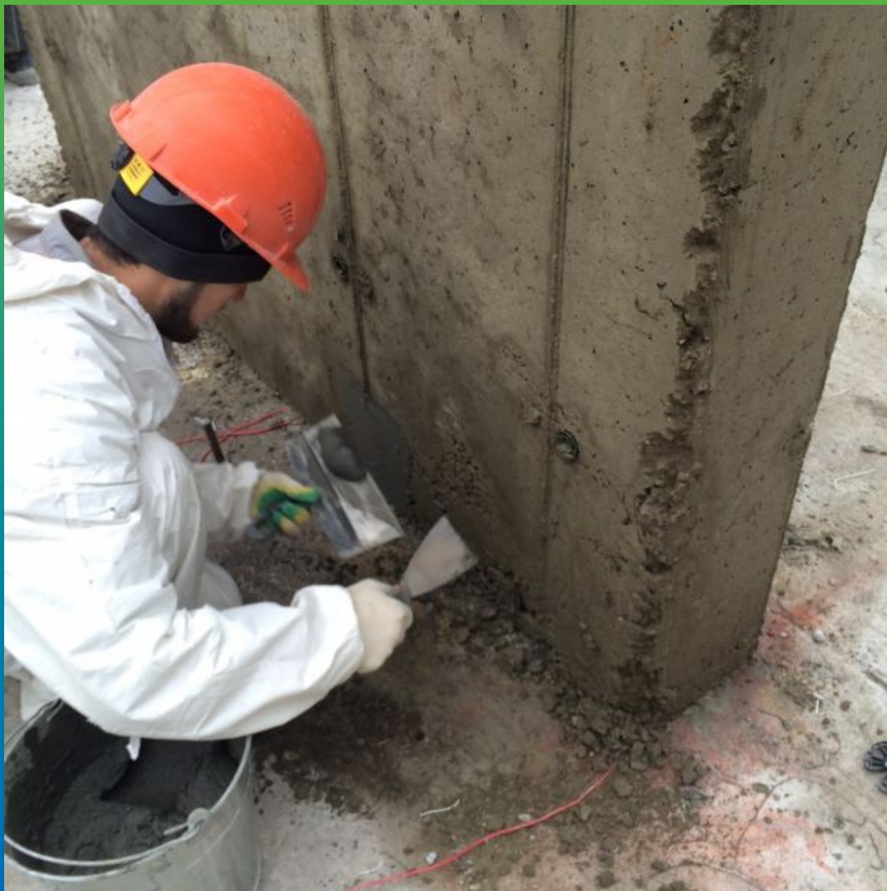
Ремонт дефектов конструкции Стармекс РМЗ
