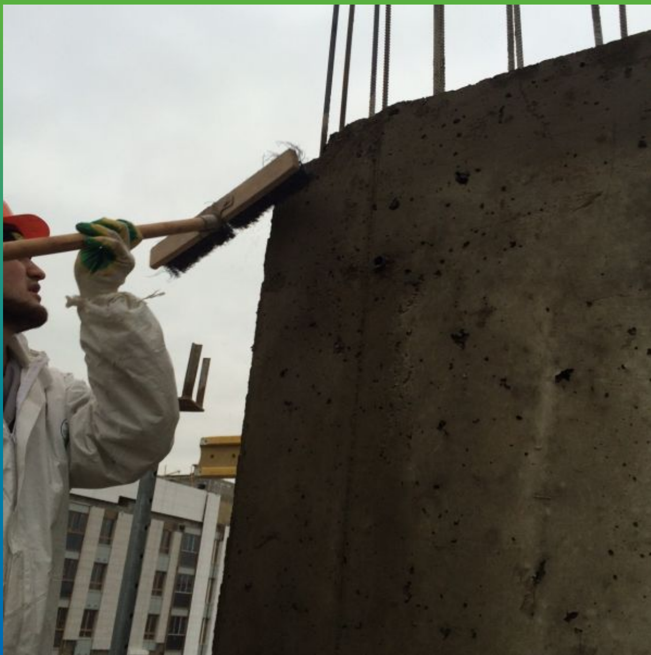
Очистка от непрочного бетона
