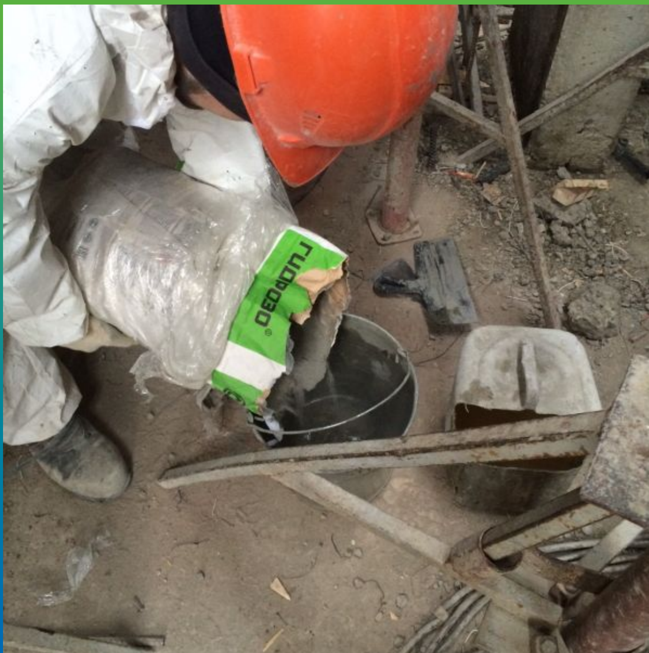
Приготовление ремонтного состава Стармекс РМЗ
