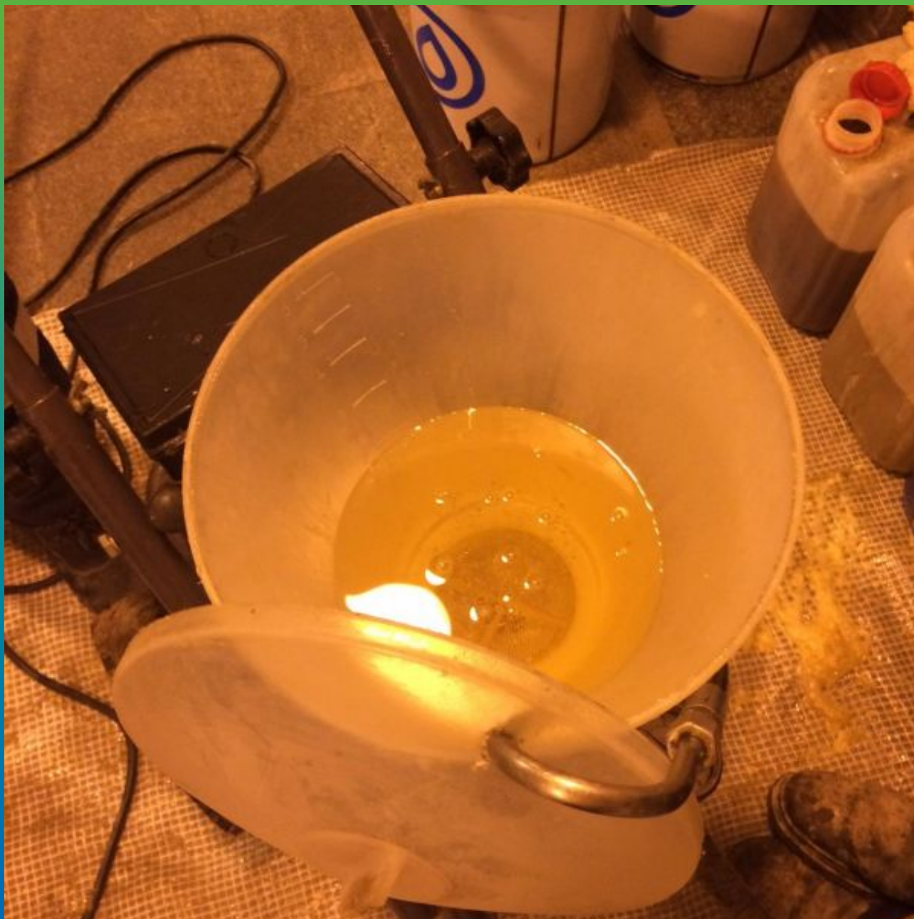
Насос БМ 1200 и инъекционный состав Манопур С
