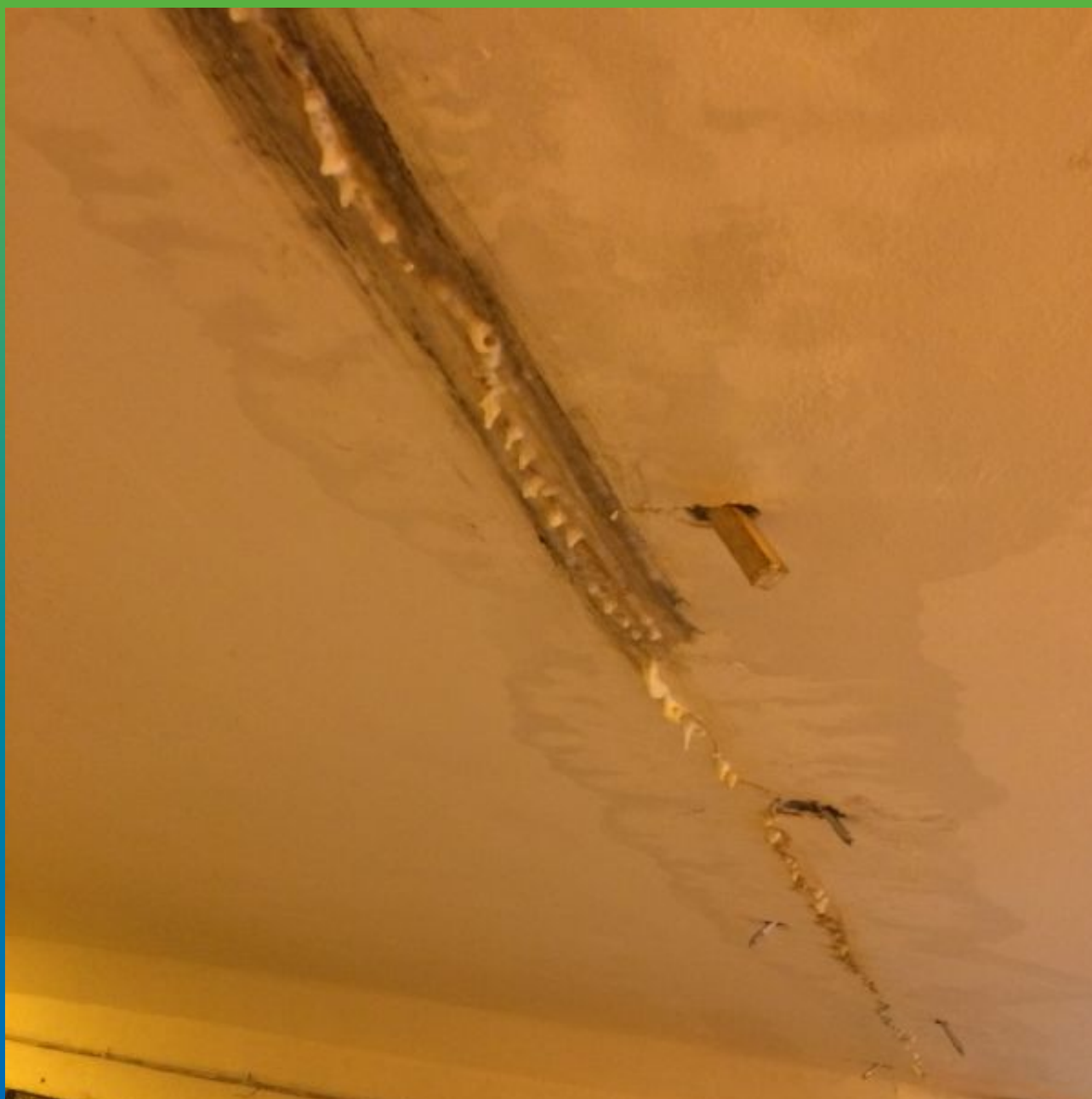
Вид проинъектированной трещины материалом Манопур С
