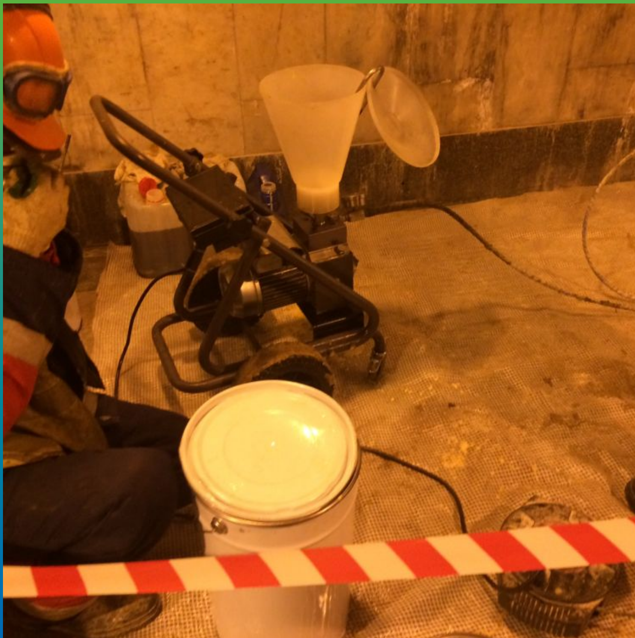
Материал и оборудование перед инъекционными работами
