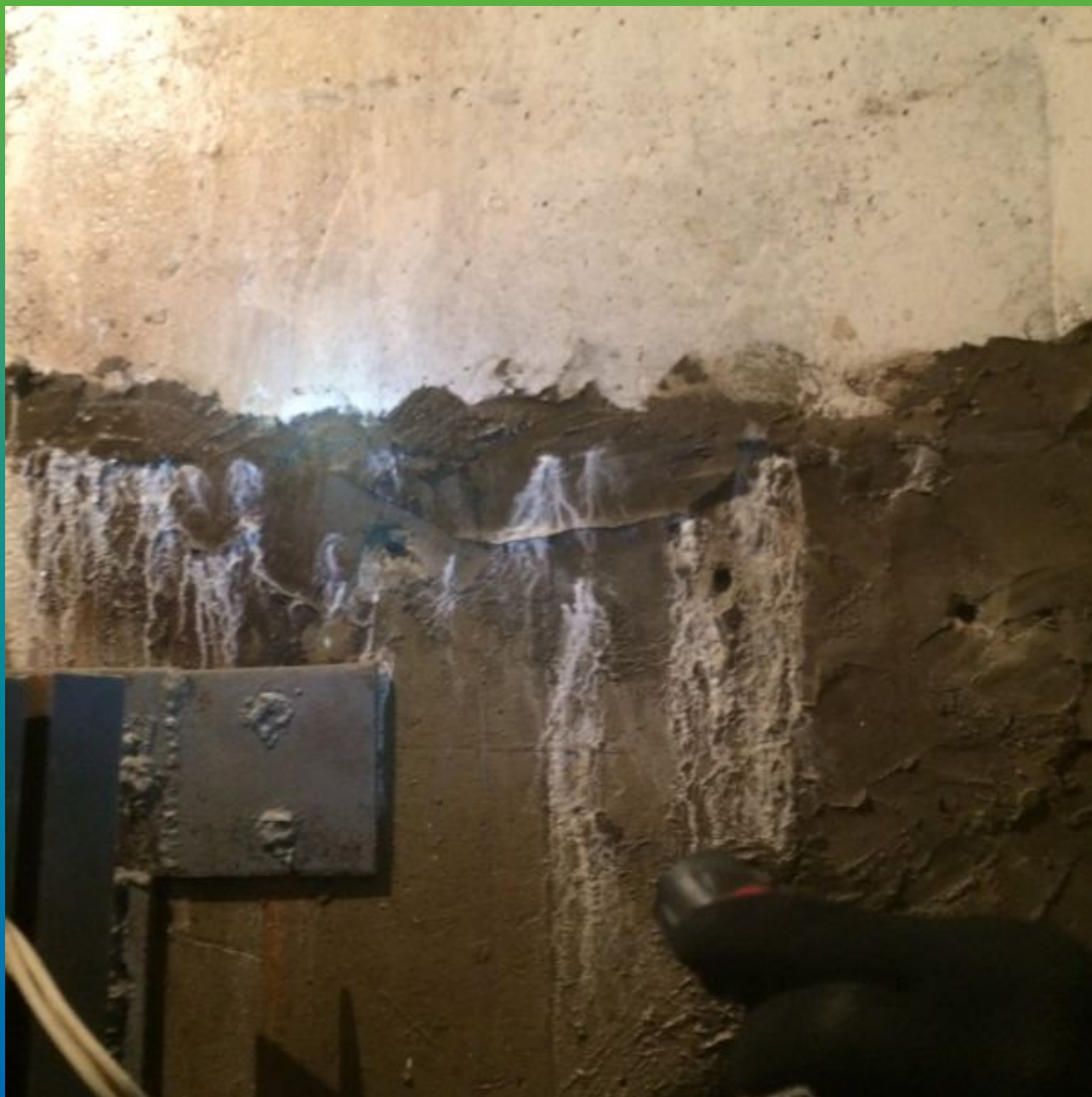
Объект после инъекирования
