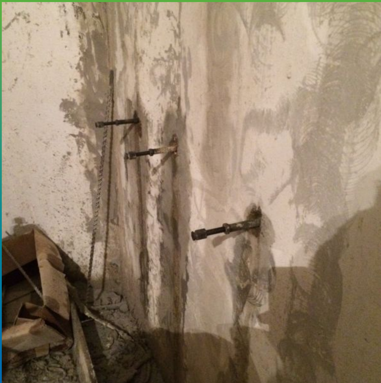
Монтаж пакеров в местах протечек
