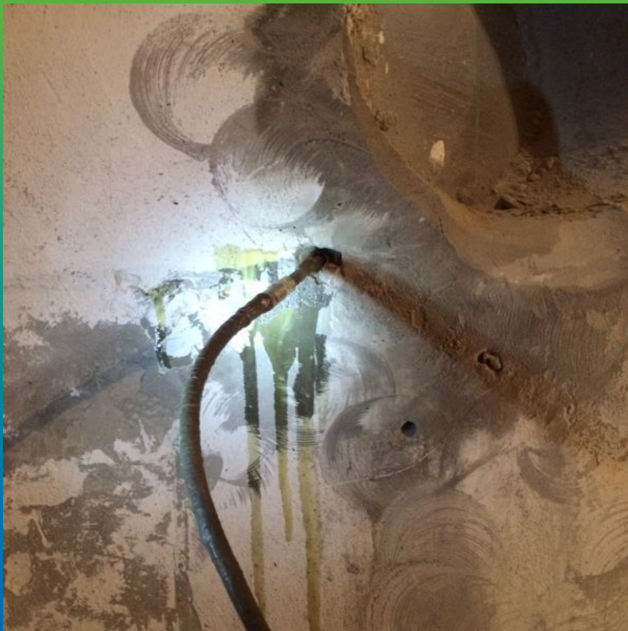
Инъектирование протечек в местах дефектов ж/б конструкции смолой Манопур 15
