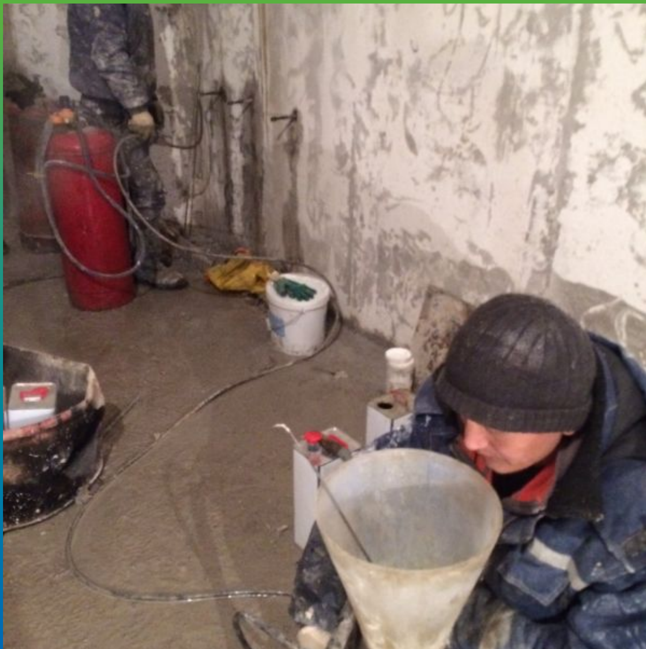
Инъектирование полиуретановой смолы Манопур 143
