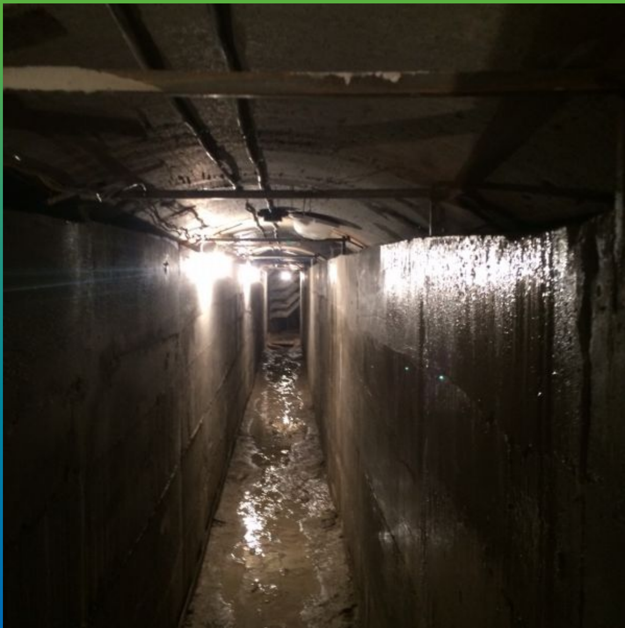
Вид коллектора изнутри
