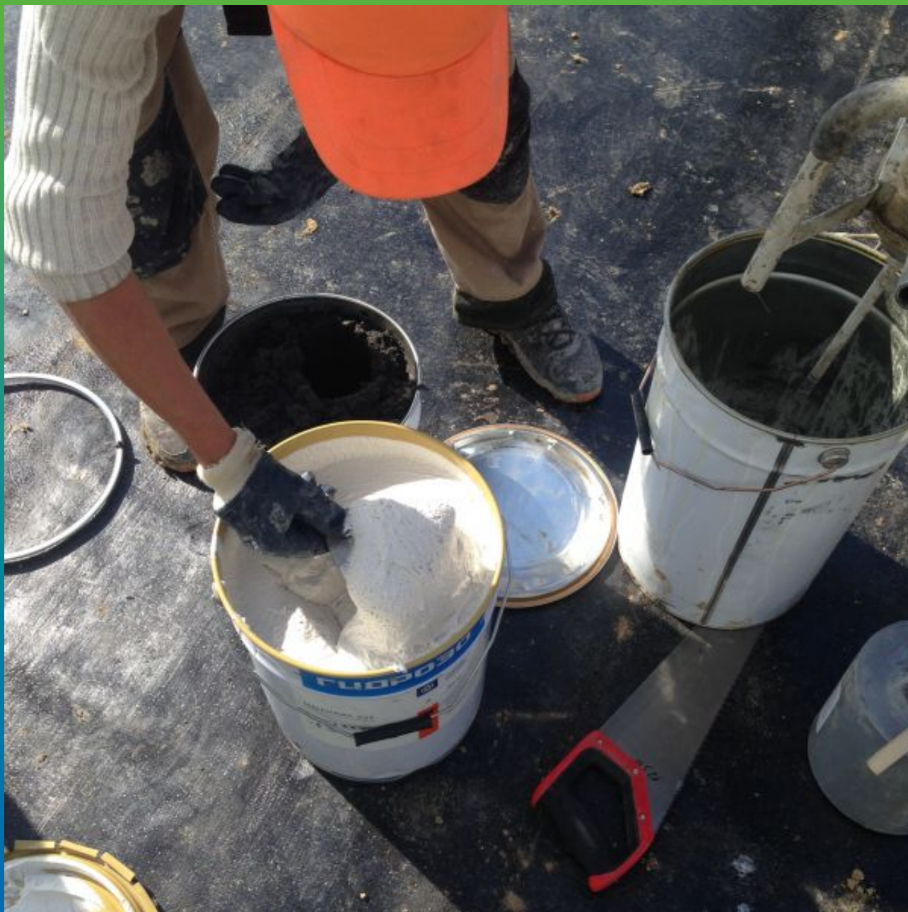
Перемешивание А+Б компонентов клея Манопокс 331
