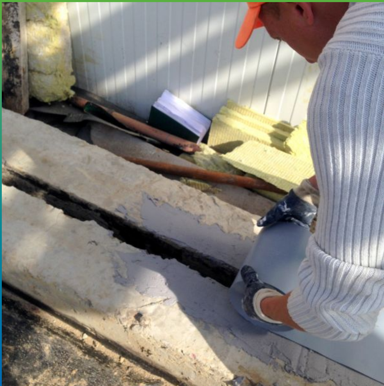
Монтаж ленты Манодил ПРО на клей Манопокс 331
