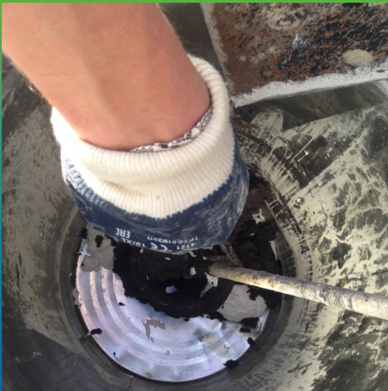
Перемешивание А+Б компонентов клея Манопокс 331
