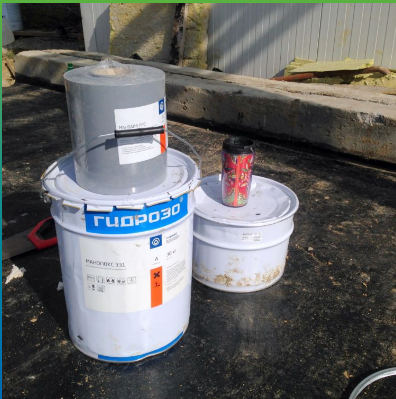
Материалы "Гидрозо" на объекте
