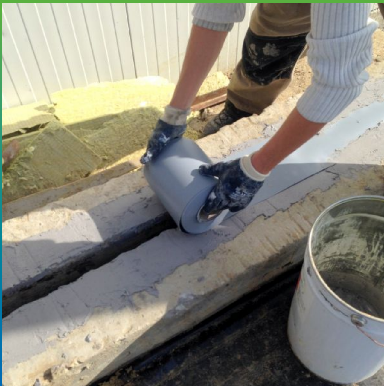
Монтаж ленты Манодил ПРО на клей Манопокс 331
