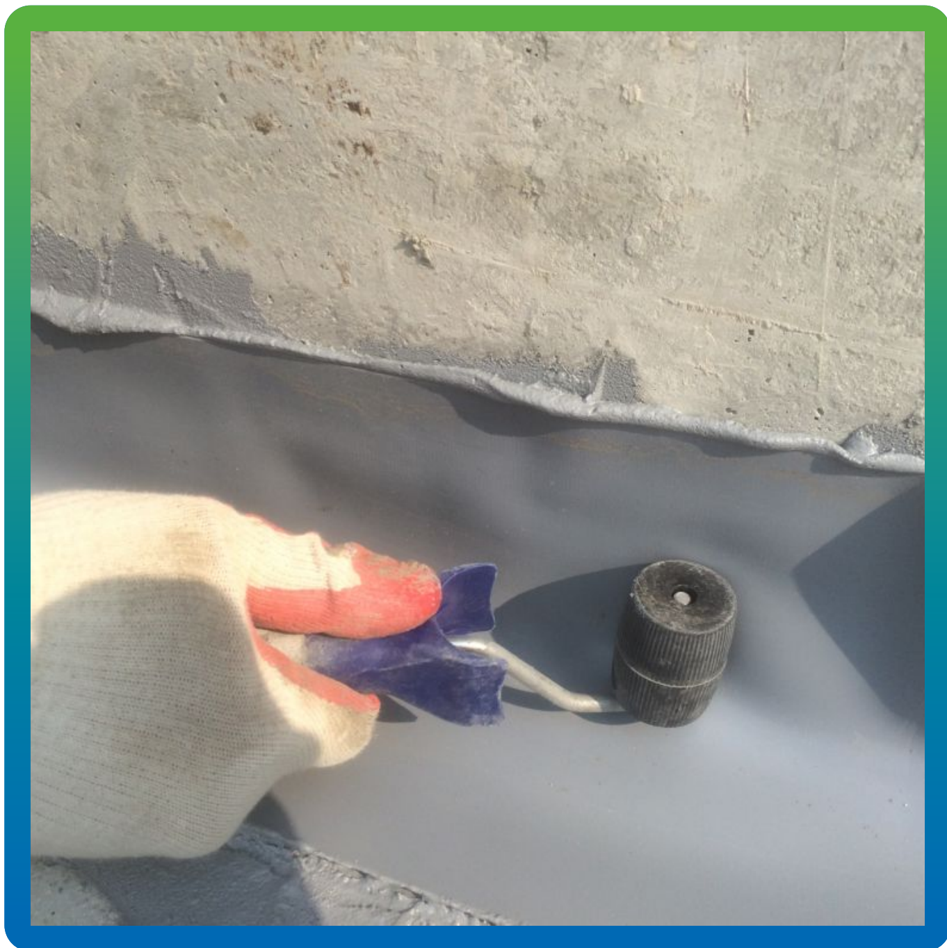
Монтаж гидроизоляционной ленты Манодил Про на адгезив Манопокс 331
