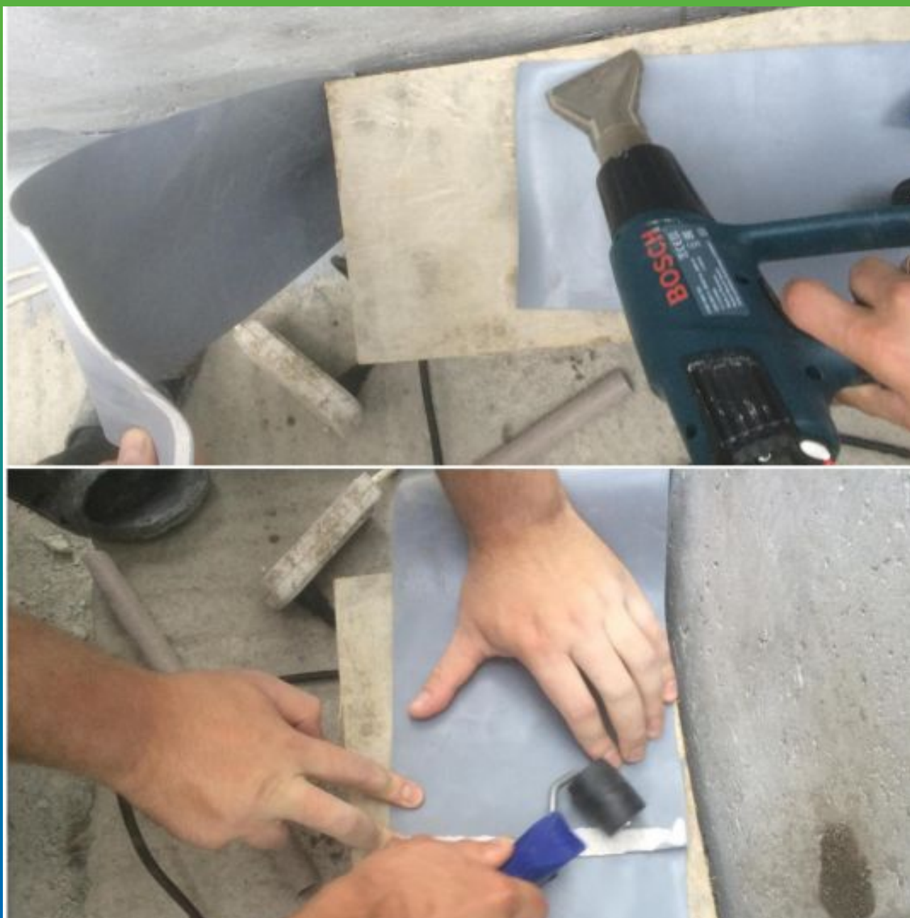
Сварка ленты Манодил Про с помощью горячего воздуха
