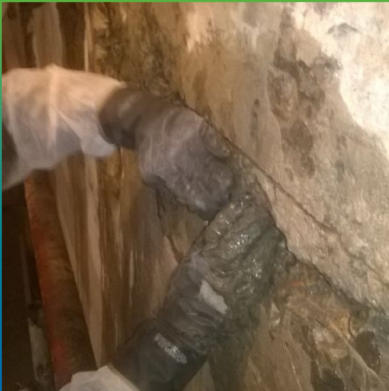
Зачеканка активных протечек участков составом Максплаг
