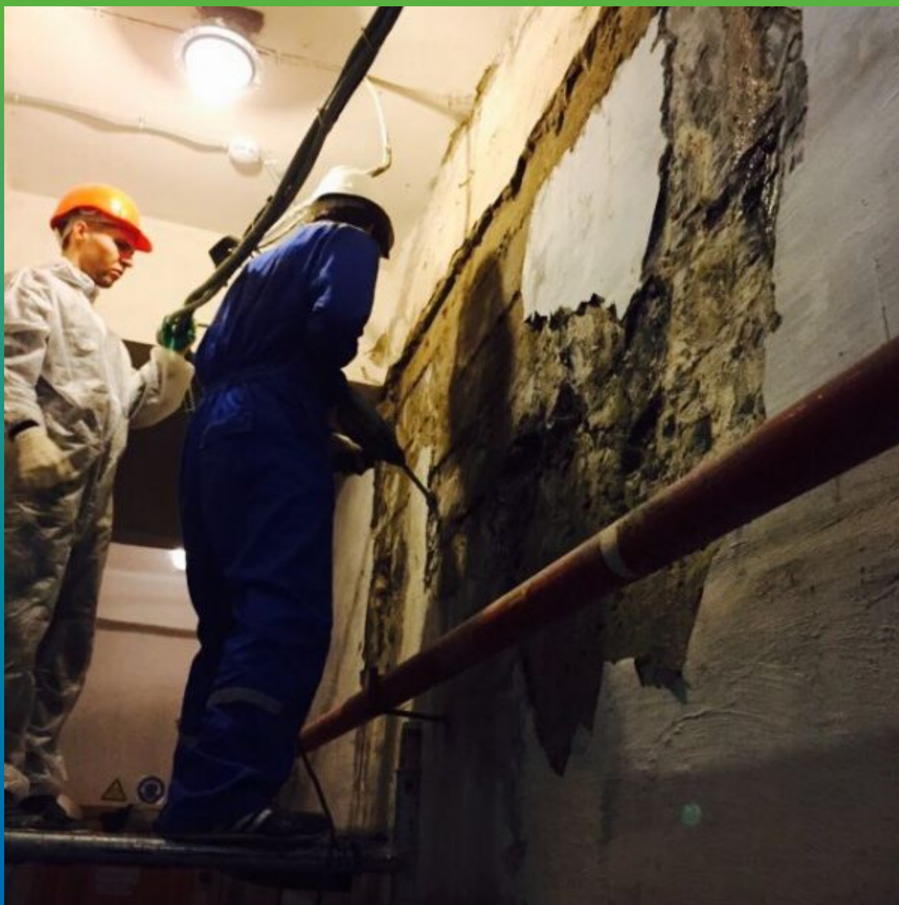
Демонтаж старой гидроизоляции.
