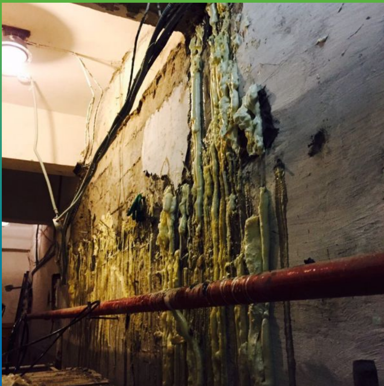
Стена после проведения двухстадийного инъе́ктирования.
