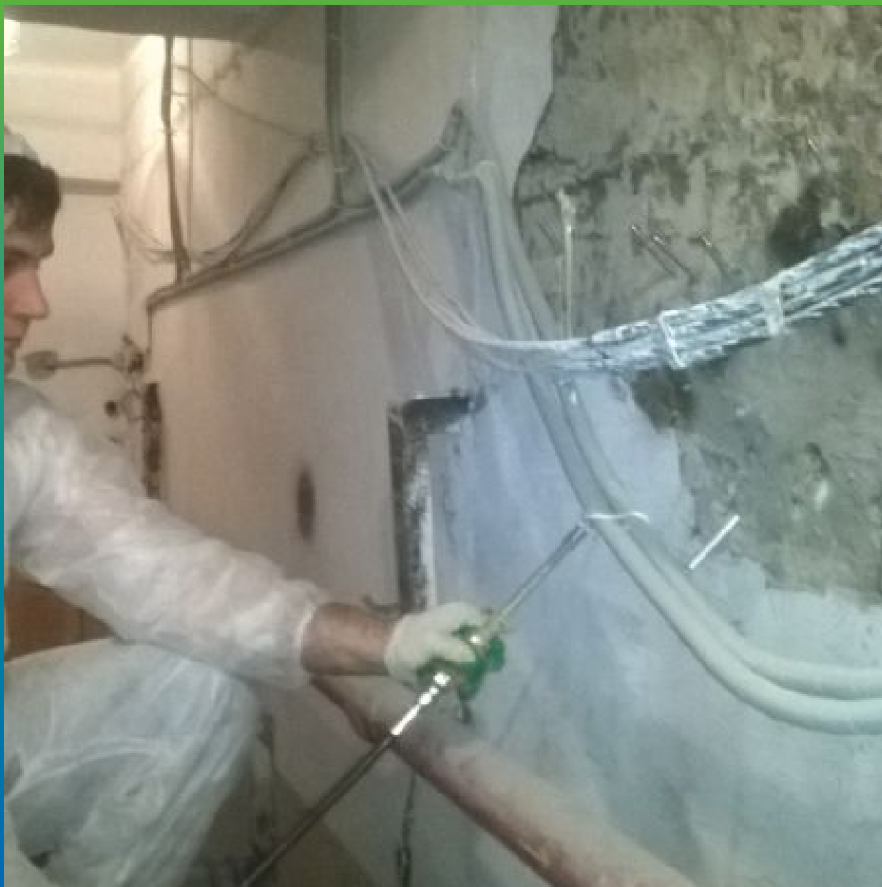
Последовательное инъе́ктирование Манопур 15 и Манопур 143.
