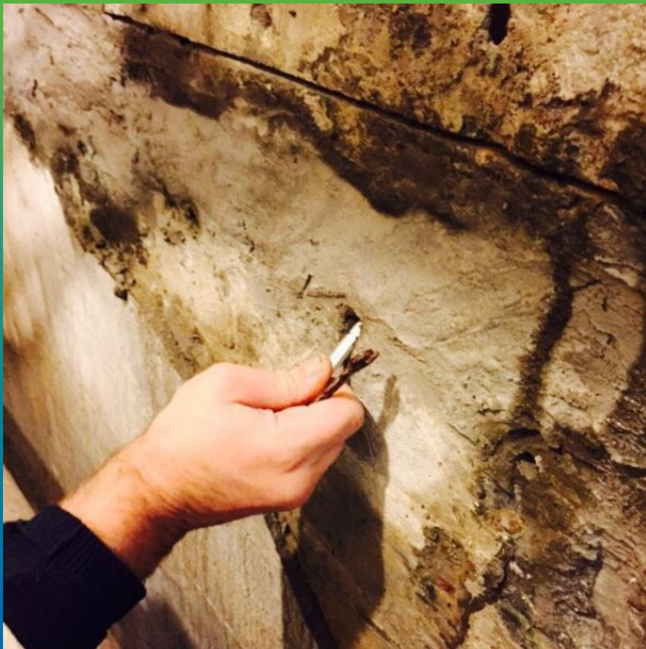
Установка пакеров в зачеканенные составом Максплаг участки
