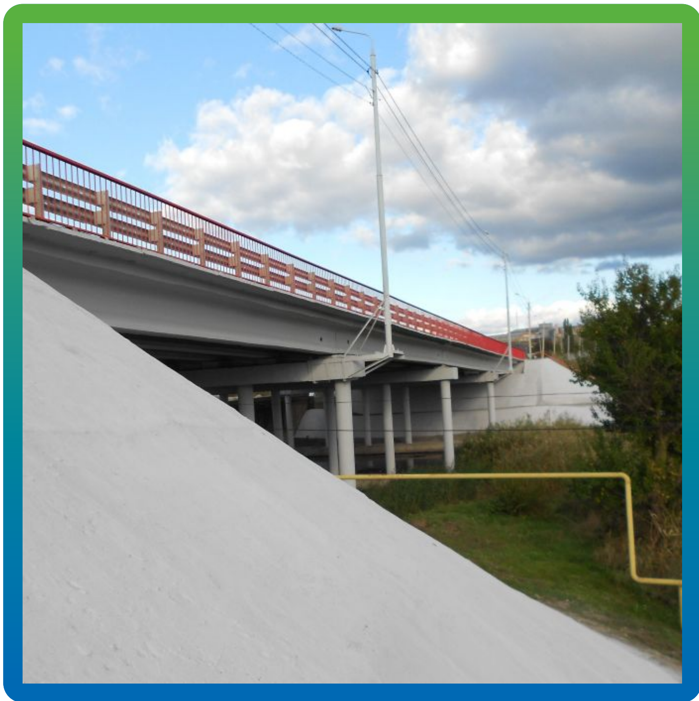
Вид на мост и конус после проведения ремонтных и окрасочных работ
