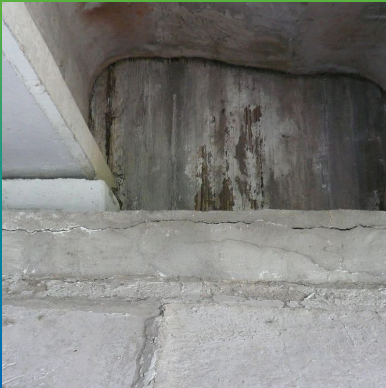
Опора моста до проведения ремонтных планово-предупредительных работ
