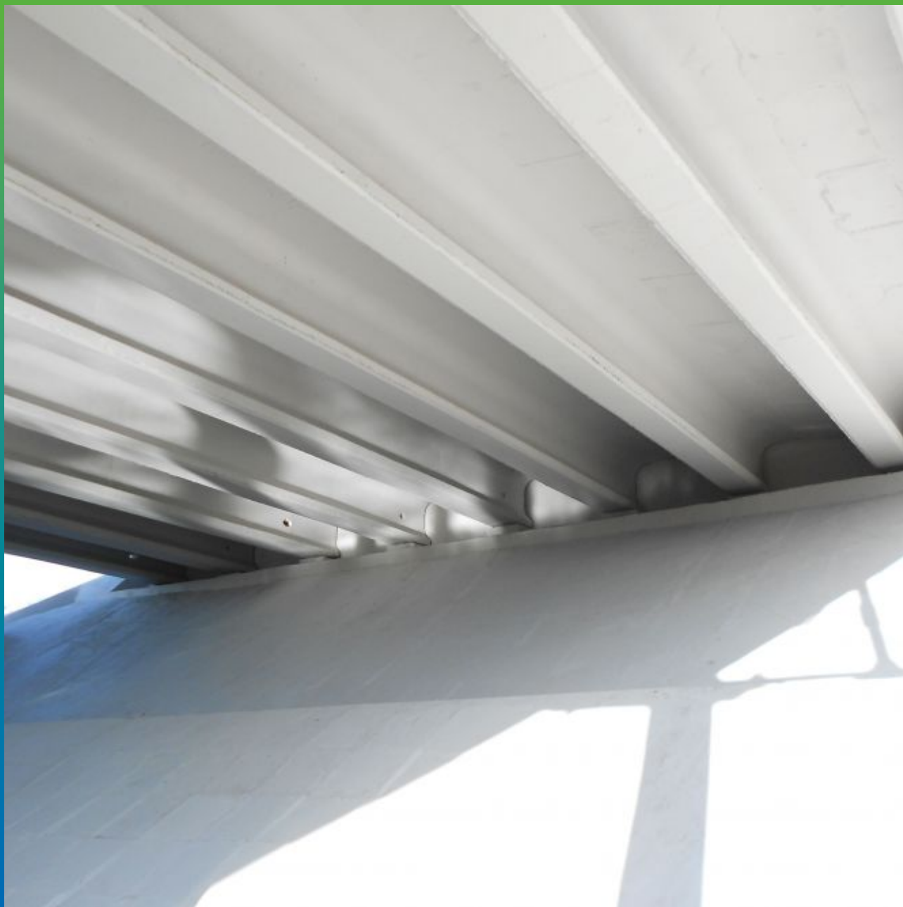
Вид после ремонта и окраски.
