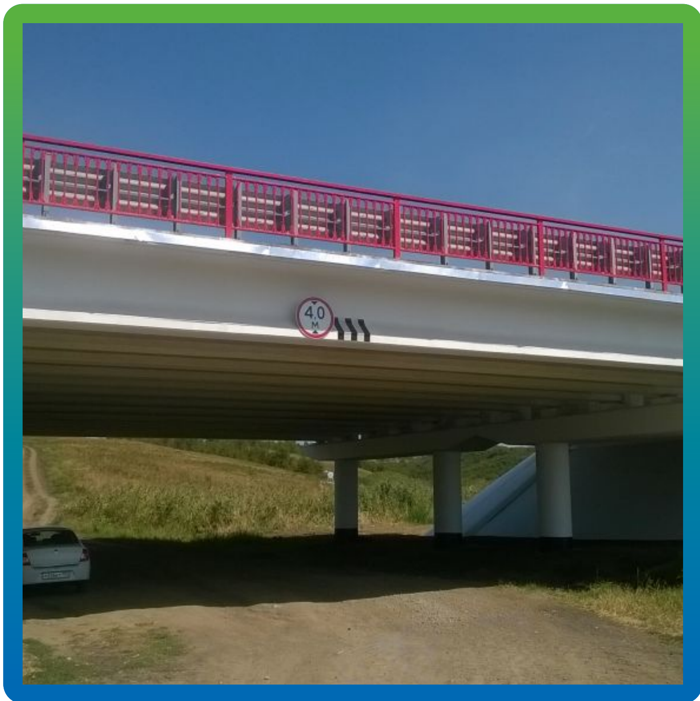
Общий вид моста после нанесения двух слоев покрытия ДенсТоп АК 220
