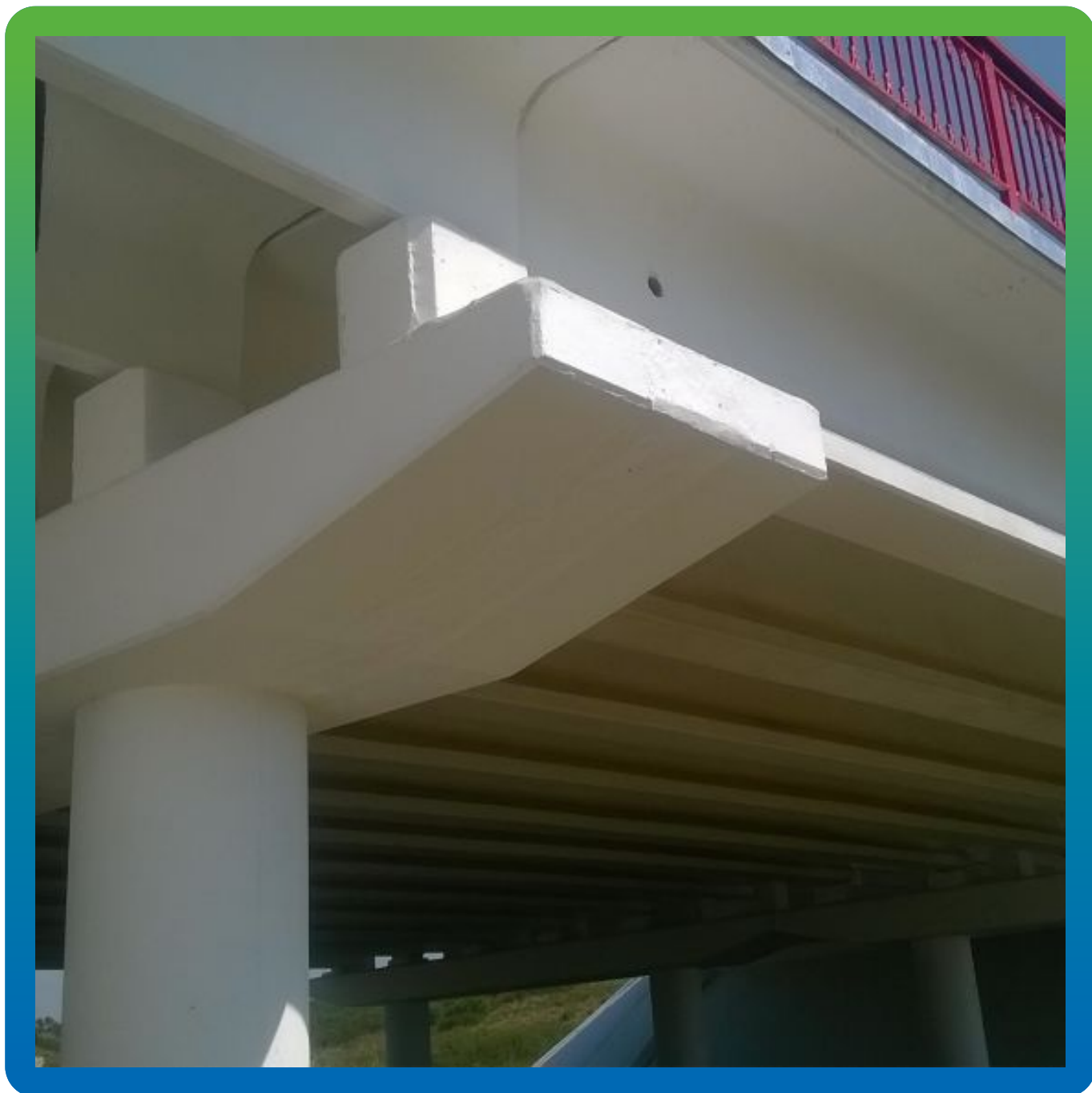
Вид моста после нанесения второго слоя краски
