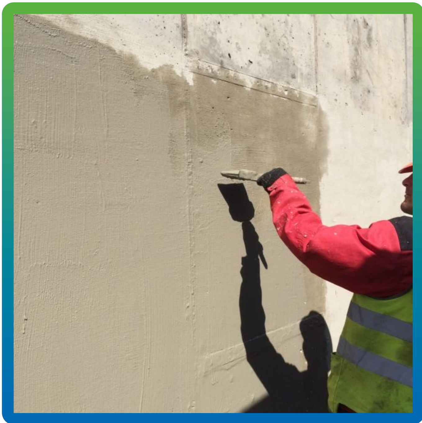
Нанесение обмазочной гидроизоляции Максил Супер
