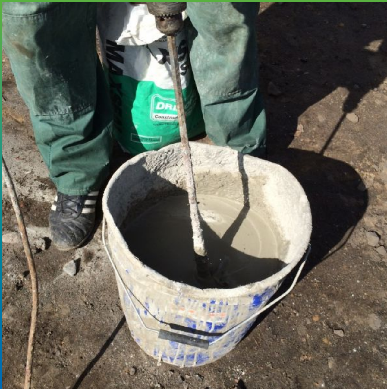
Приготовление обмазочной гидроизоляции Максил Супер
