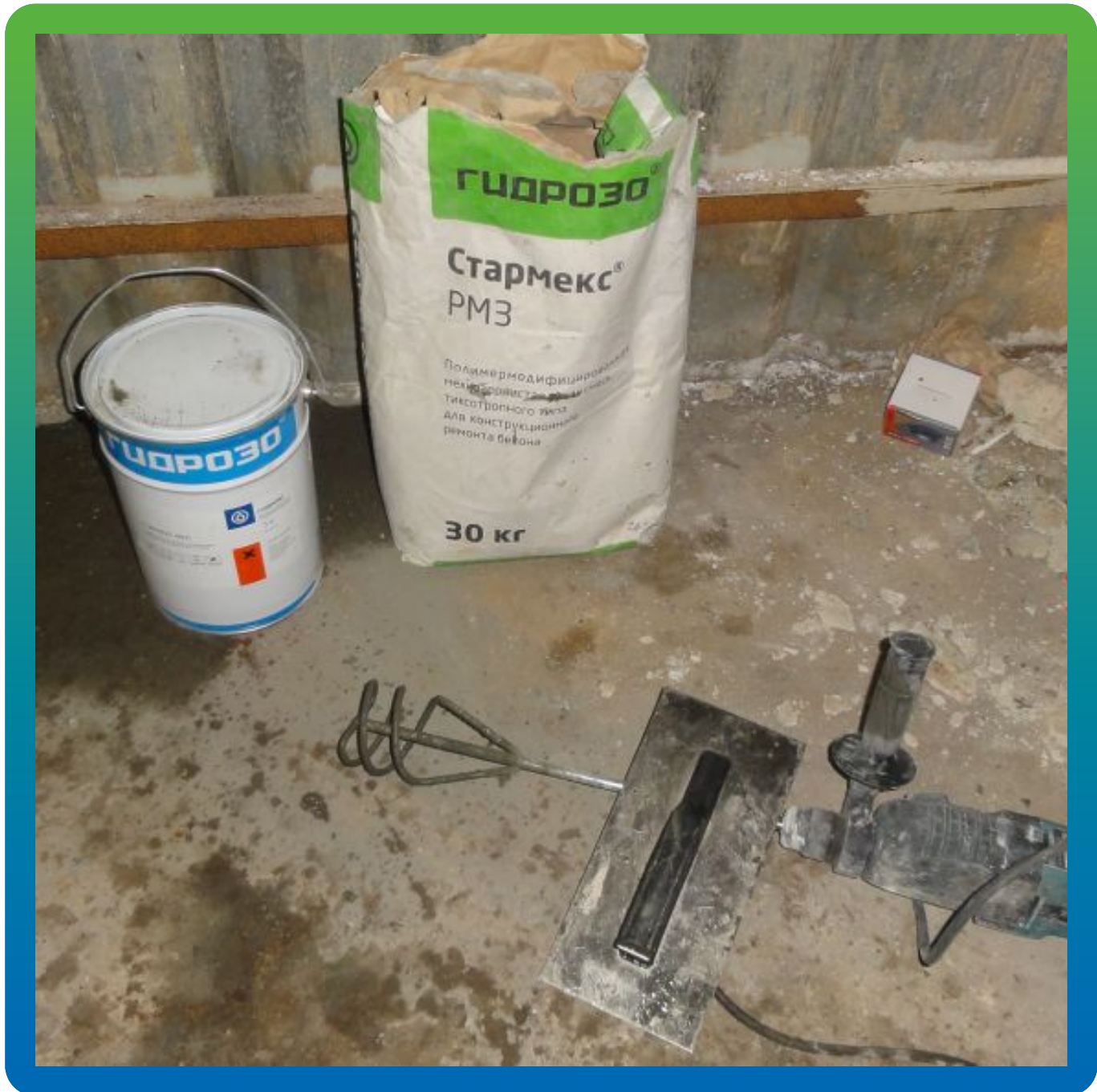
Материалы Гидрозо на объекте
