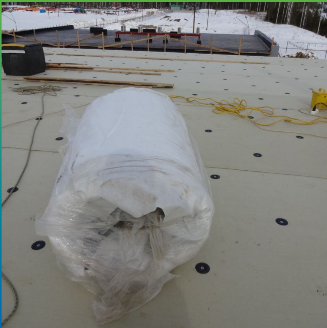
Мембрана Преласты СТ 1,2 мм на объекте, сваренная под размеры кровли
