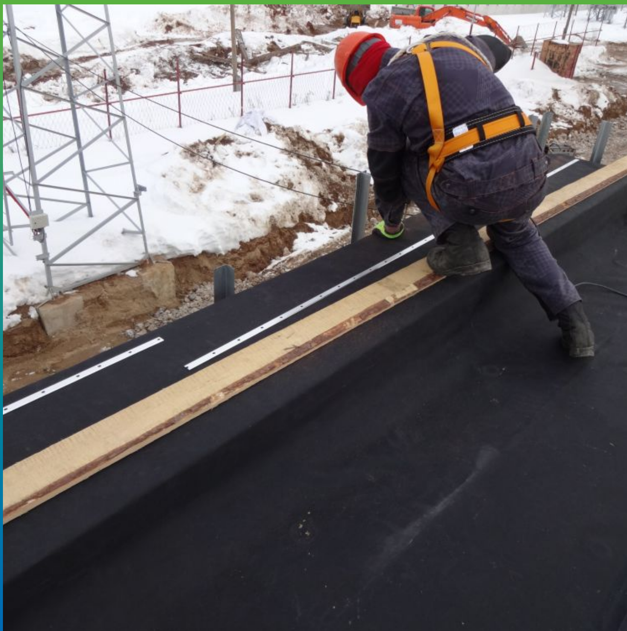
Монтаж мембраны под алюминиевую планку
