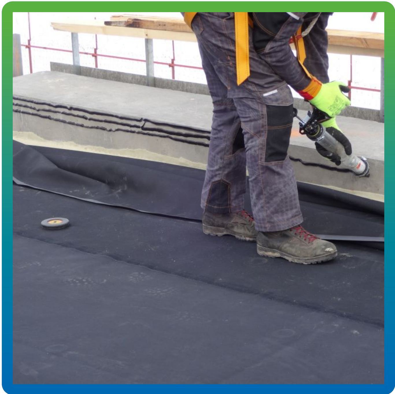
Приклеивание к мембраны к парапетам на герметик Витрафин Бонд Ф
