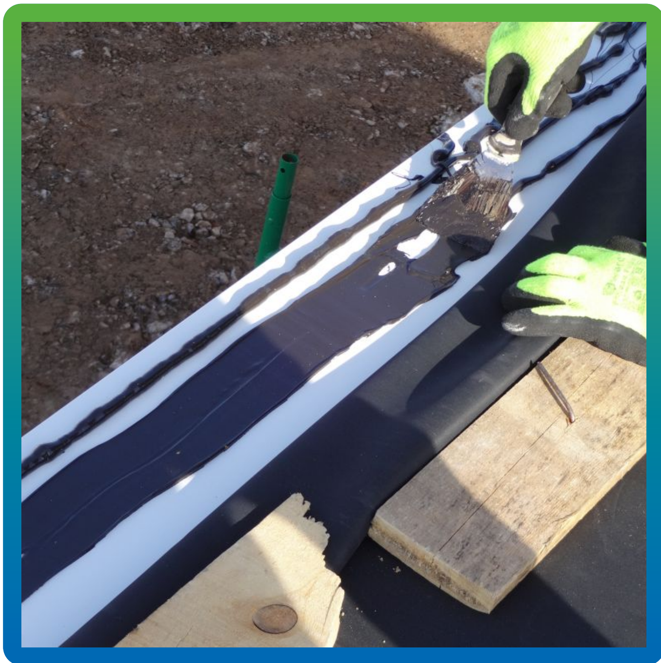
Приклеивание к капельнику мембраны на герметик Витрафин Бонд Ф
