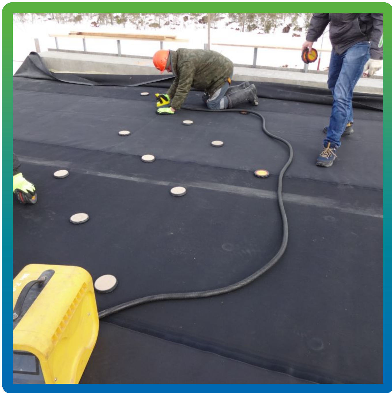
Приваривание шайб к мембране по технологии "Центрикс"
