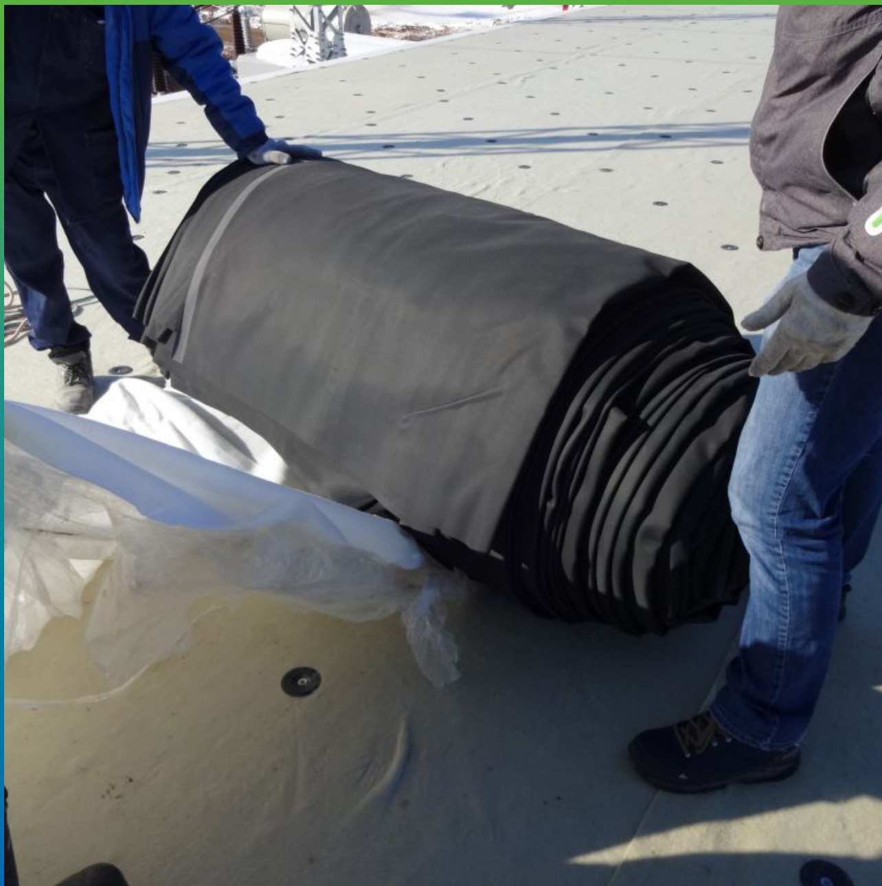
Растягивание сваренных под размер кровли карт
