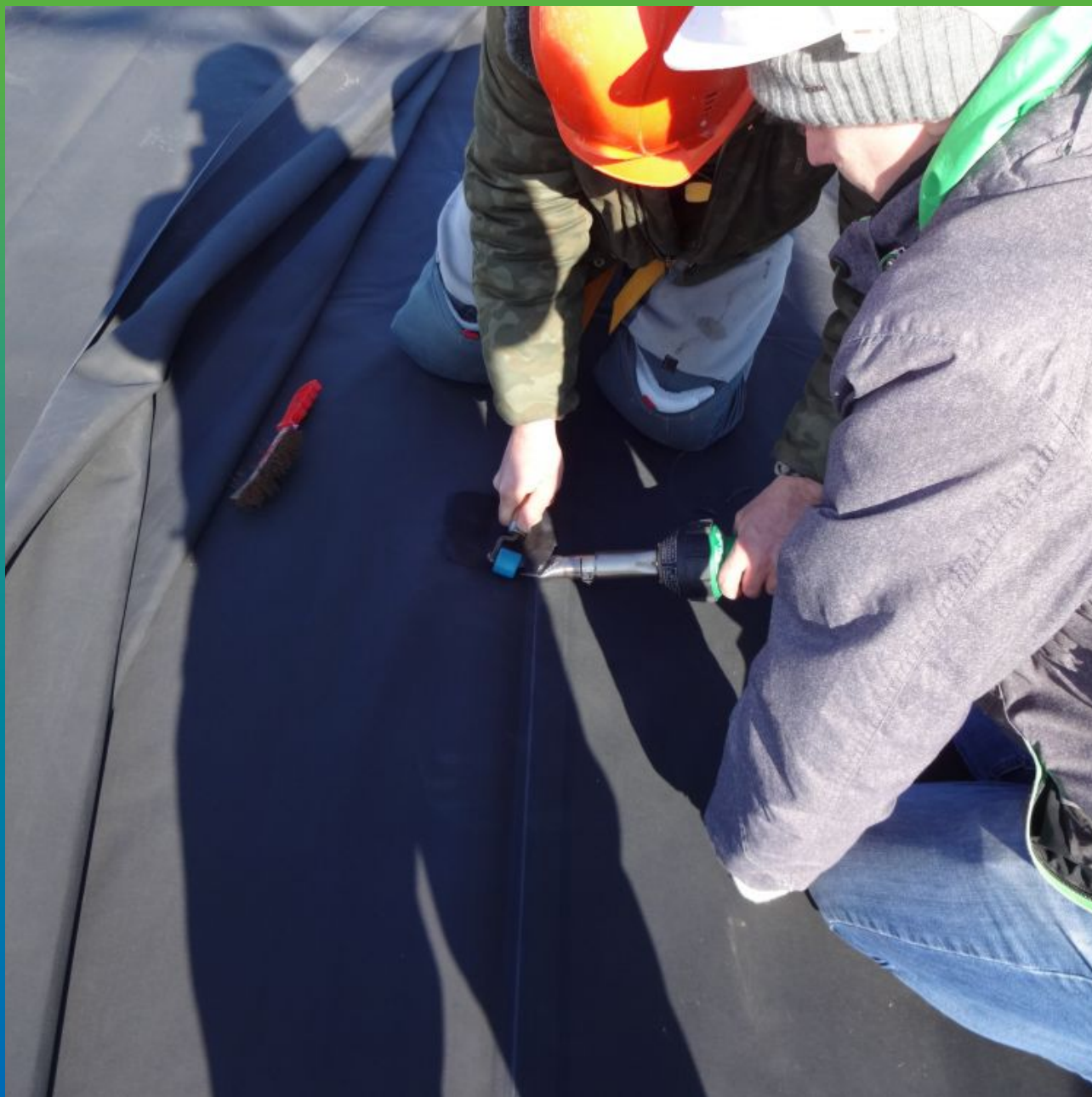
Сваривание горячим воздухом карт м/у собой
