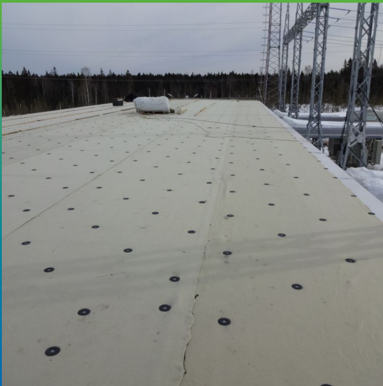
Смонтированные шайбы "Центрикс" на кровле
