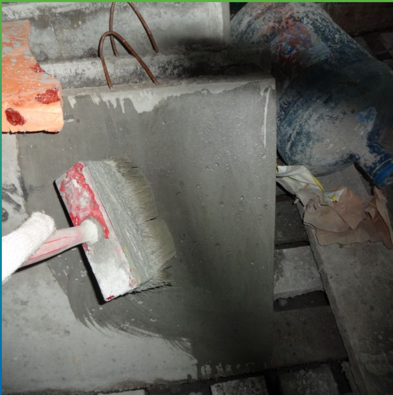
Увлажнение основания перед нанесением Стармекс Сил
