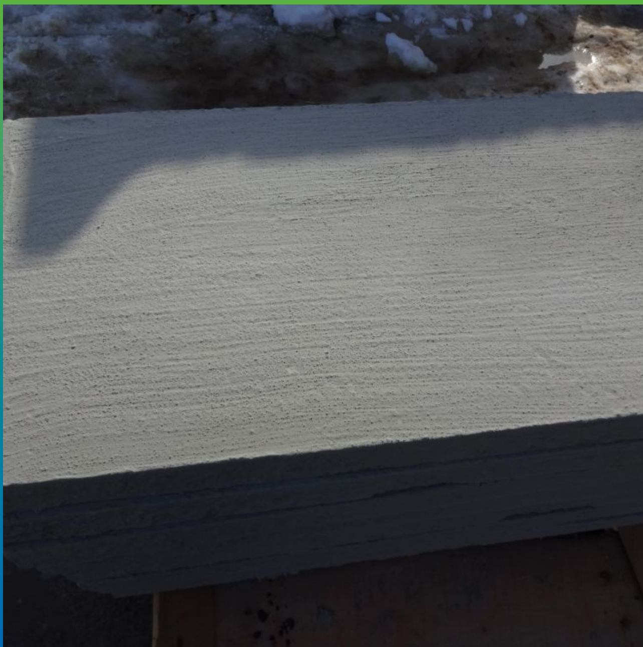
Лотки после нанесения Стармекс Сил
