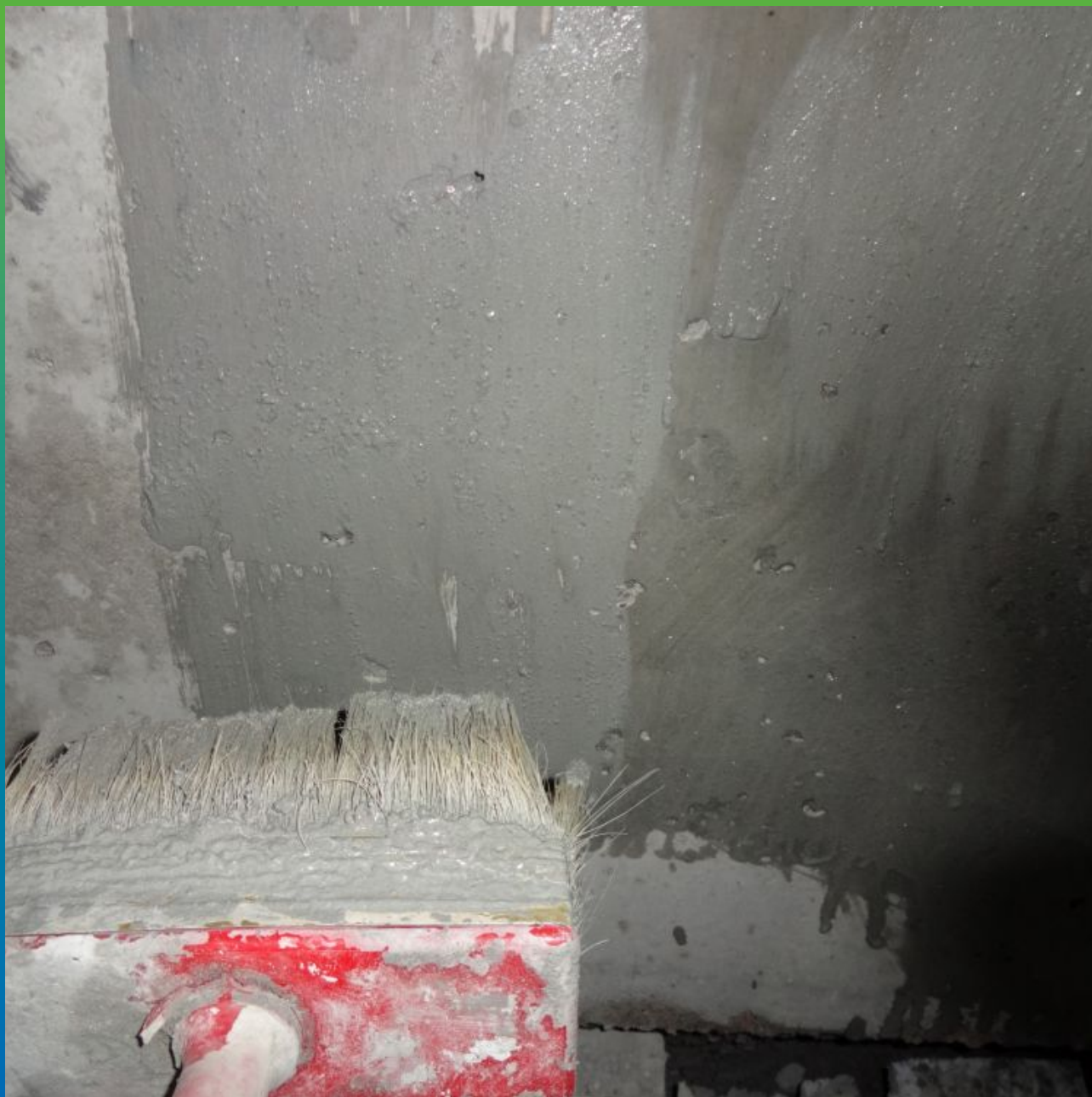
Нанесение Стармекс Сил по увлажненному основанию
