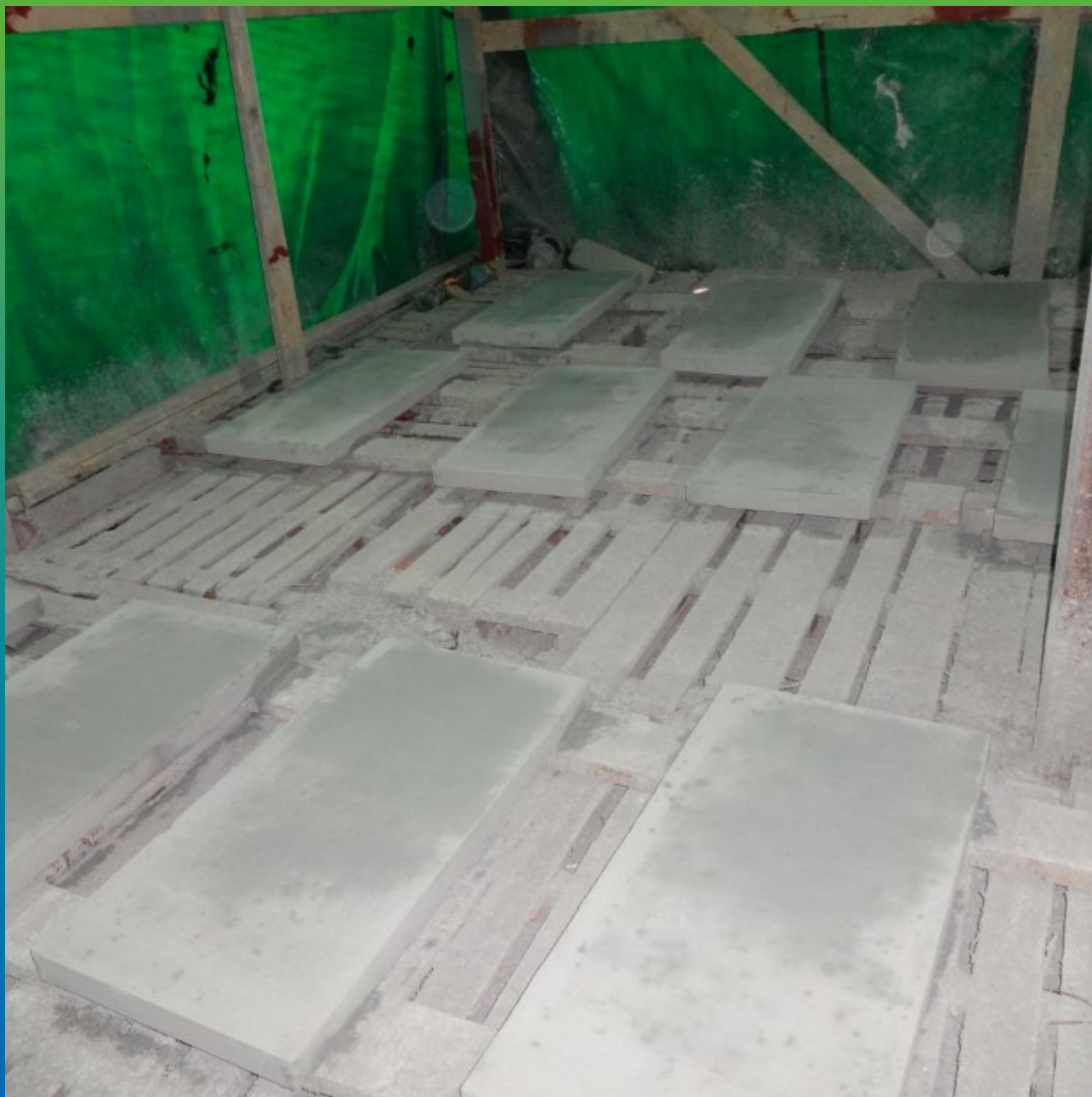
Лотки после нанесения Стармекс Сил
