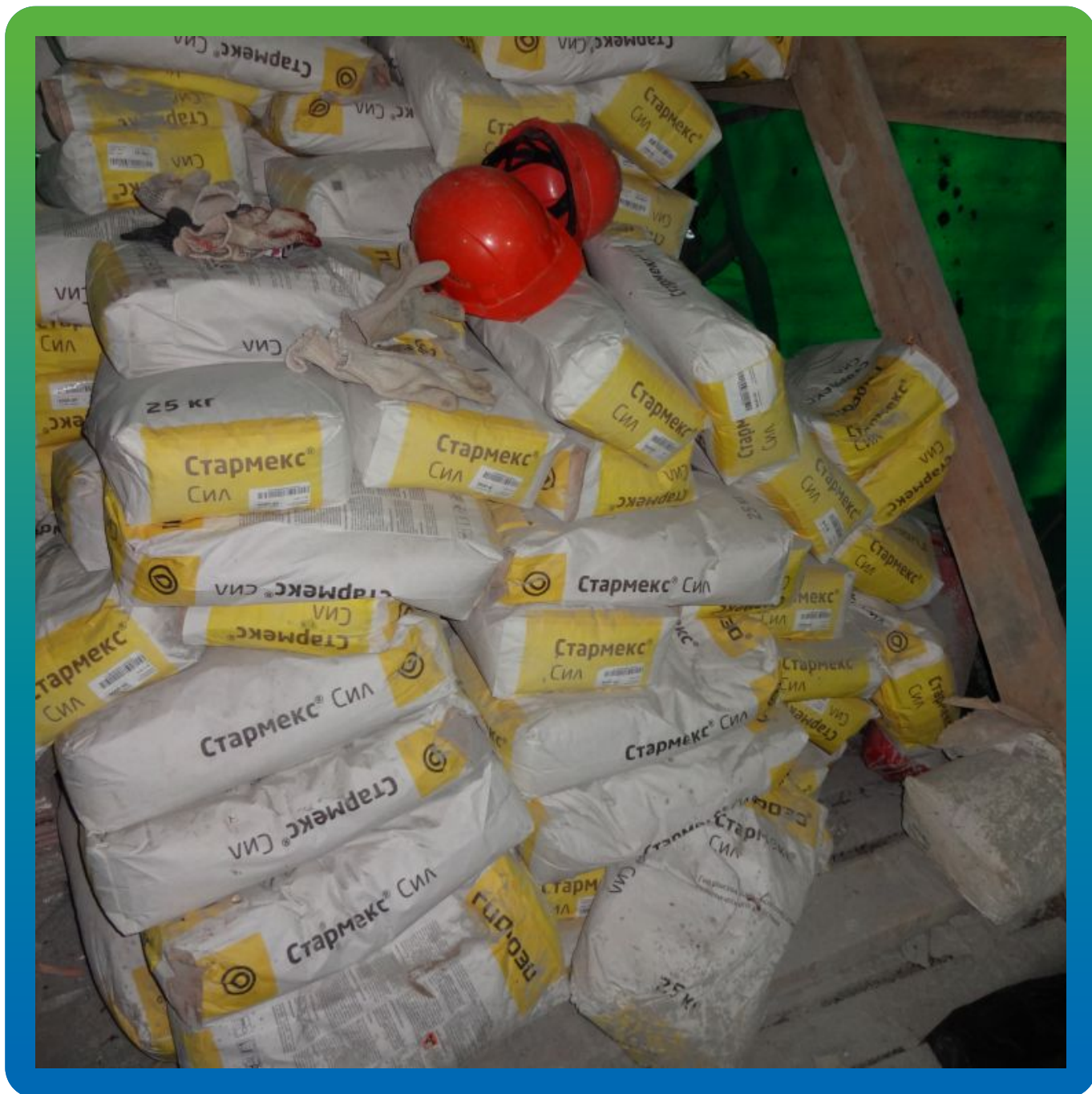
Материалы "Гидрозо" на объекте
