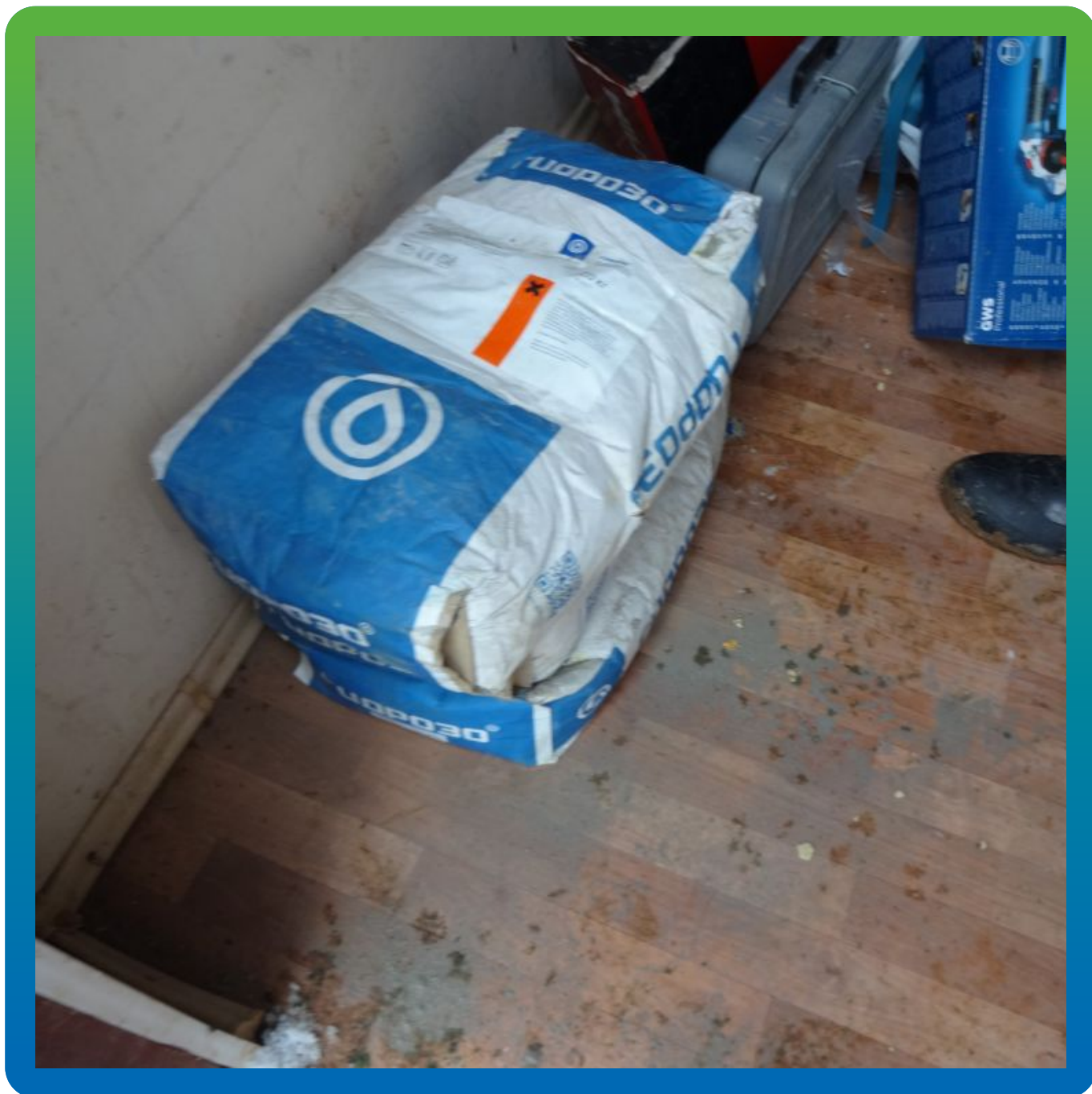
Материалы "Гидрозо" на объекте
