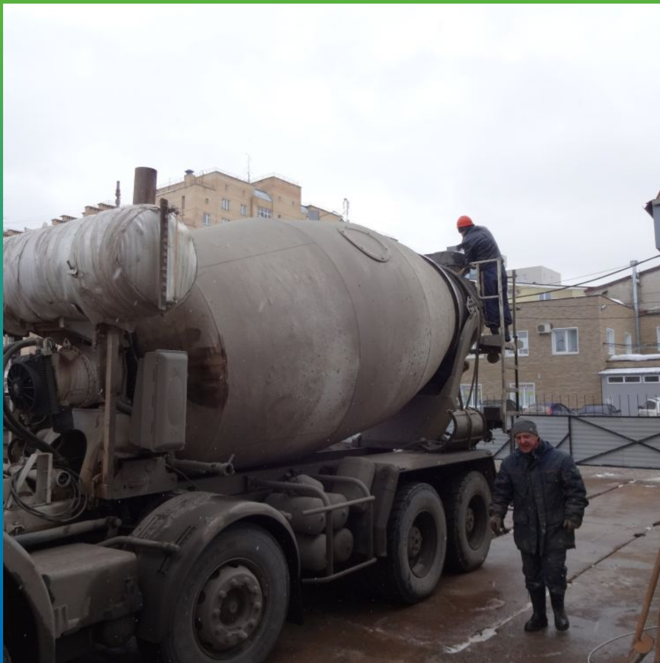
Заливка приготовленный раствора в бетонную смесь
