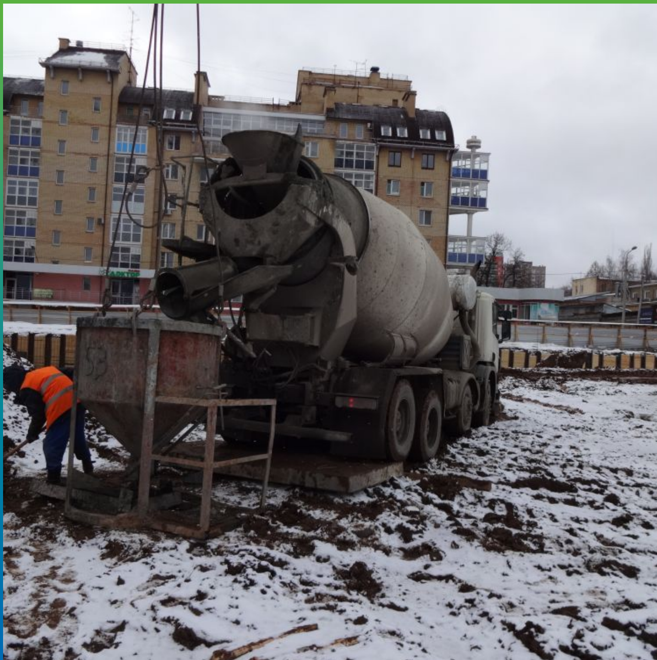
Монтаж бетонных конструкций с добавкой Реолен Адмикс
