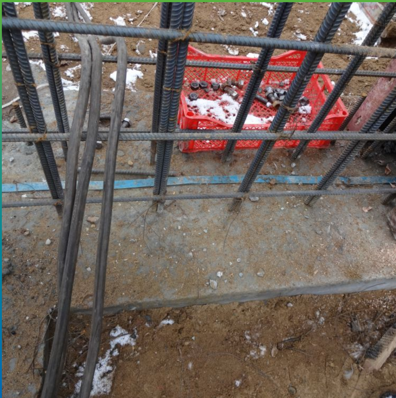
Смонтированный набухающий профиль Манодил Свелл X-2003
