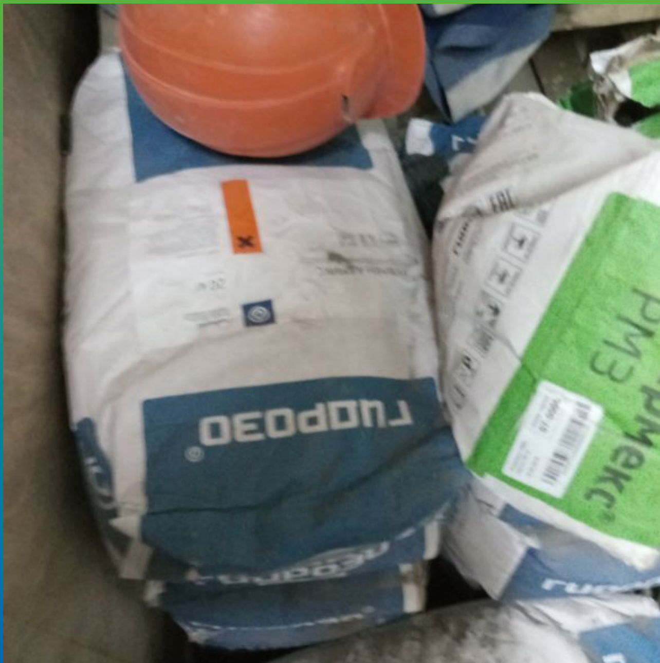
Материалы Гидрозо на объекте
