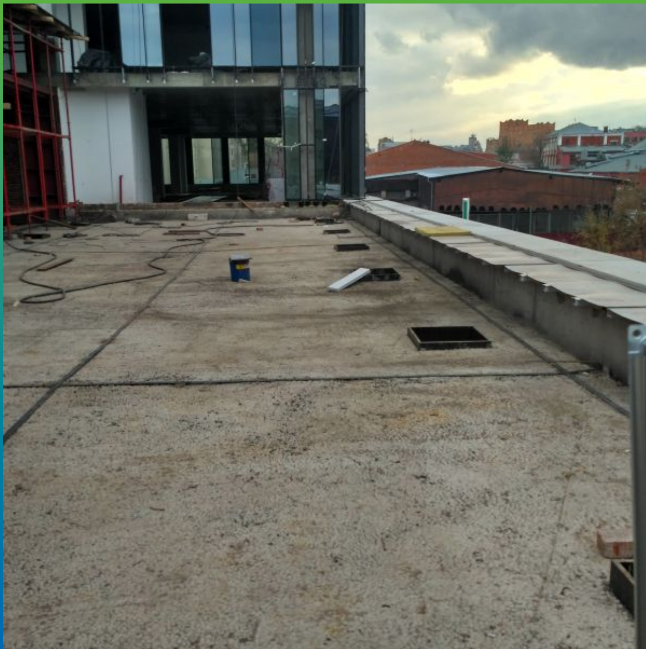
Вид кровли до монтажа мембраны
