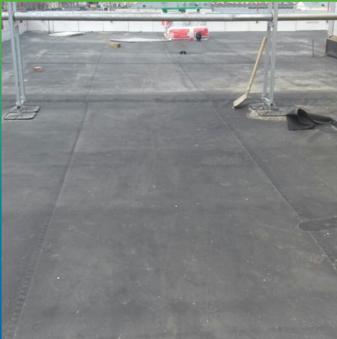
Устройство примыканий и монтаж ЭПДМ мембраны Преласты СТ к горизонтальному основанию
