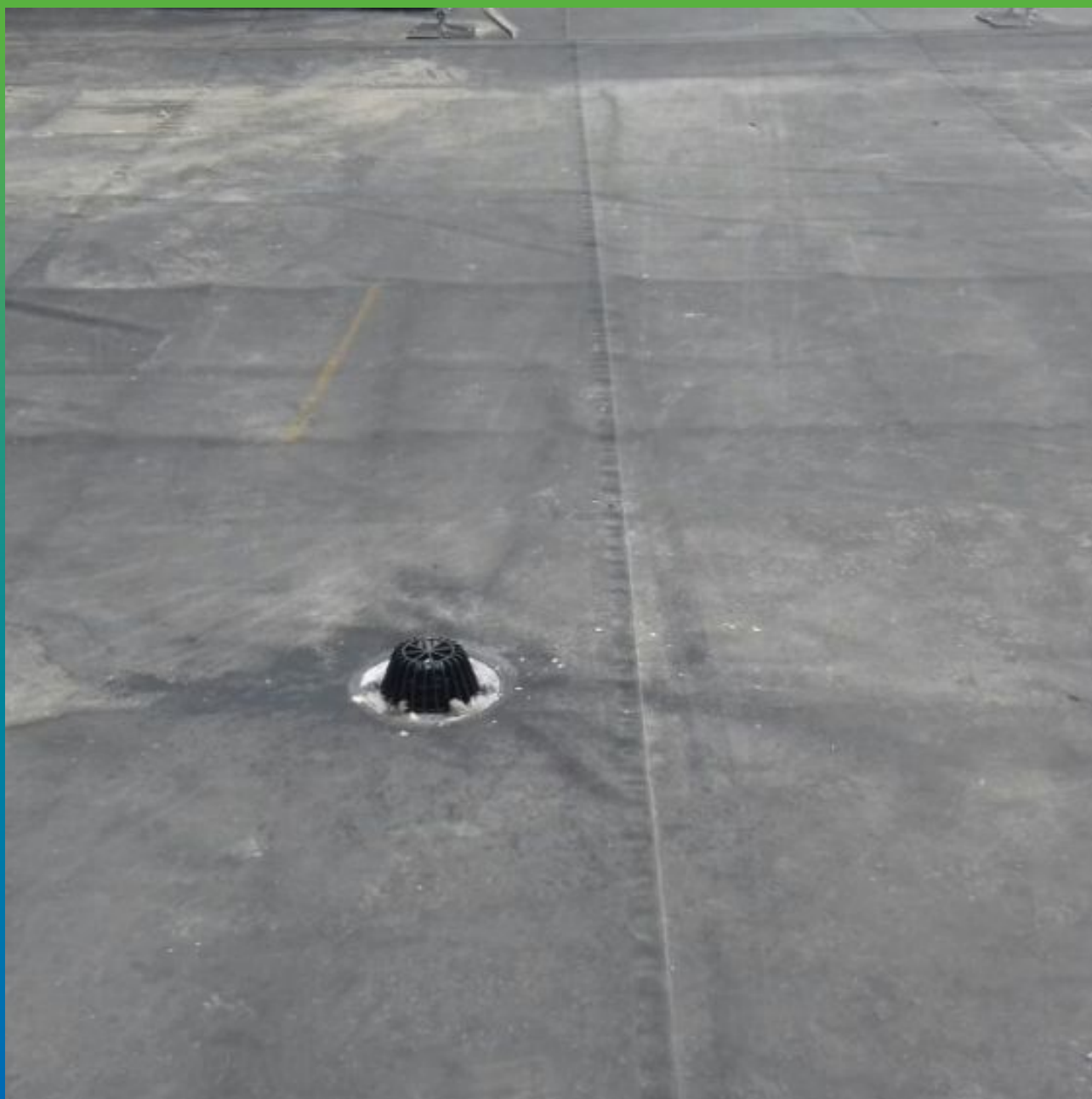
Устройство водосточных воронок
