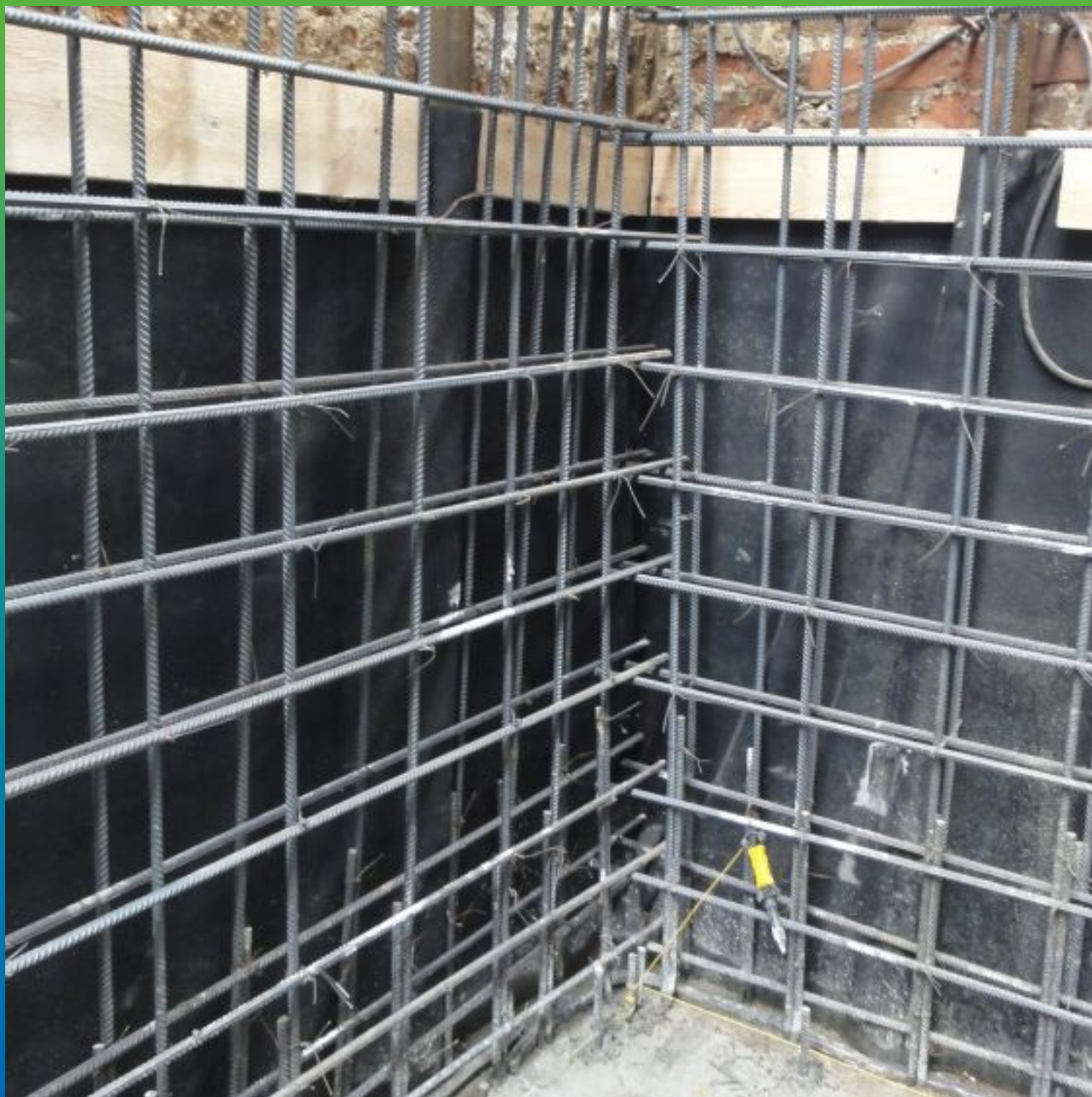
Монтаж ЭПДМ мембраны Преласты СТ 1,2
