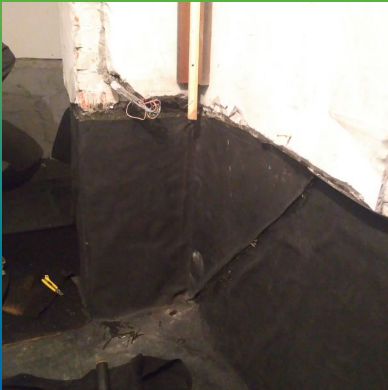
Устройство примыканий - внутренний угол (конверт)
