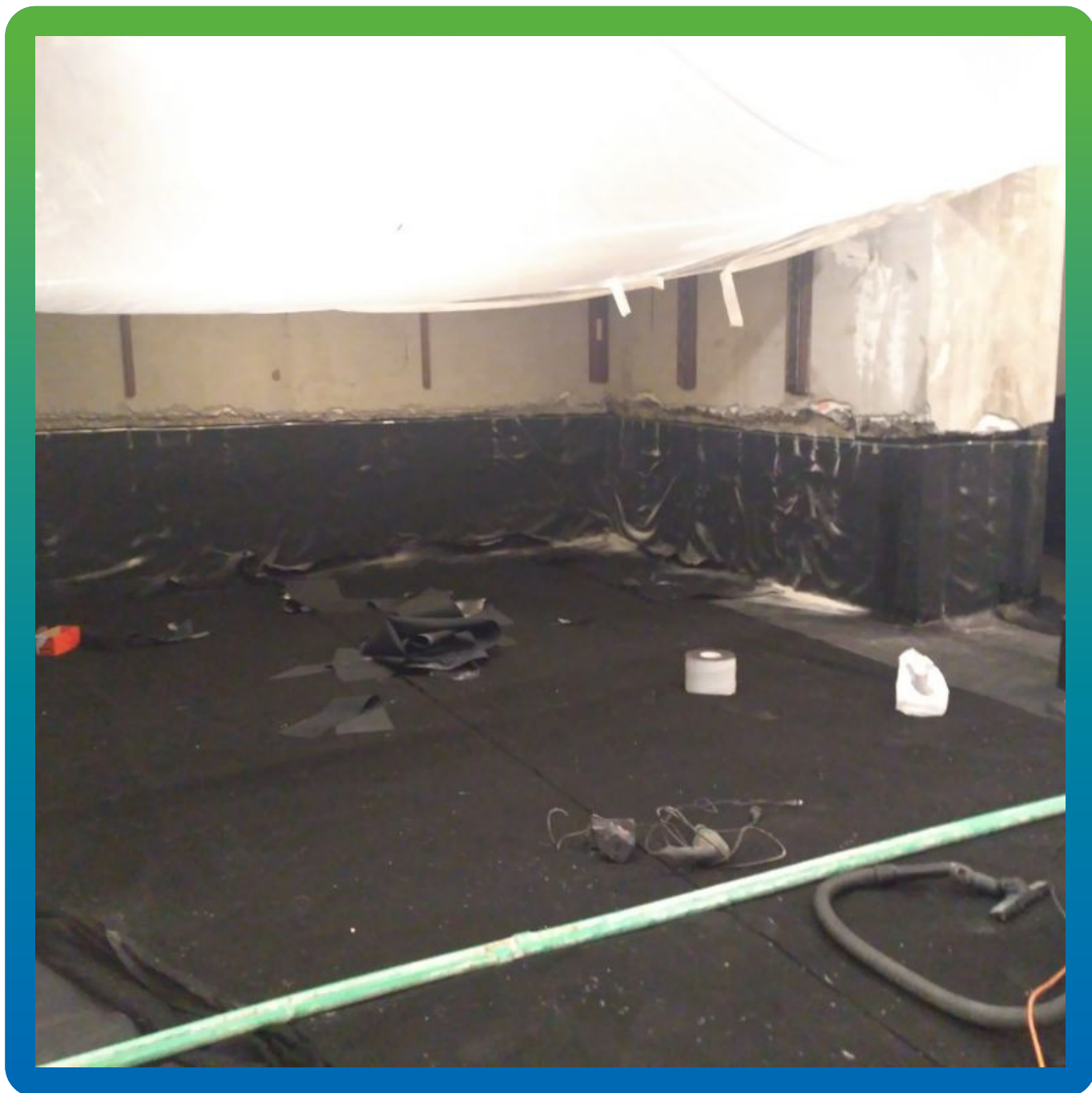
Вид объекта после монтажа ЭПДМ мембраны Преласты СТ
