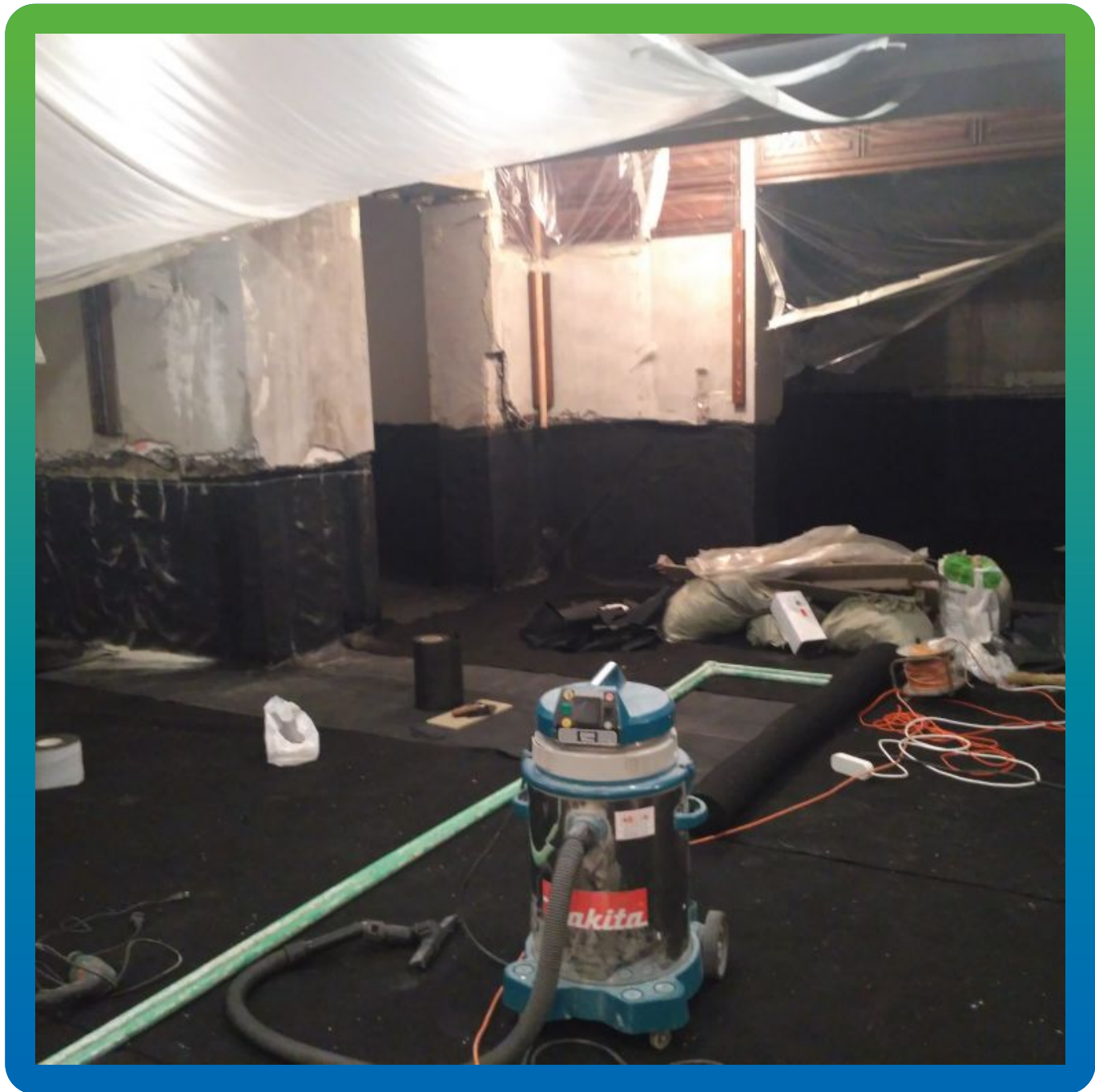
Вид объекта после монтажа ЭПДМ мембраны Прелести СТ
