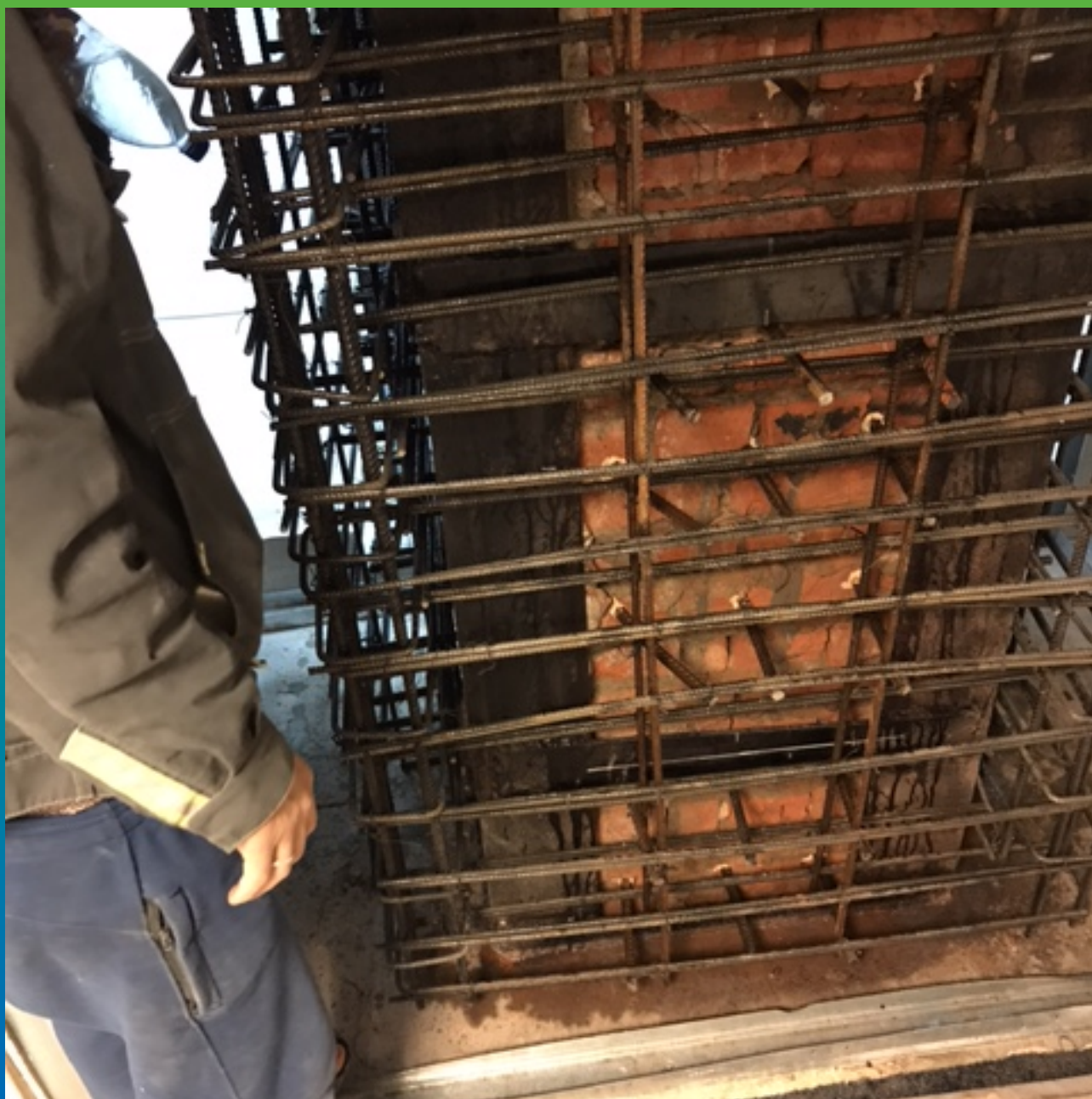
Вид колонны до усиления
