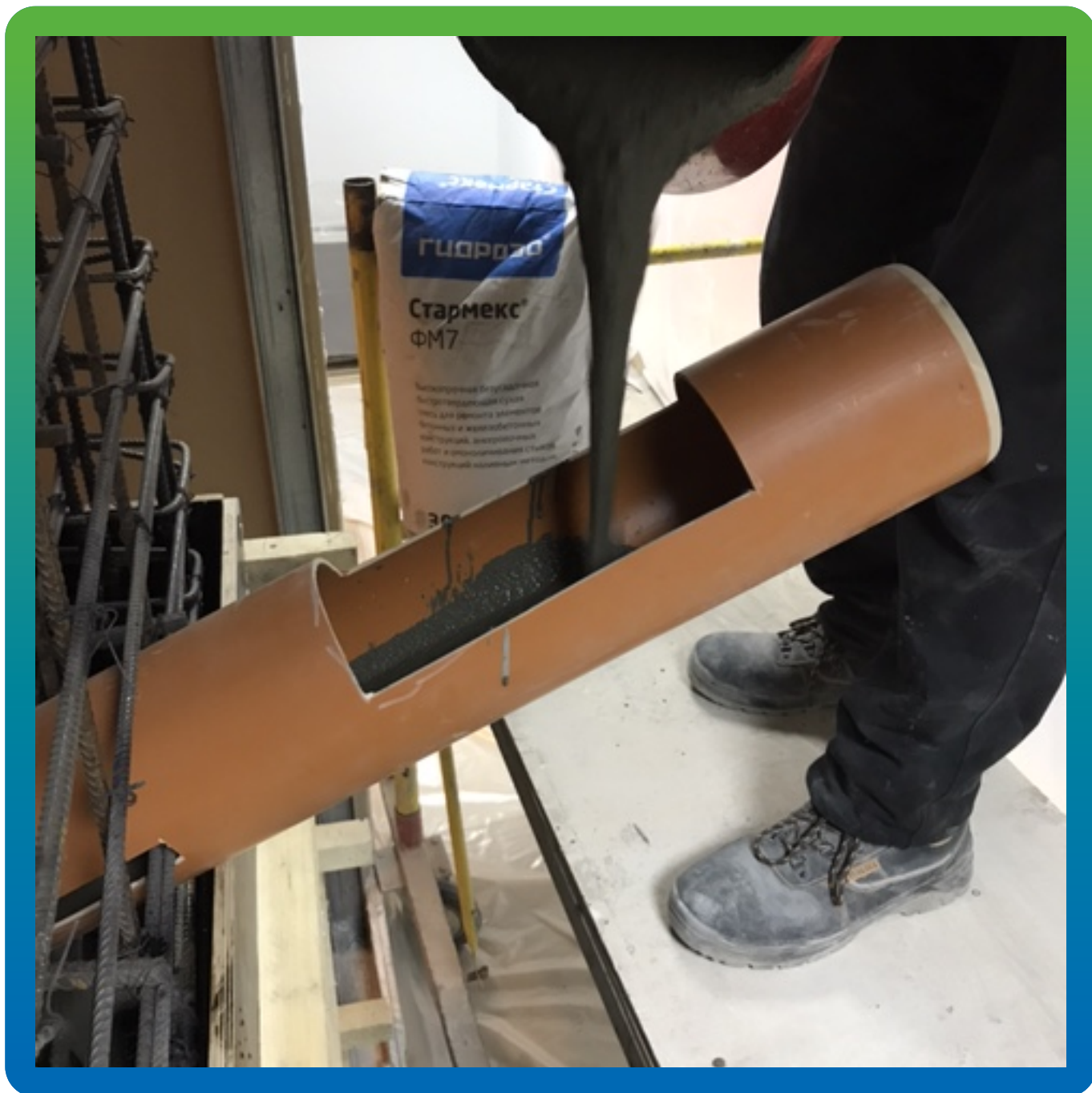
Заливка Стармекс ФМ 7 в опалубку
