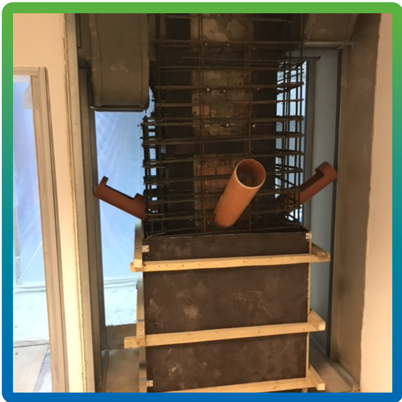
Установка опалубки, подготовка к заливке состава
