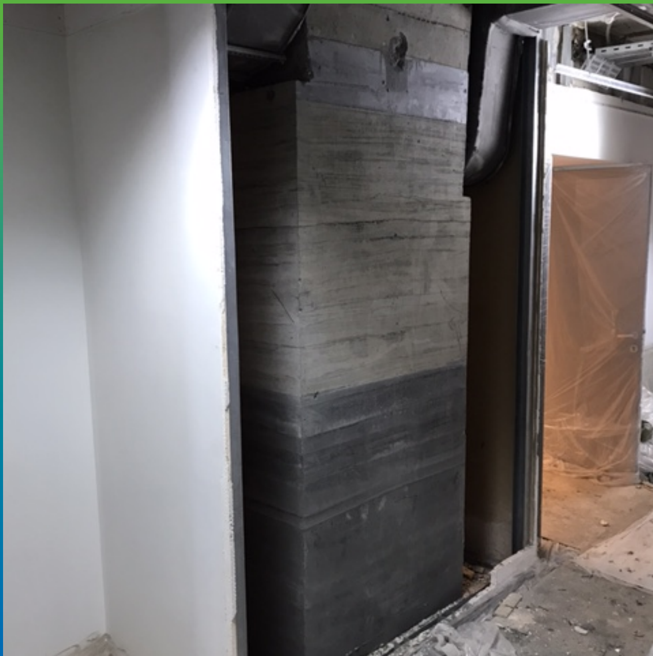
Готовая колонна из подливочного состава Стармекс ФМ7
