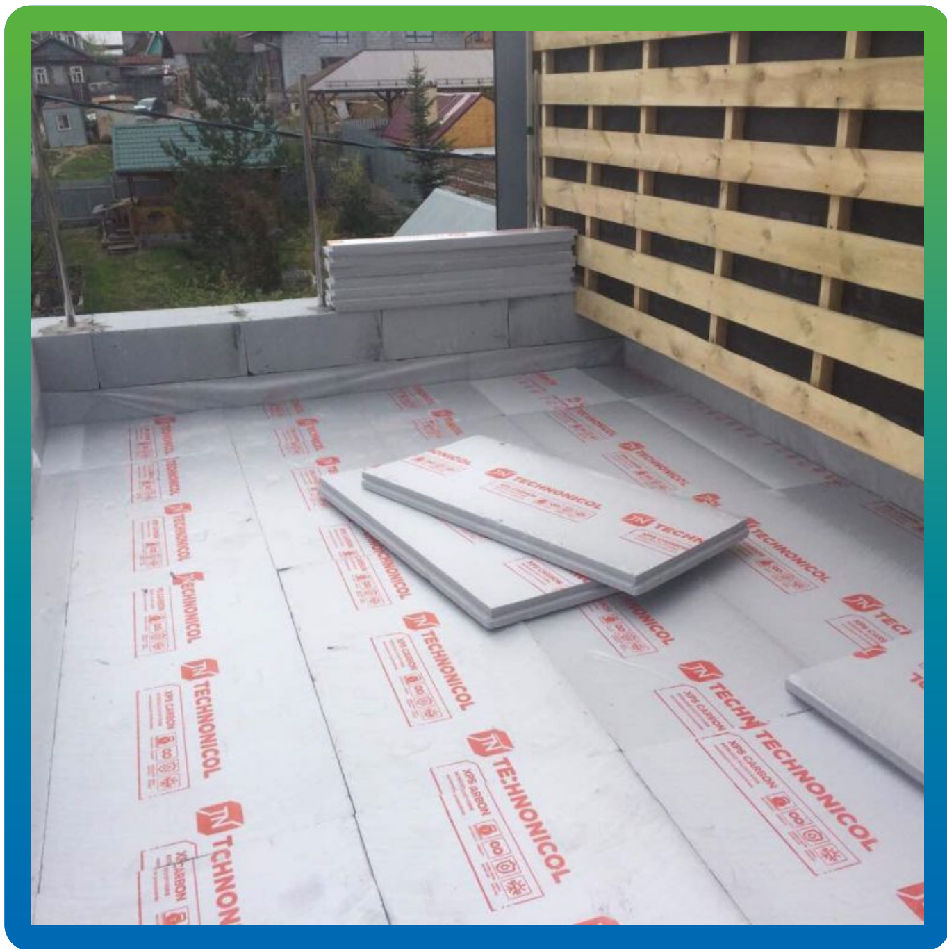
Укладка утеплителя
