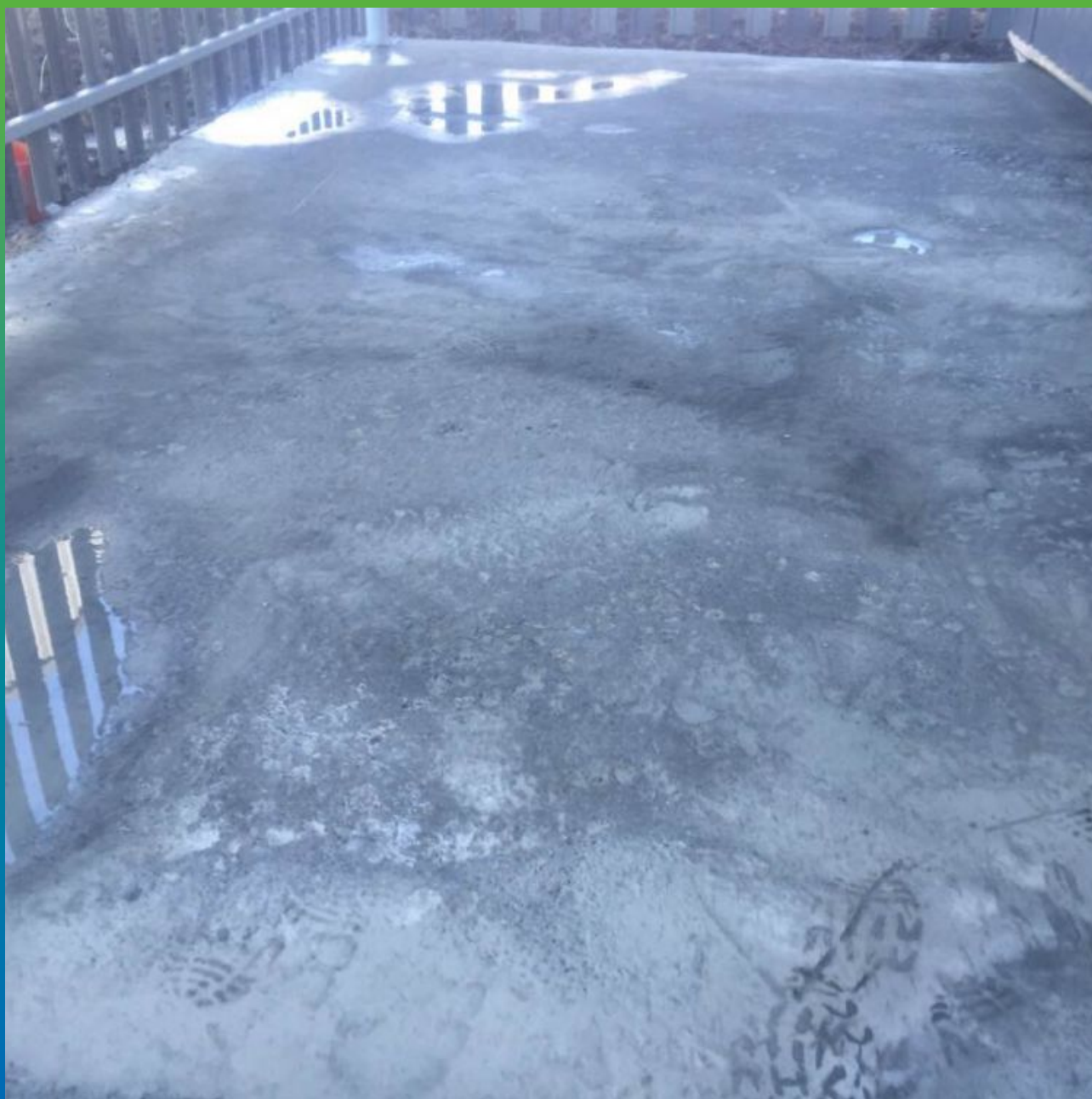
Первоначальный вид основания
