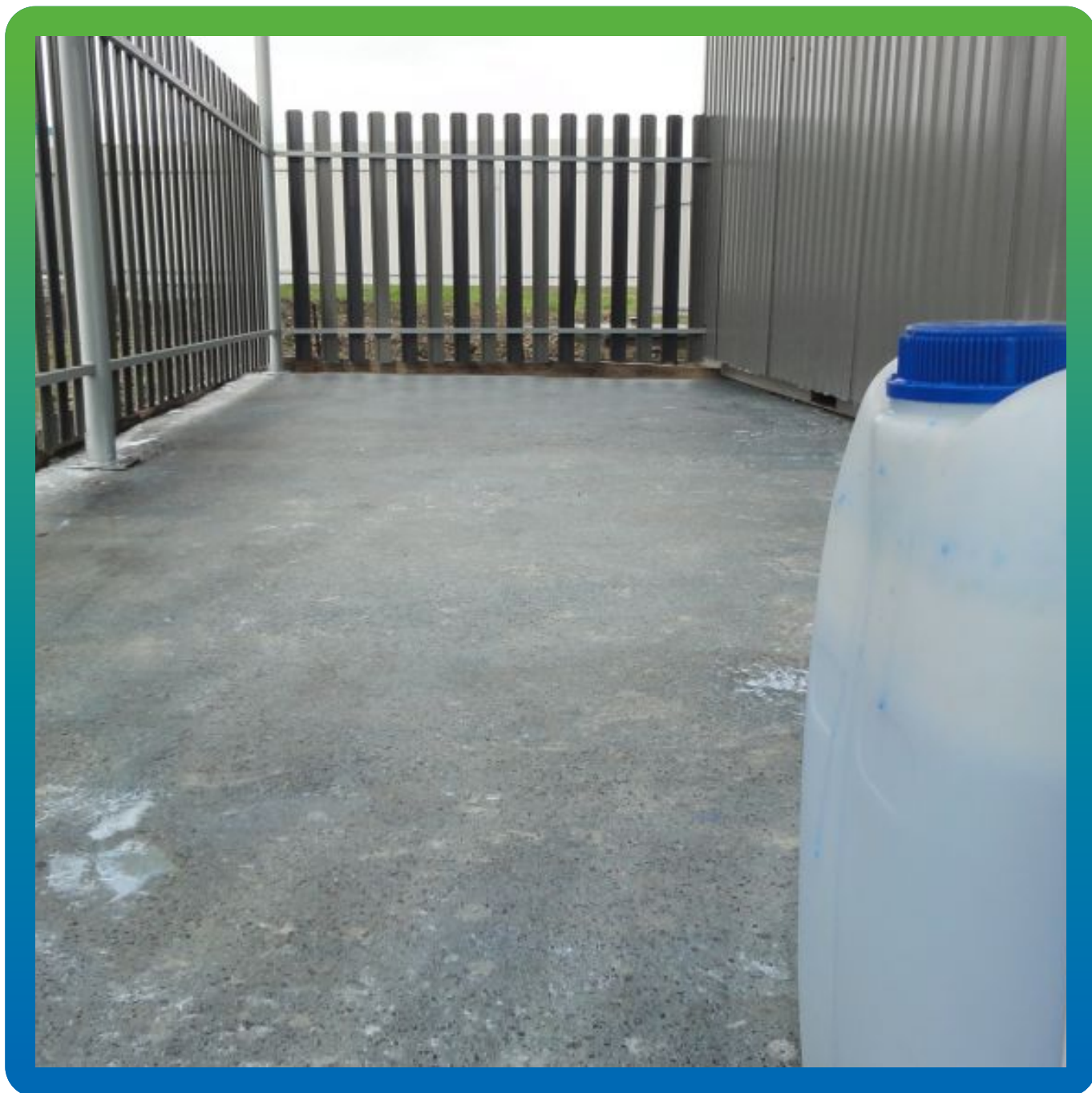
Вид загрунтованной поверхности
