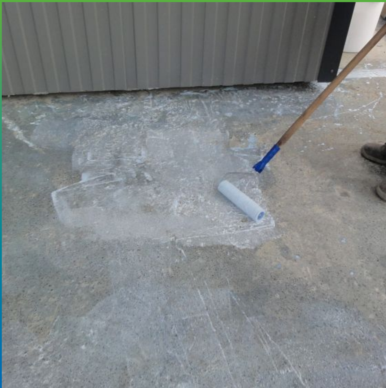
Нанесение грунтовки Манокрил Бонд
