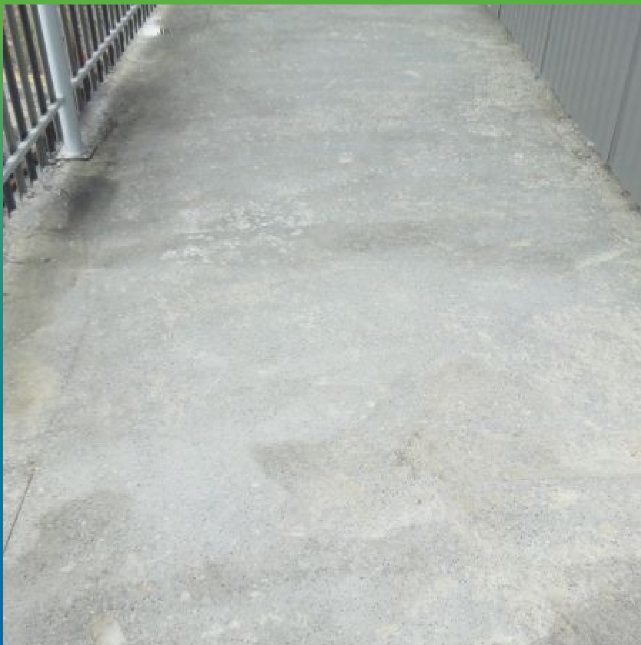
Вид подготовленного основания
