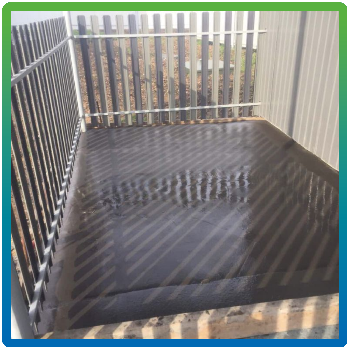
Заливка материала Стармекс Флоу
