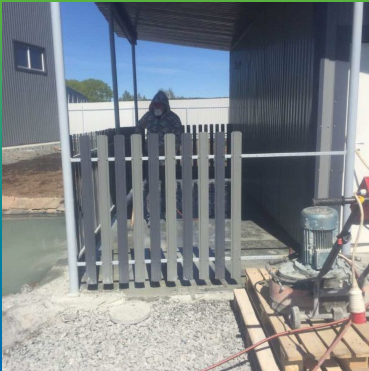
Подготовка (шлифовка) основания
