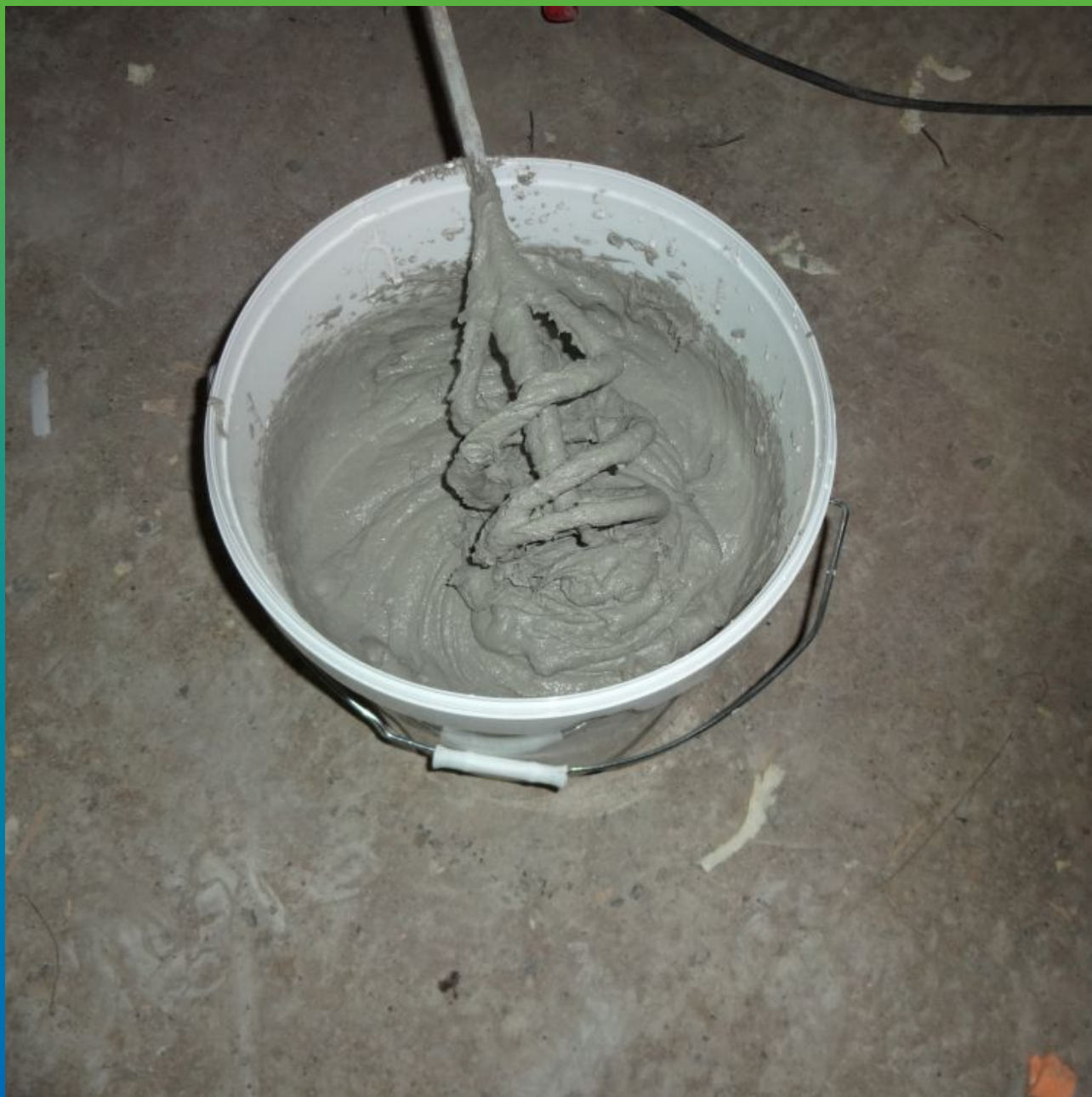
Затворение А+В компонентов полимерцементного герметика Манодил Цем
