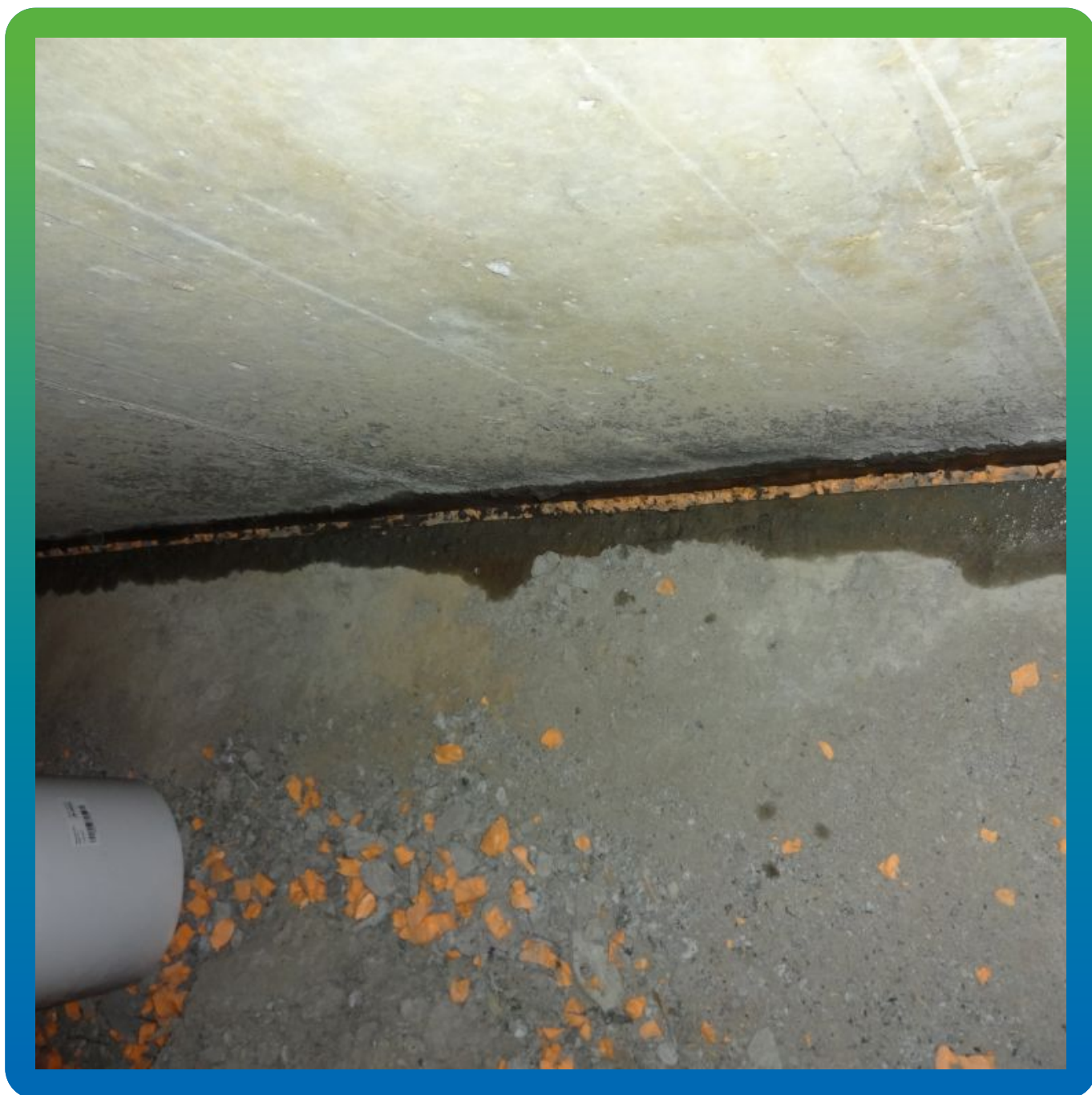
Очищение шва перед нанесением Манодил Цем
