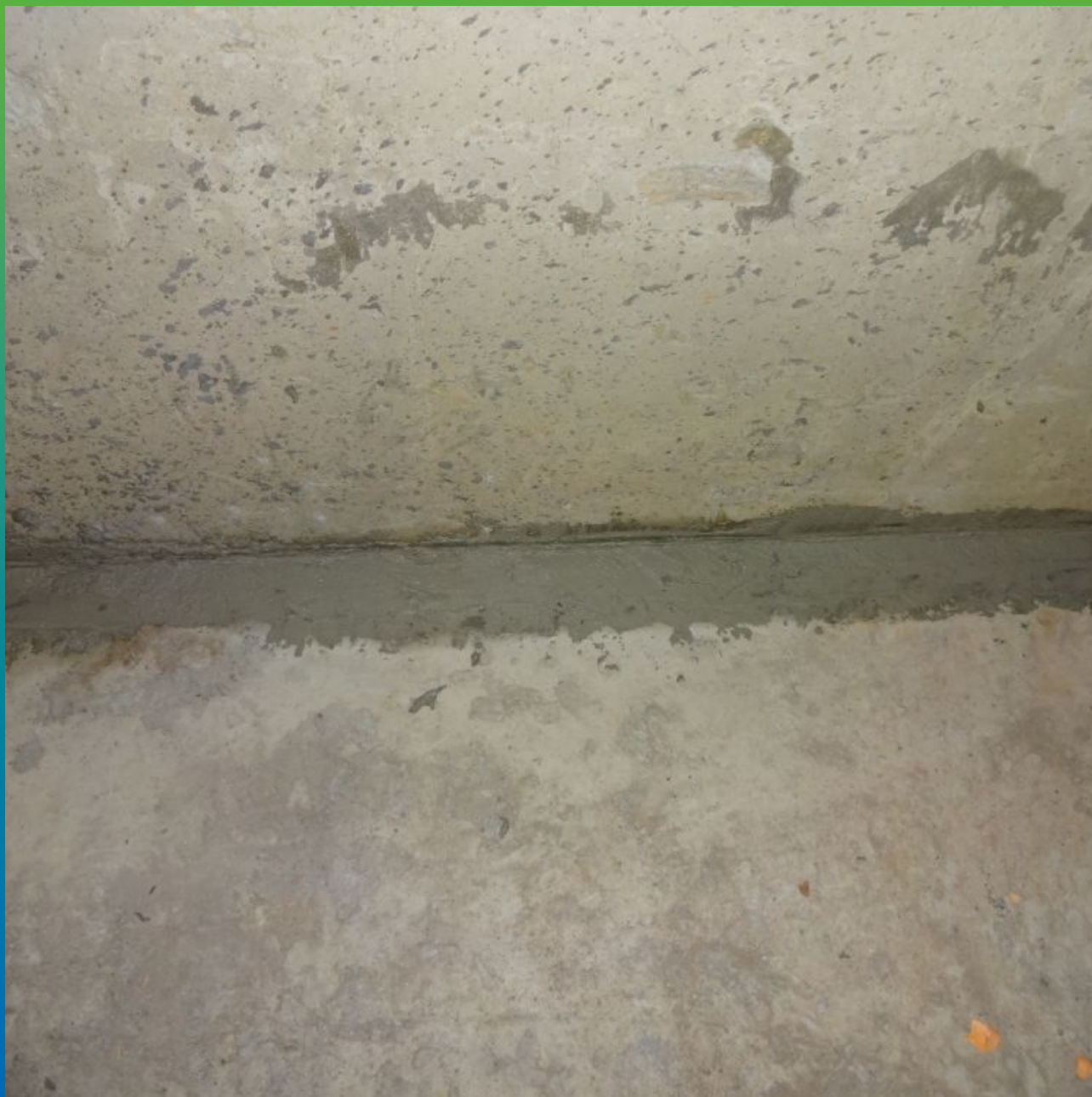
Деформационный шов после проведения работ
