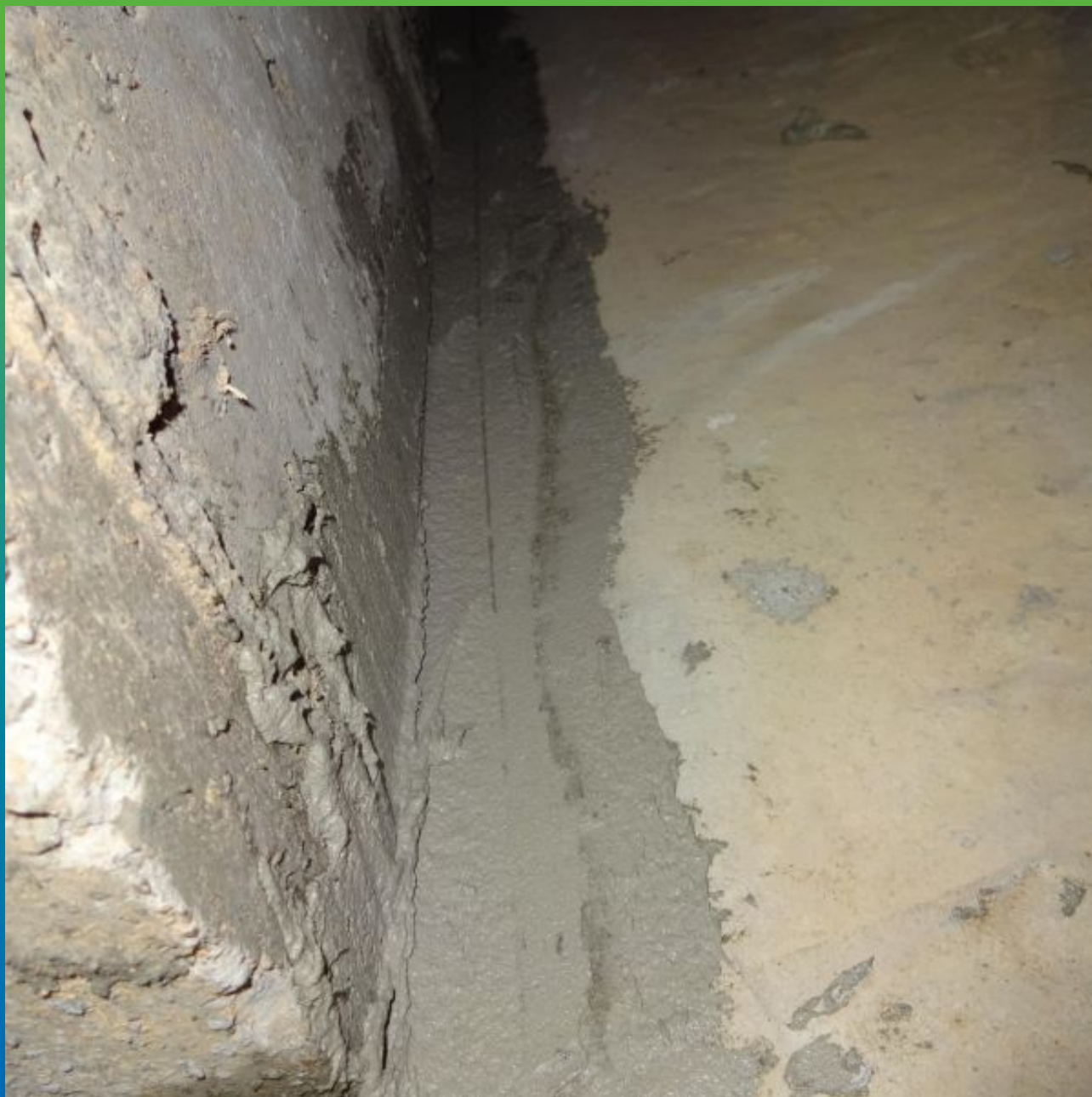
Деформационный шов после проведения работ
