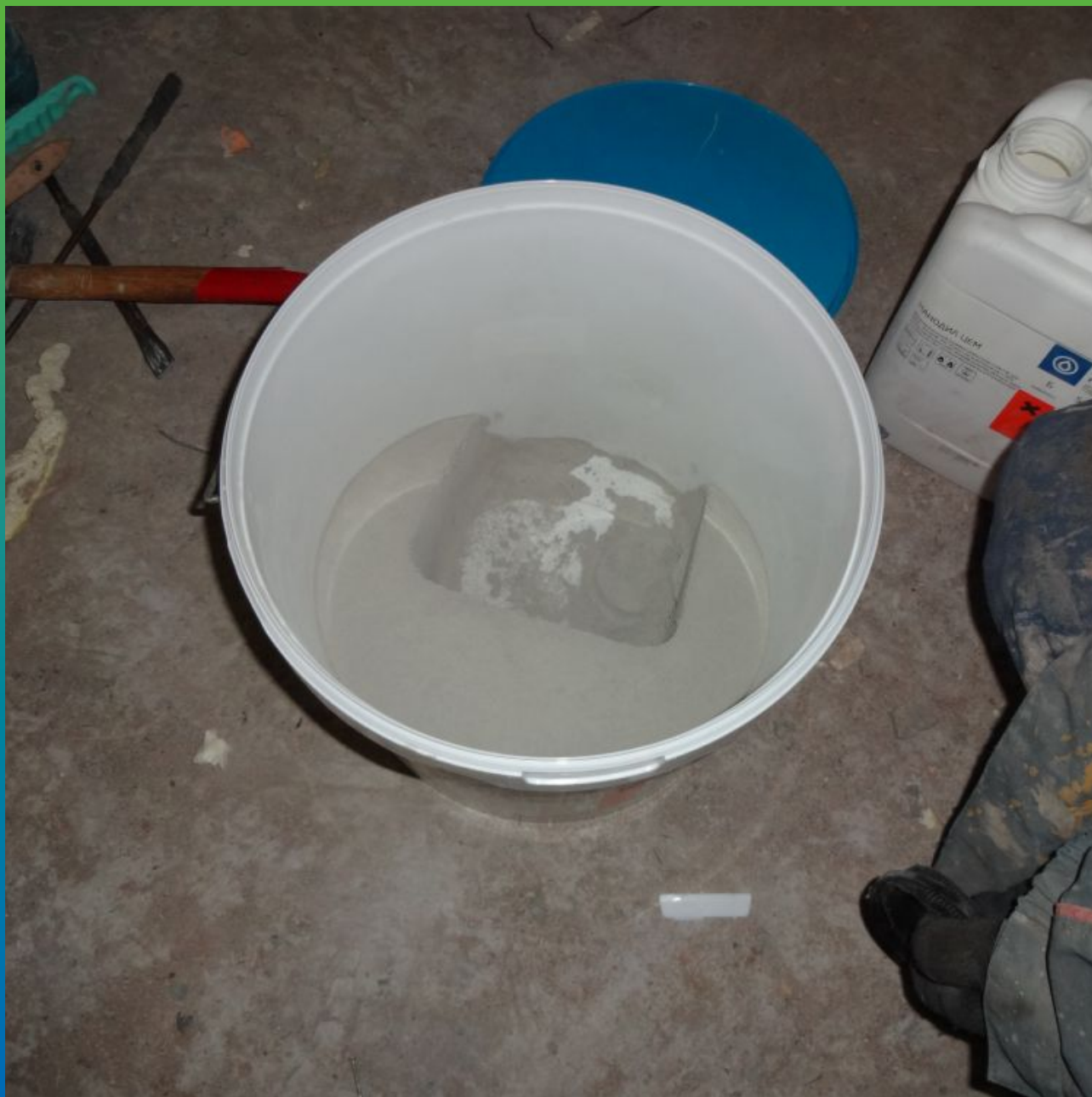
Затворение А+В компонентов полимерцементного герметика Манодил Цем
