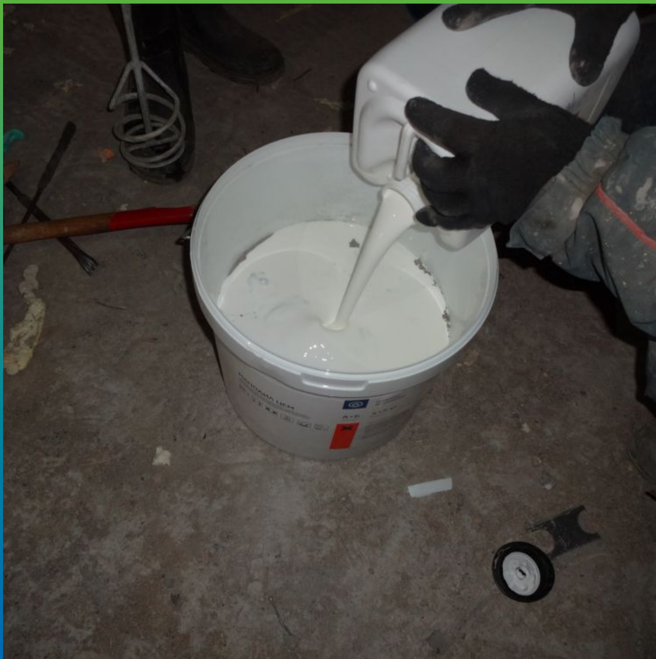
Затворение А+В компонентов полимерцементного герметика Мандил Цем
