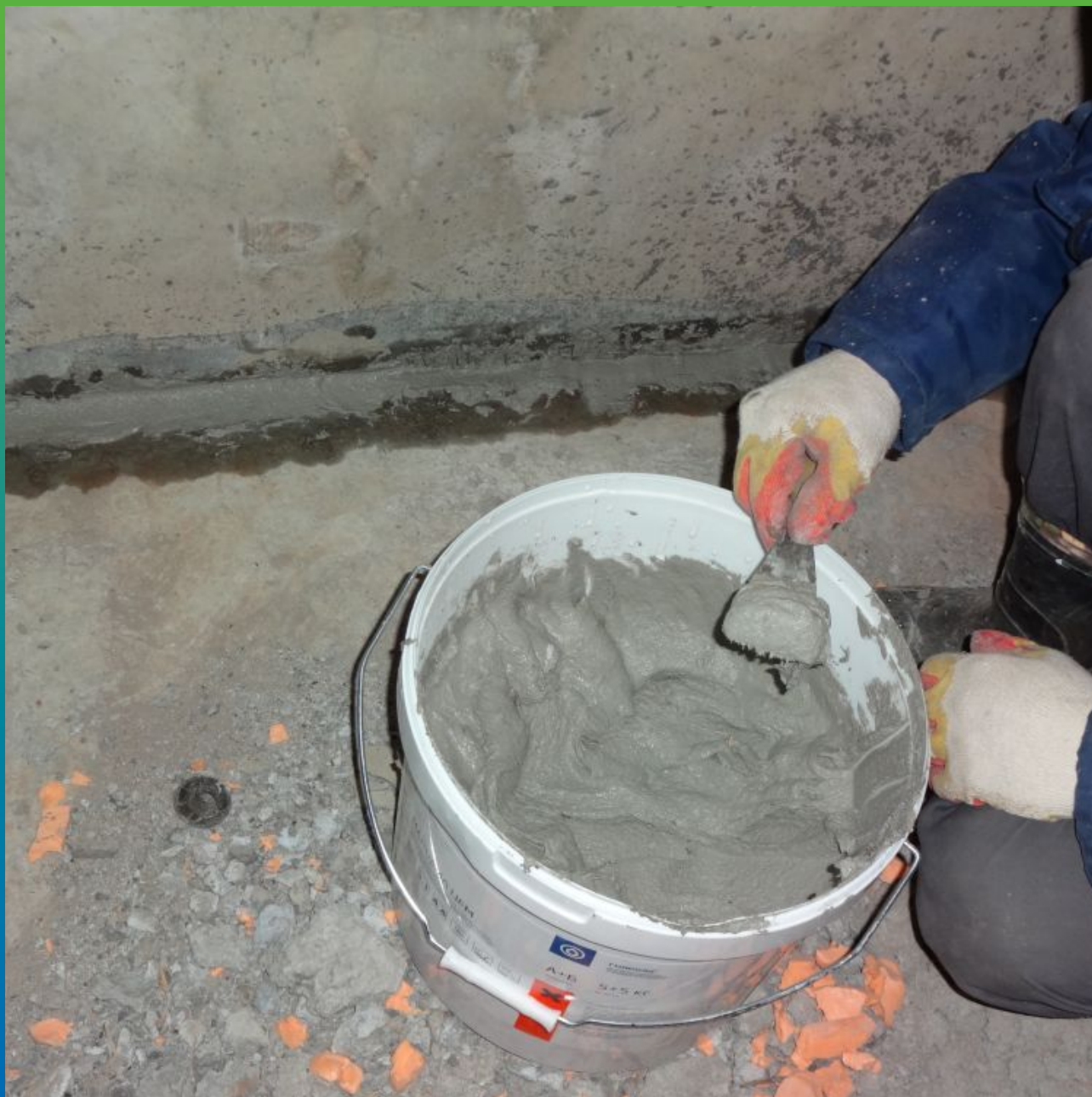
Заполнение шва полимерцементным герметиком Манодил Цем
