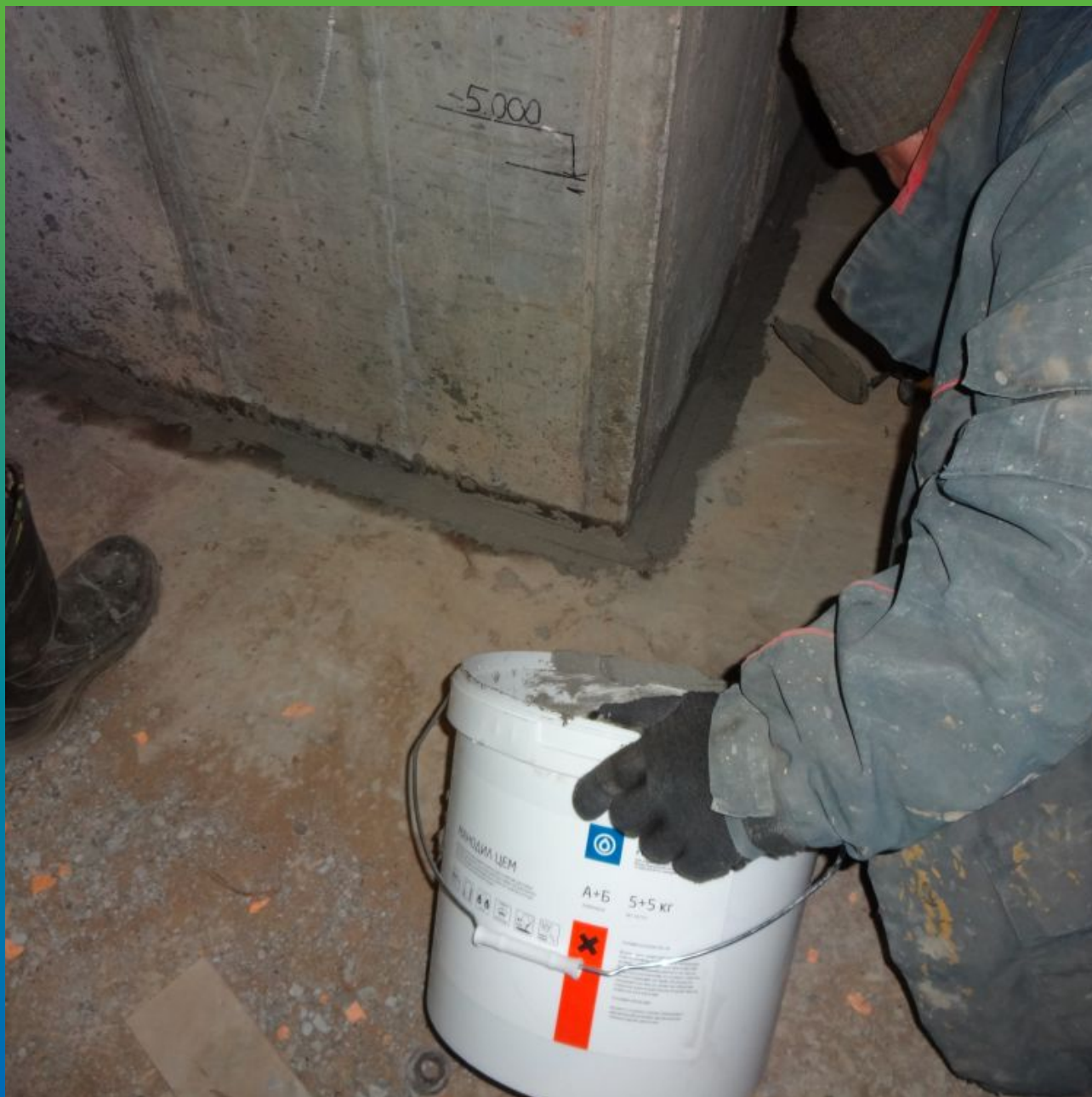
Заполнение шва полимерцементным герметиком Манодил Цем
