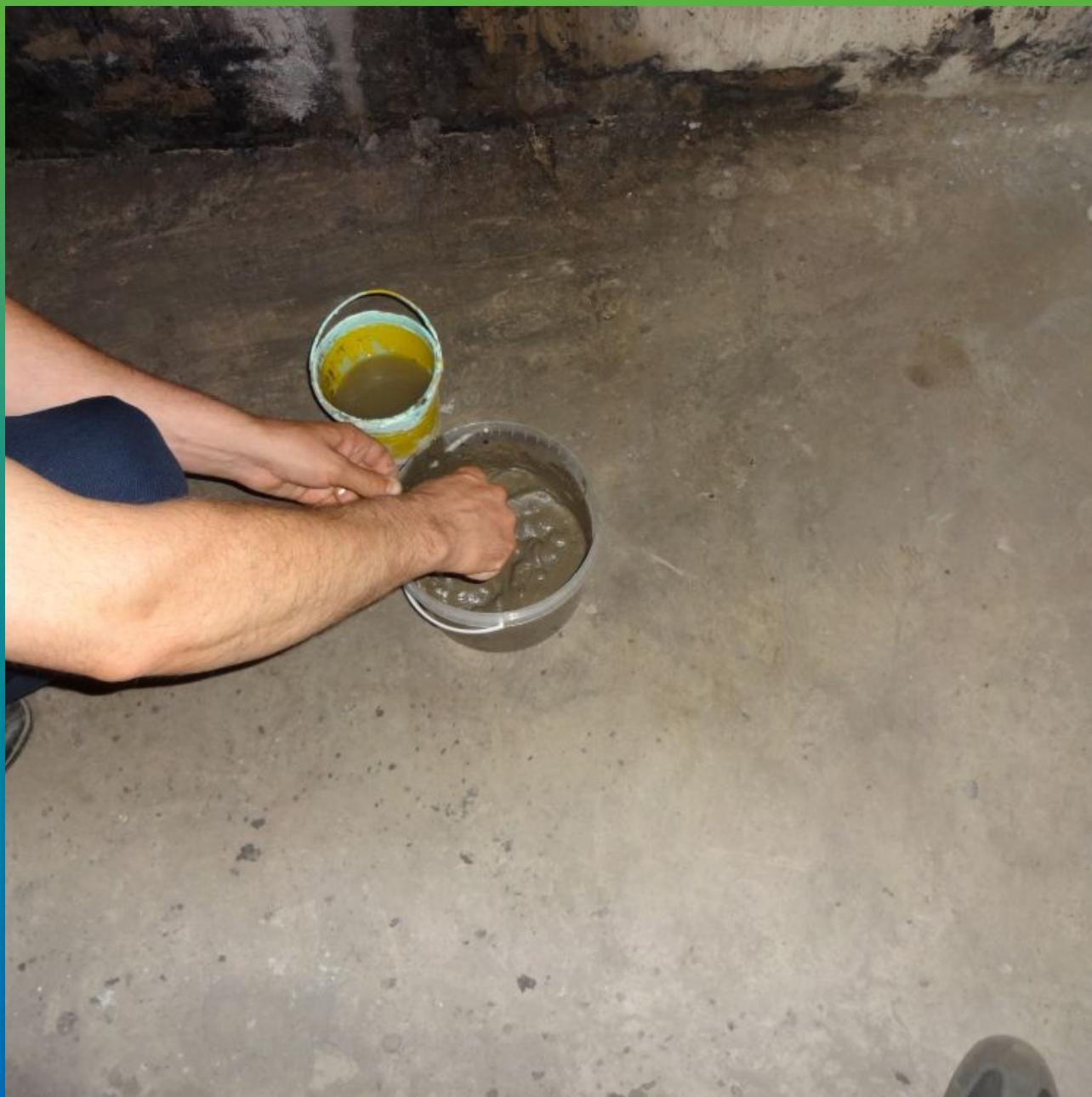
Затворение с водой гидропломбы Стармекс Плаг
