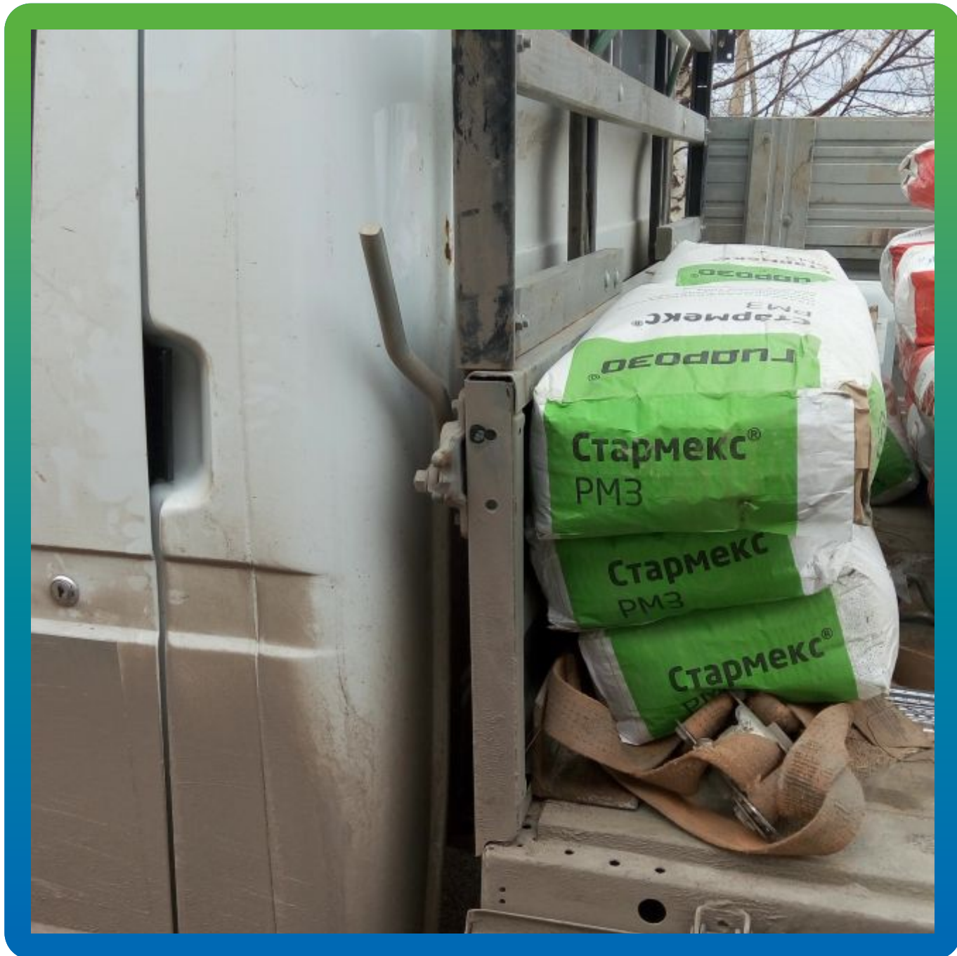
Материалы Гидрозо на объекте
