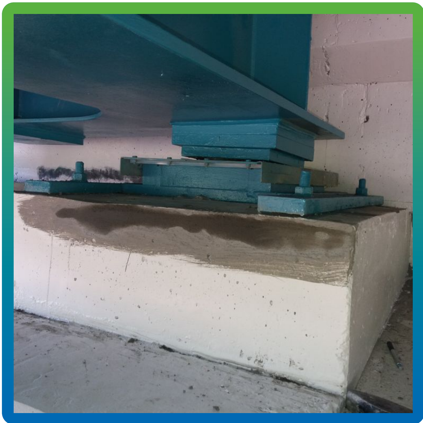
Ремонт дефектов тиксотропным ремонтным составом Стармекс РМЗ
