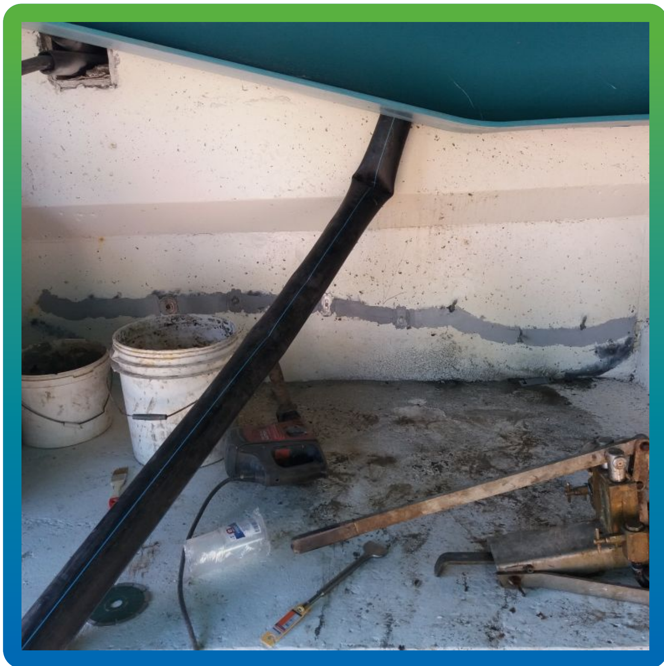
Установка адгезионных пакеров
