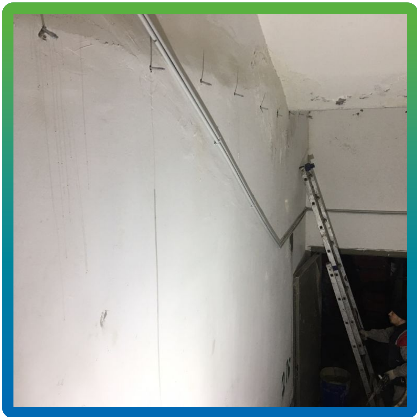
Установка пакеров протекающий в деформационный шов
