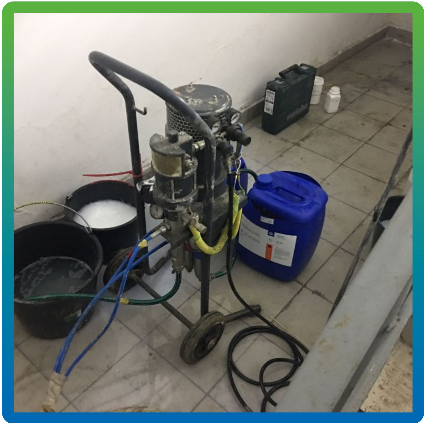
Оборудование готовое к инъектированию
