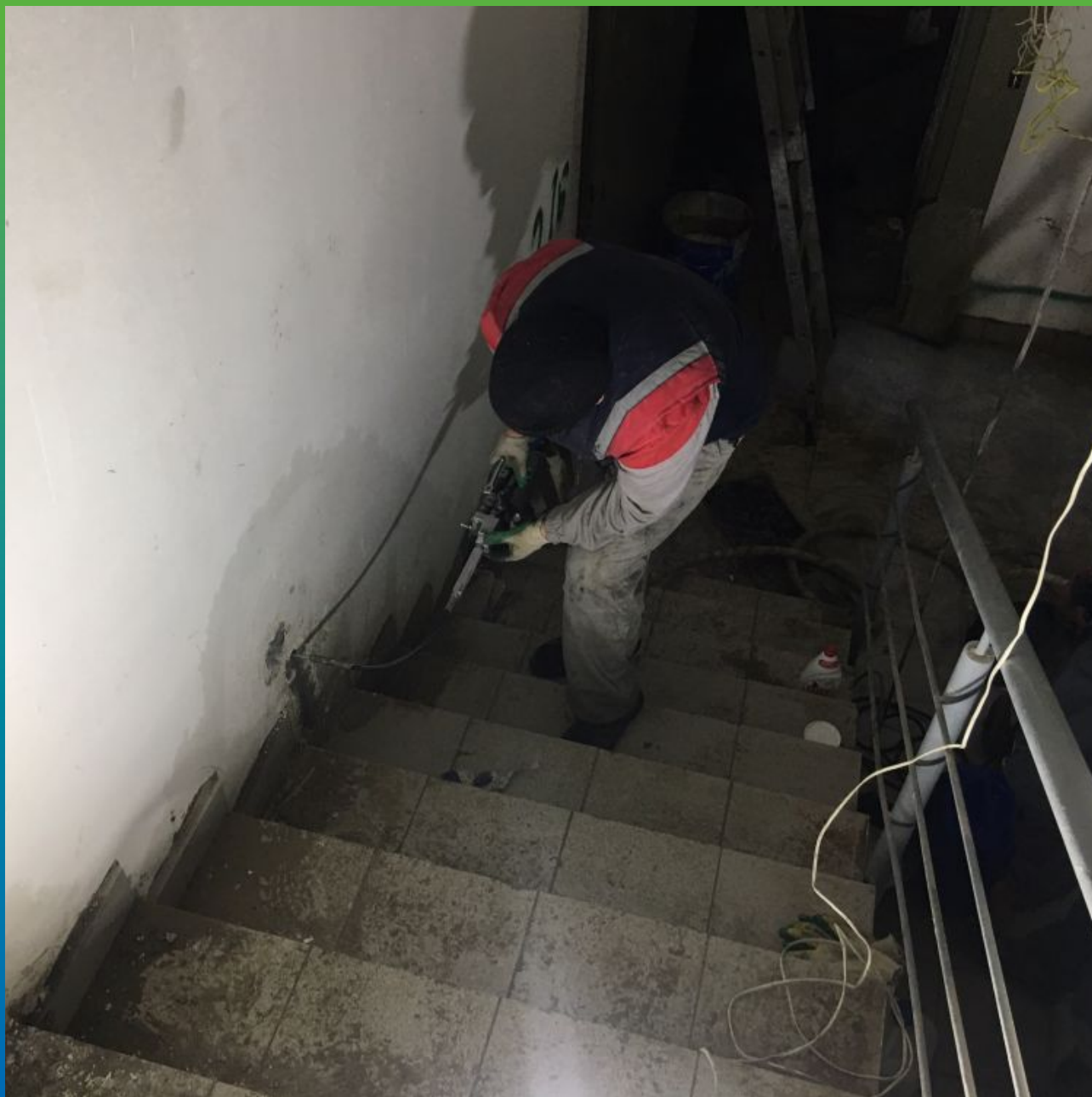
Инъектирование холодного шва акрилатным гелем Манокрил Гель В + Манокрил Флекс Тикс
