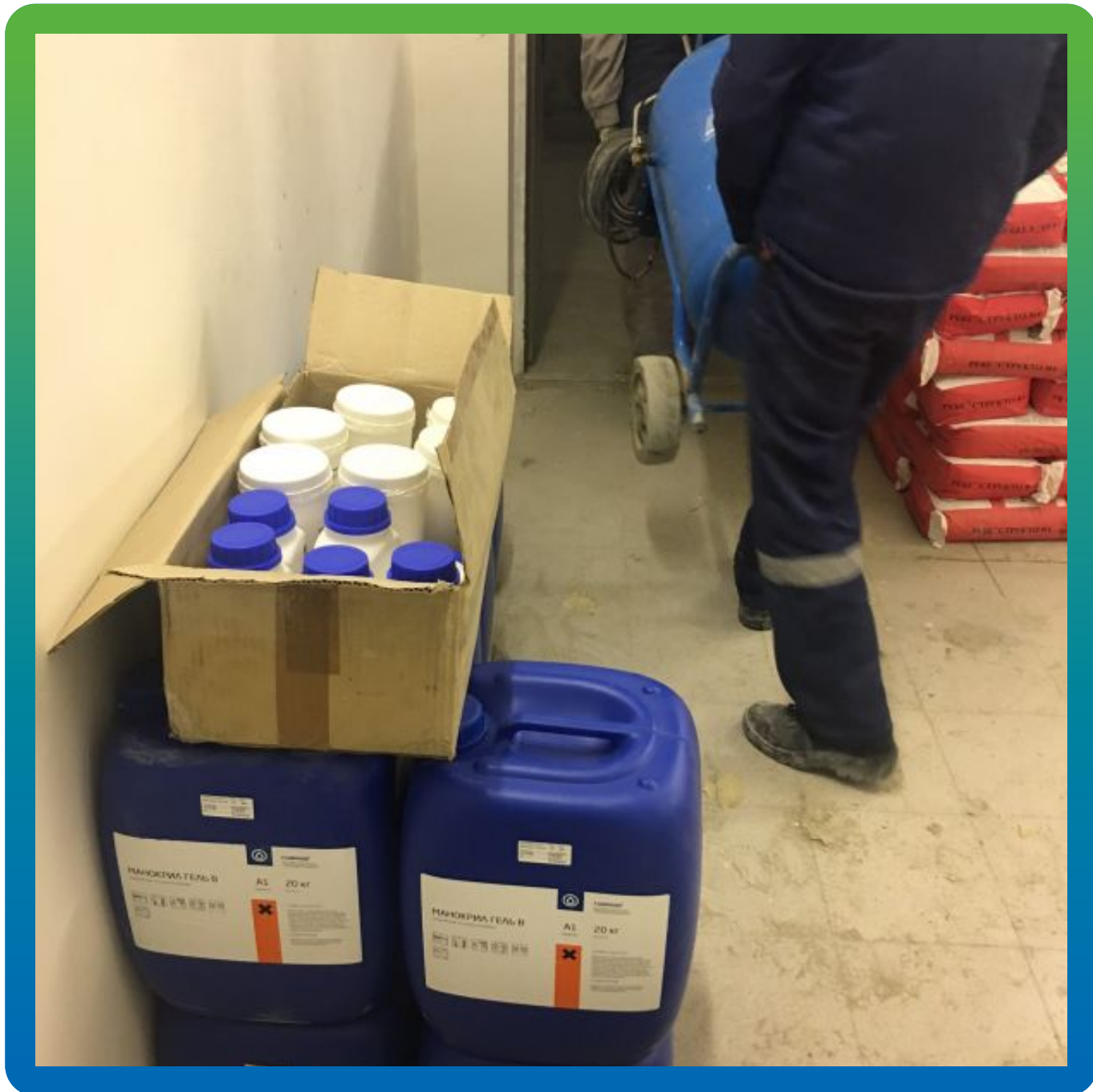
Материалы Гидрозо на объекте
