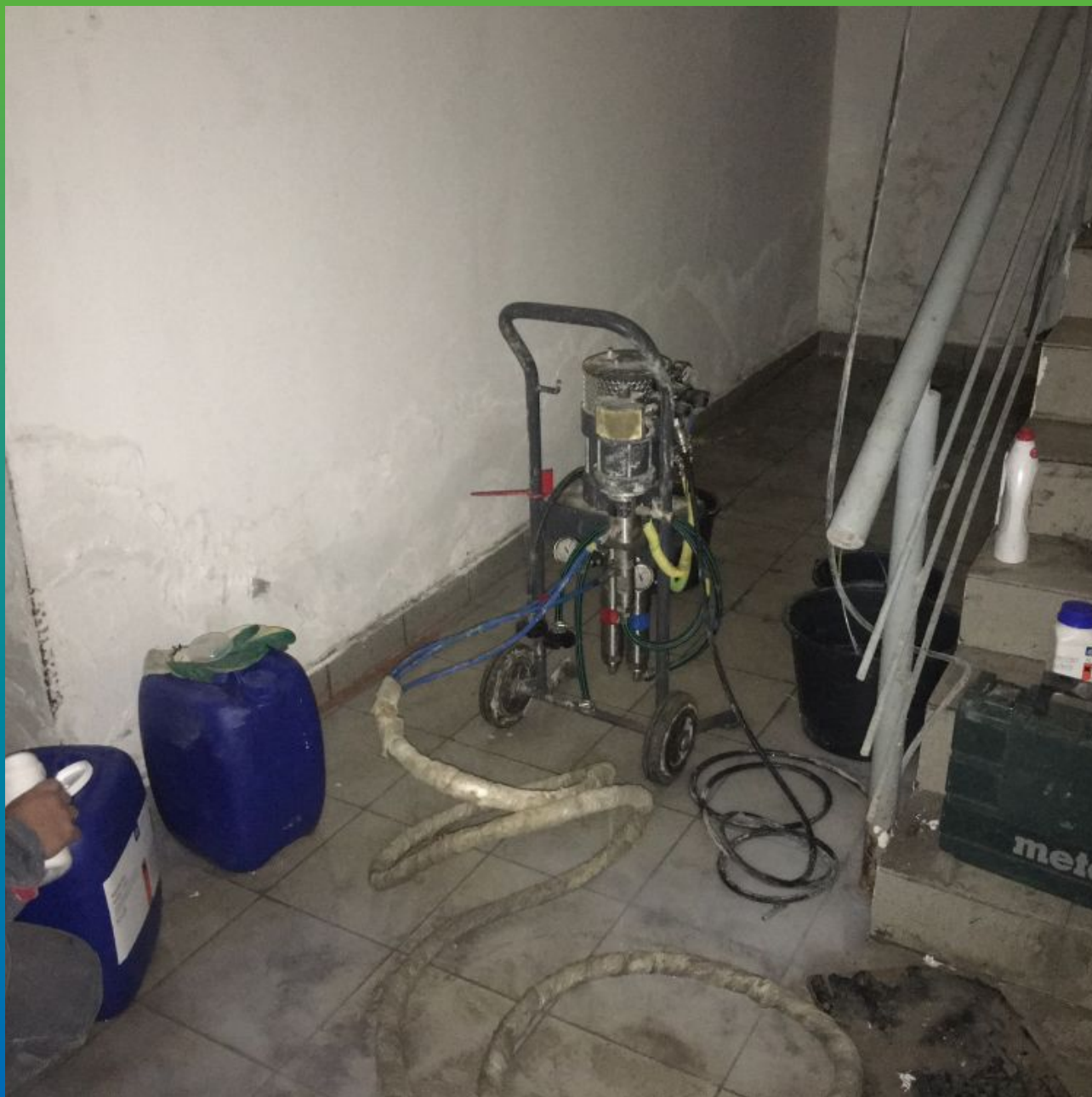
Приготовление акрилатного геля Манокрил Гель В + Манокрил Флекс Тикс
