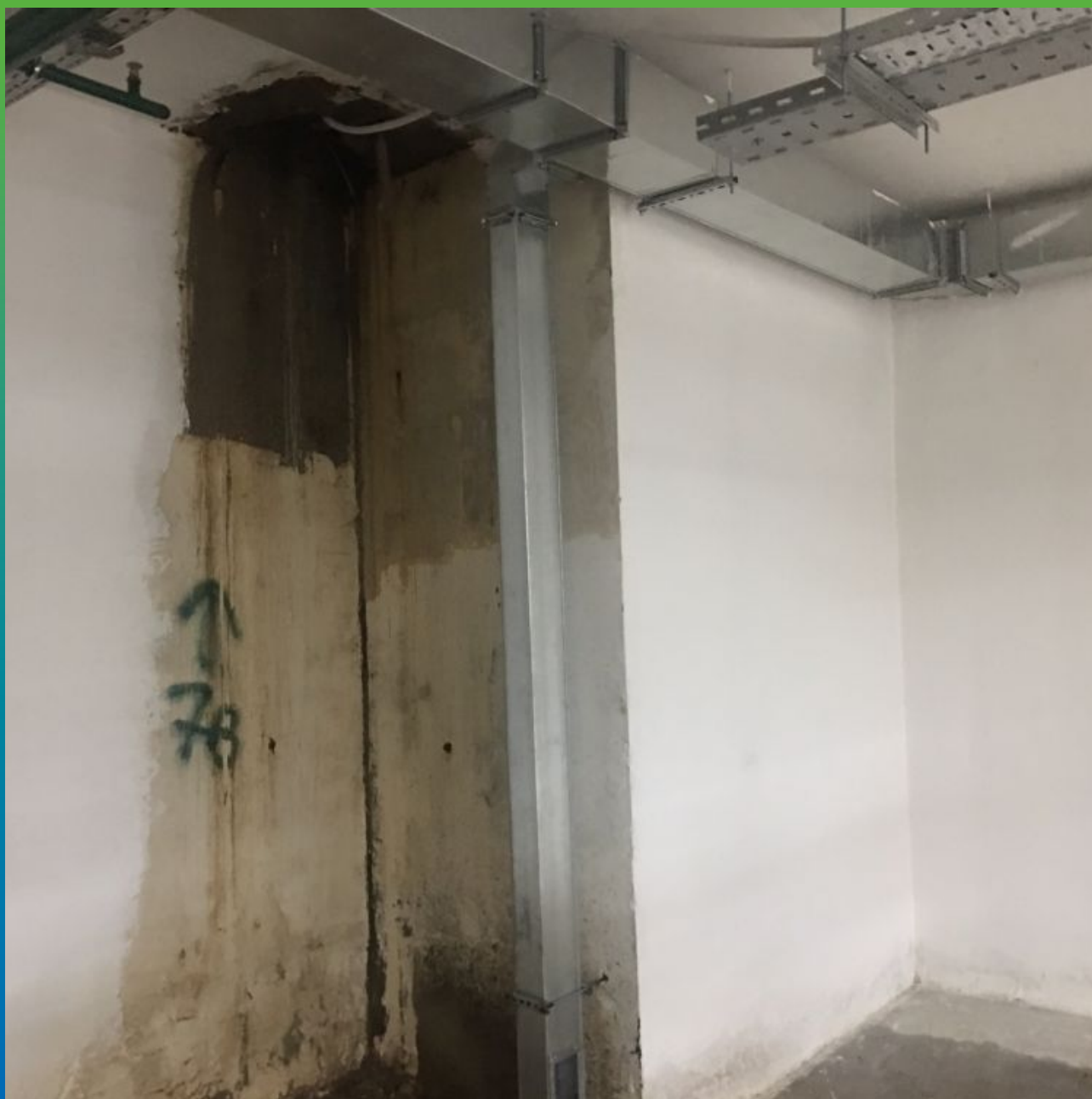
Одна из протечек на объекте
