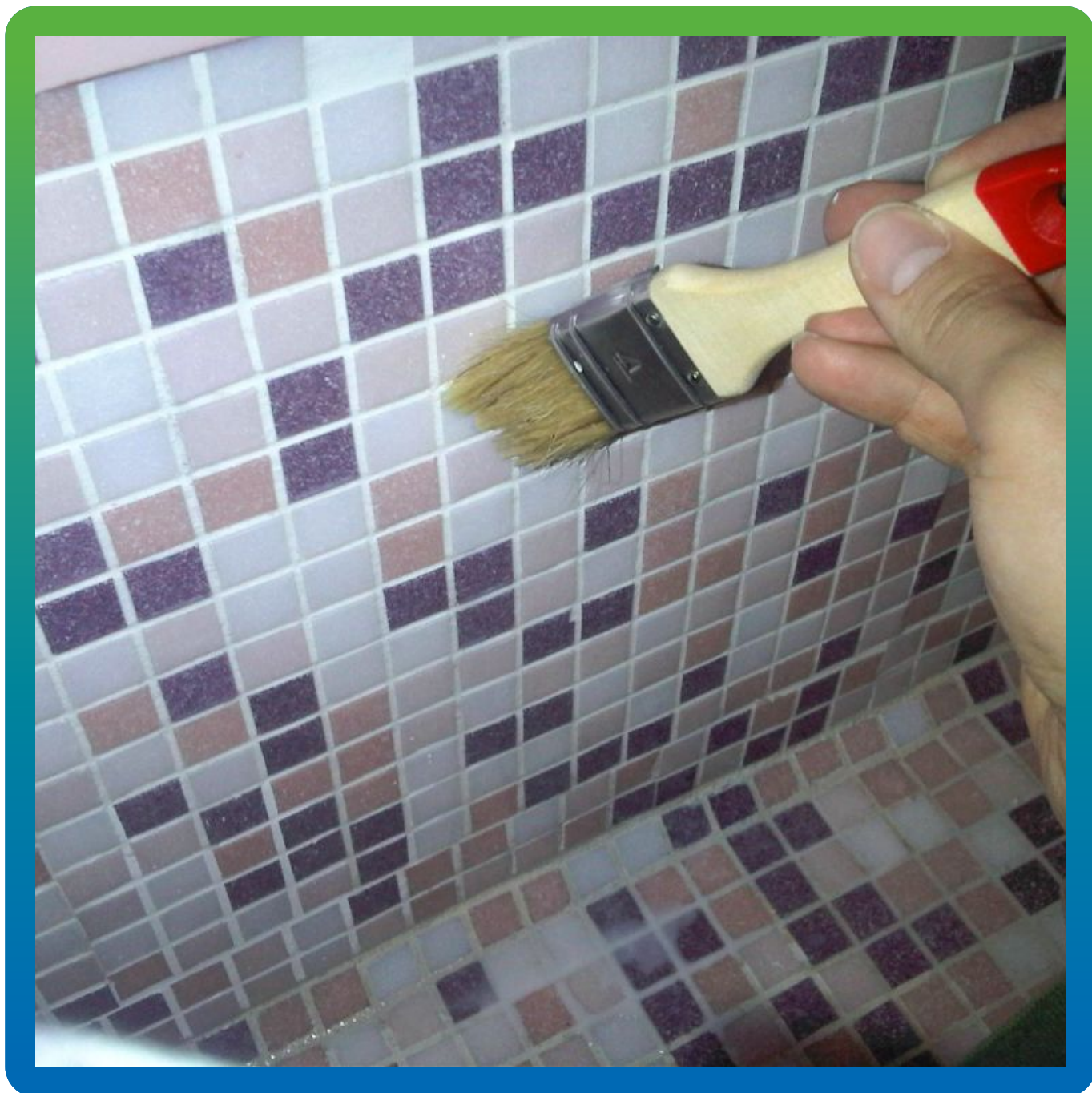
Обработка швов затирки гидрофобизатором Маногард 237
