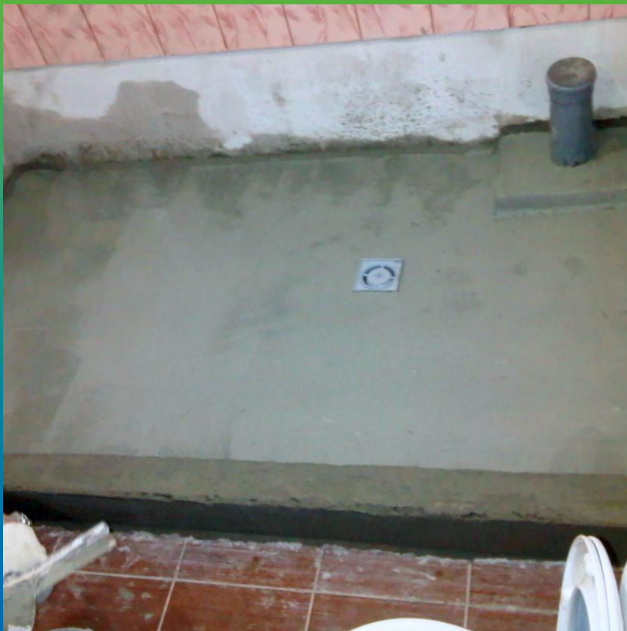
Общий вид смонтированной гидроизоляции.
