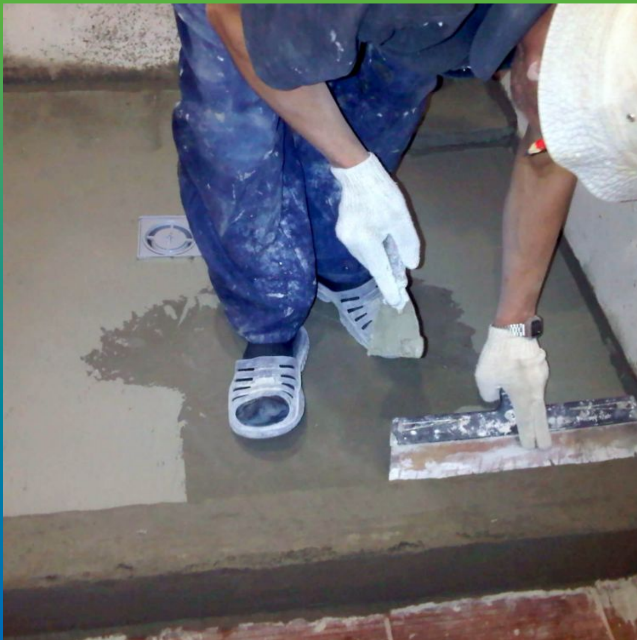
Завершение монтажа гидроизоляции
