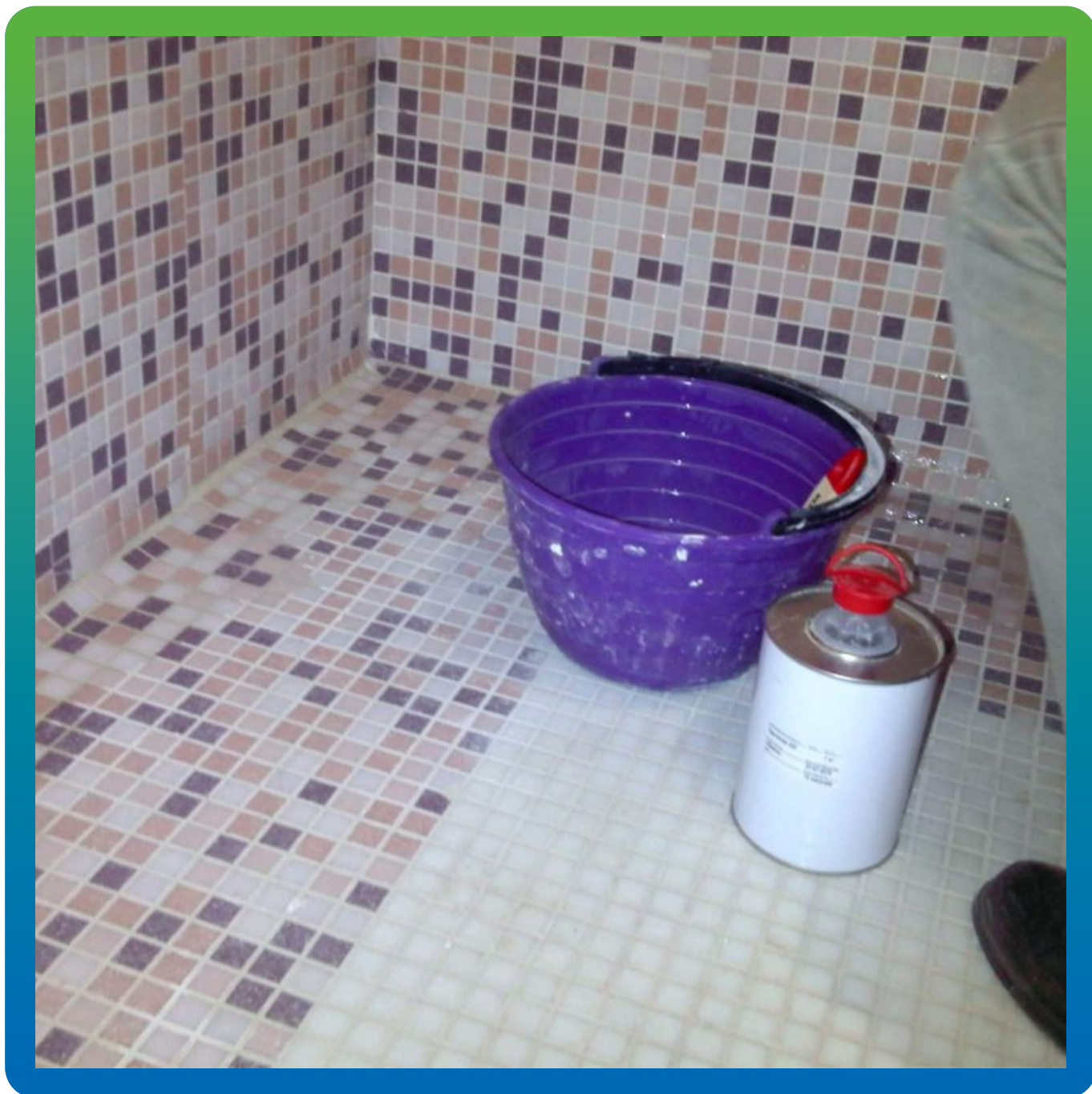
Нанесение защиты шва гидрофобизатором Маногард 237
