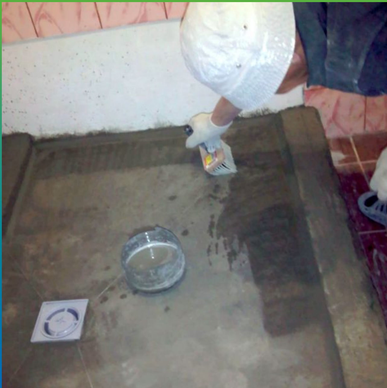
Подготовка основания, выравнивание, напытывание водой.
