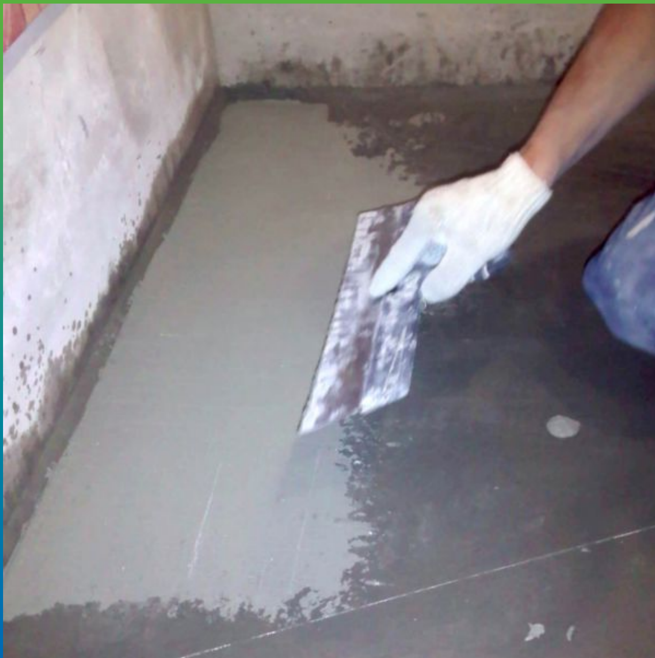
Укладка материала, вариант шпателем
