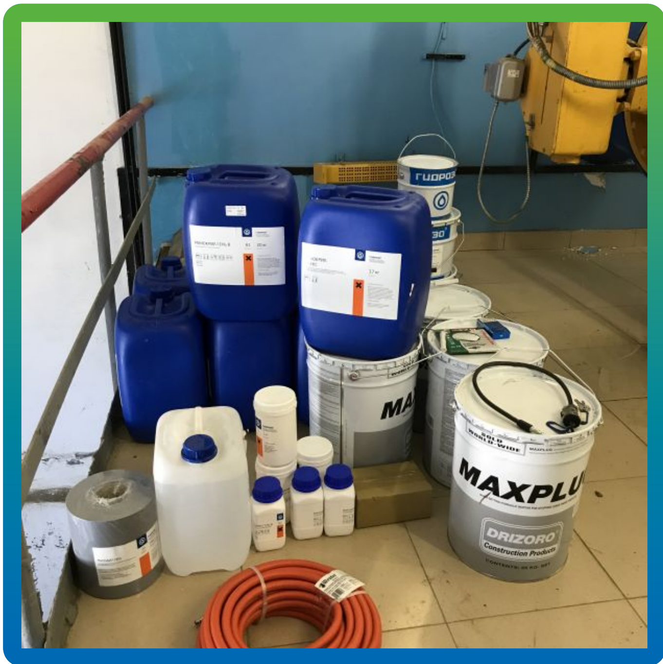
Материалы Гидрозо на объекте
