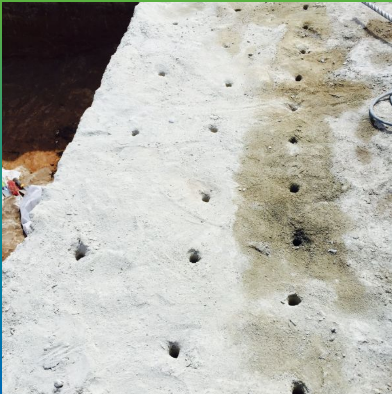
Бурение каналов для последующей заливки Максдинамит Цемент
