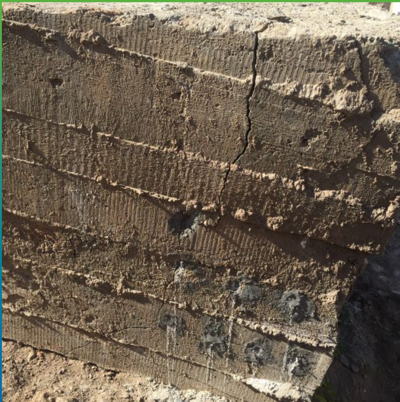
Разрушение после 17 часов
