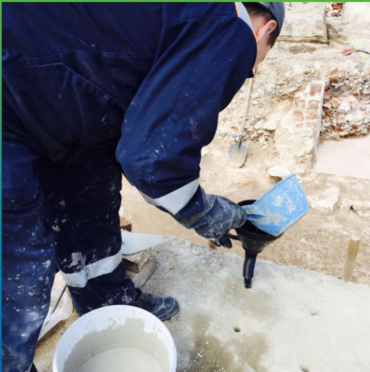
Заливка состава в шпуры
