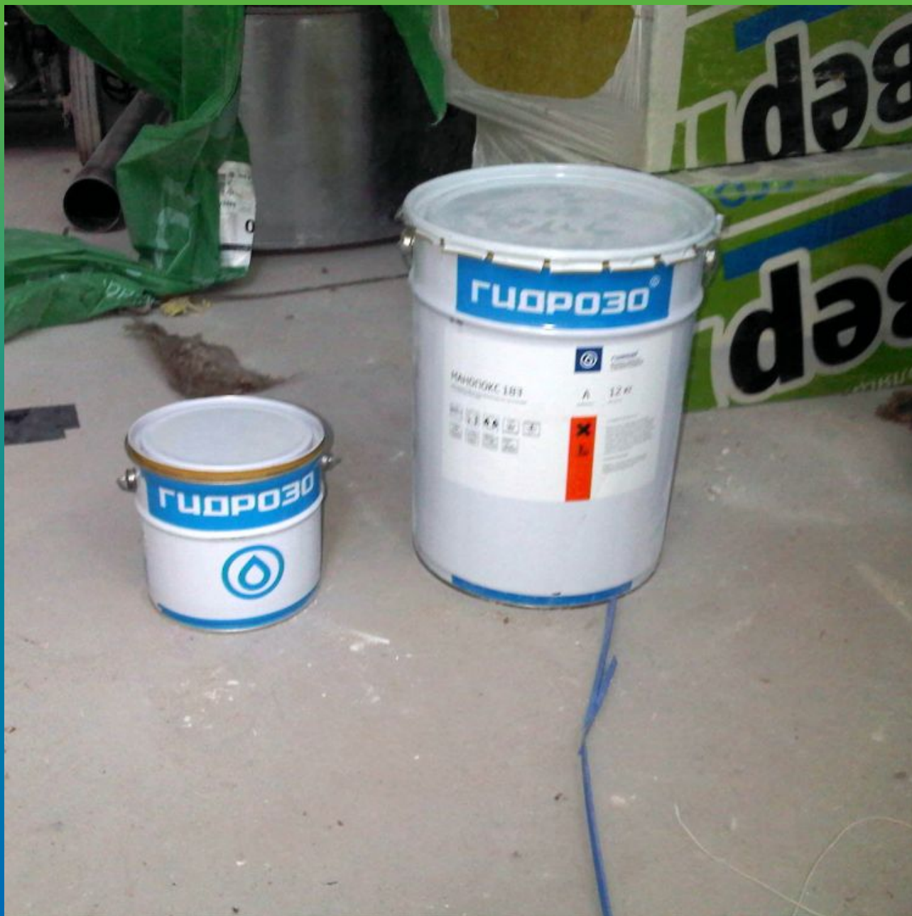
Материалы Гидрозо на объекте
